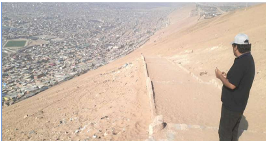
Fotografía 5 – Vista de vía de acceso peatonal con escalinatas de piedra que conecta las asociaciones de vivienda de la zona urbana
