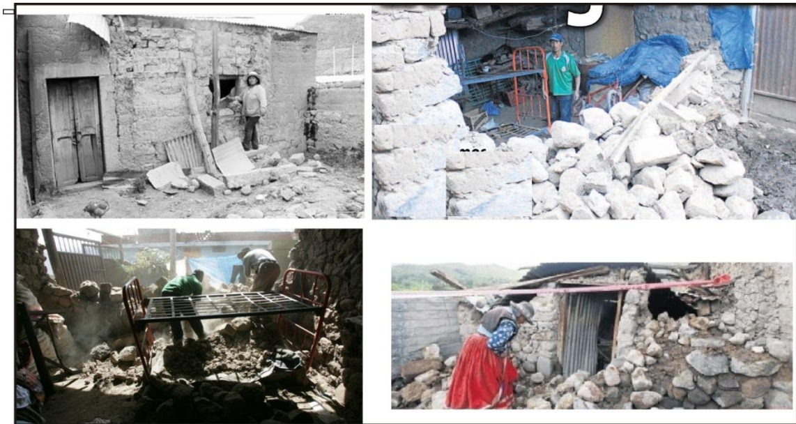
Figura 13. Viviendas afectadas por el sismo de Huambo. Obsérvese el tipo de material utilizado y la calidad de deterioro de las viviendas (Fotos: Diario Correo y Perú21).
