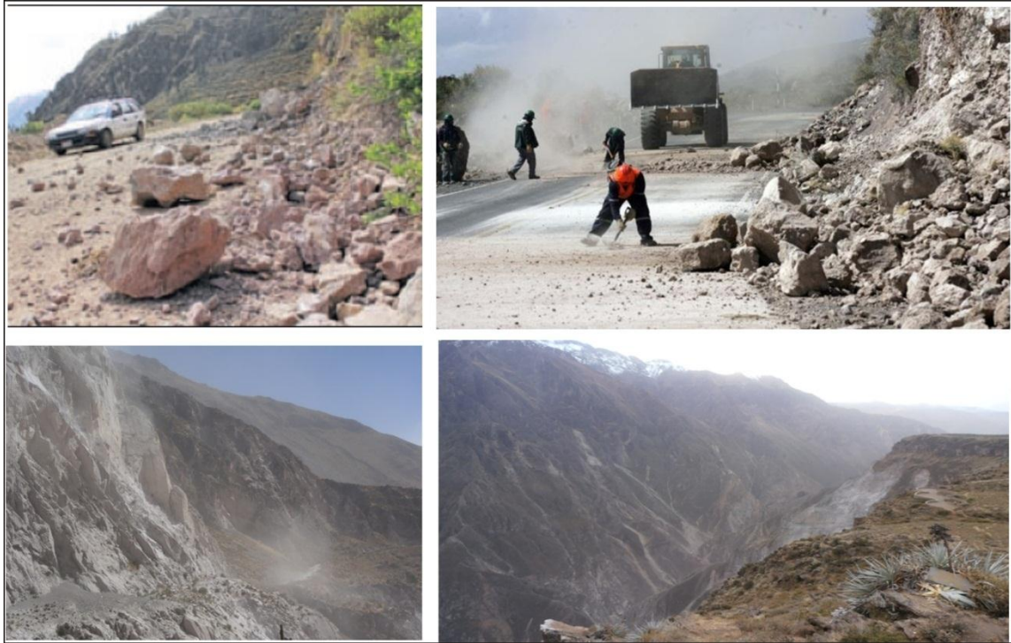
Figura 15: Principales deslizamientos de tierra y piedras en varios tramos de las carreteras de Arequipa a Huambo y Maca (Fotos: Diario Correo y J.C. Gomez)
