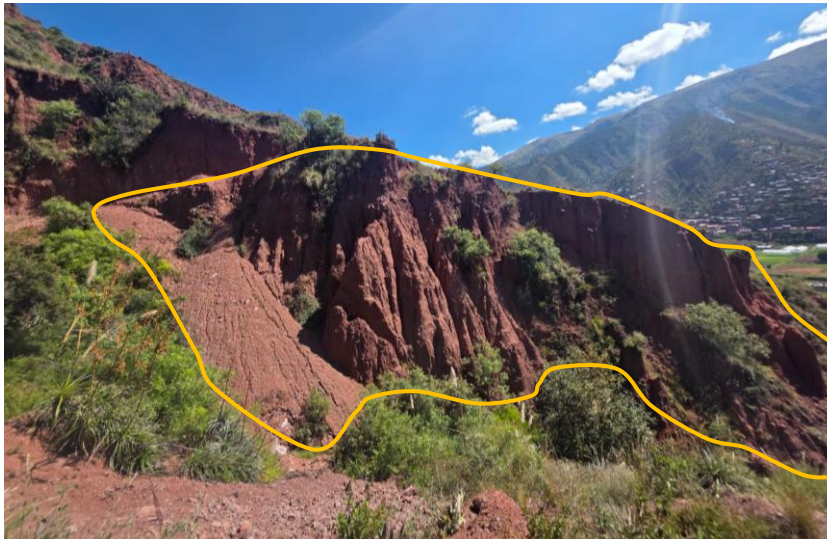
FOTOGRAFÍA 8: VERTIENTE COLUVIO-DELUVIAL EN EL SECTOR DE MOLLEMOLLEYOC
