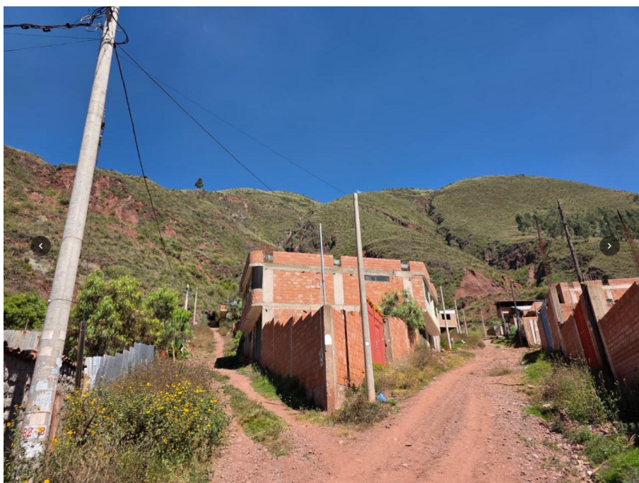
FOTOGRAFÍA 33: VÍAS DE LA APV. MAJEÑOS DE LA SANTÍSIMA CRUZ SIN SISTEMAS DE DRENAJE PLUVIAL, POR DONDE DISCURREN LAS AGUAS PROVENIENTES DE LAS QUEBRADAS UBICADAS EN LA PARTE ALTA.
