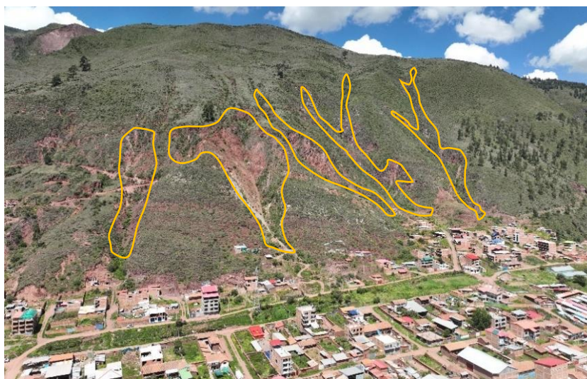
FOTOGRAFÍA 13: CARCAVAMIENTO EN EL SECTOR DE MOLLEMOLLEYOC
