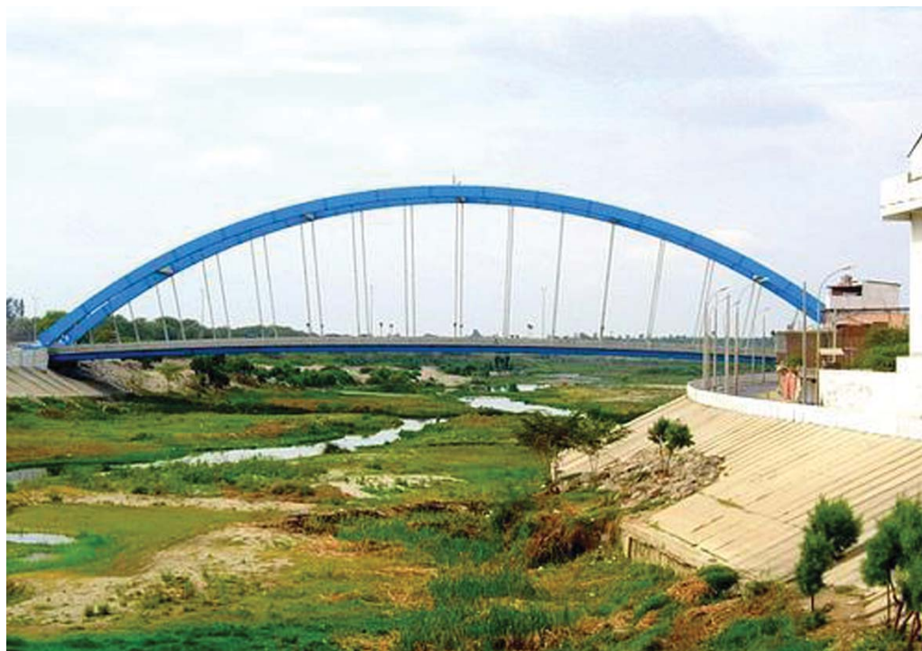
Fotografía 6.56 Vista del puente Bolognesi, se observa los muros de concreto colocados en las márgenes del río
