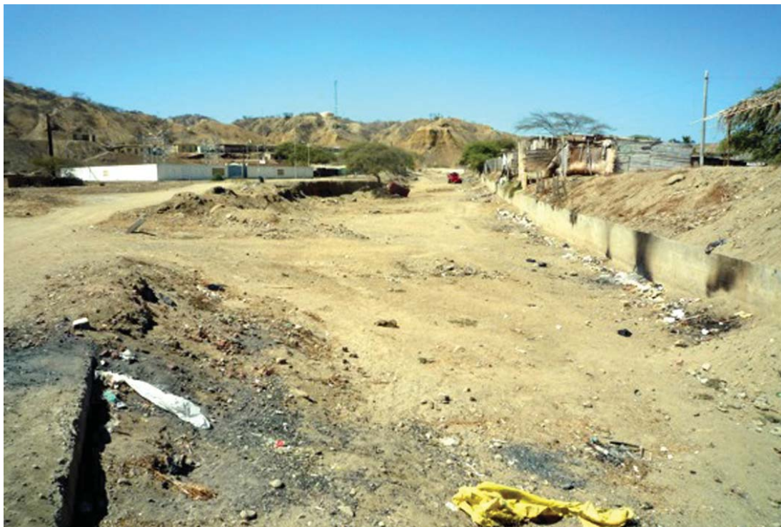
Fotografía 6.16 Flujo de lodo en quebrada Camal, se ha colocado un muro de contención en la margen izquierda para evitar erosión fluvial. Distrito de Mancora, provincia de Talara
