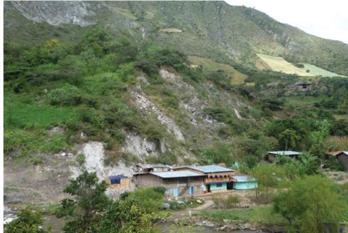
Fotografía 6.46 Caída de rocas en el sector de la Perla-Huancabamba
