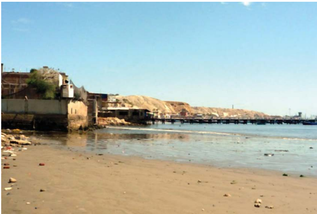
Fotografía 6.33 Puerto de Paita, erosión marina afecta estructuras del muelle y viviendas que se encuentran a pocos metros del mar, distrito y provincia de Paita.
