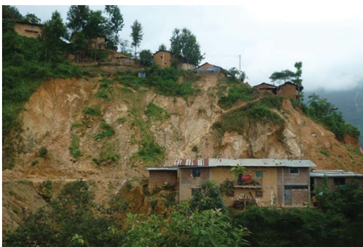
Fotografía 6.49 (a) Carretera San Miguel del Faique-Huarmaca, afectada por flujos de detritos (huaycos) que discurren por la quebrada San Antonio; (b) y (c) Viviendas del poblado de Higuerón, comprometidas por deslizamientos activos
