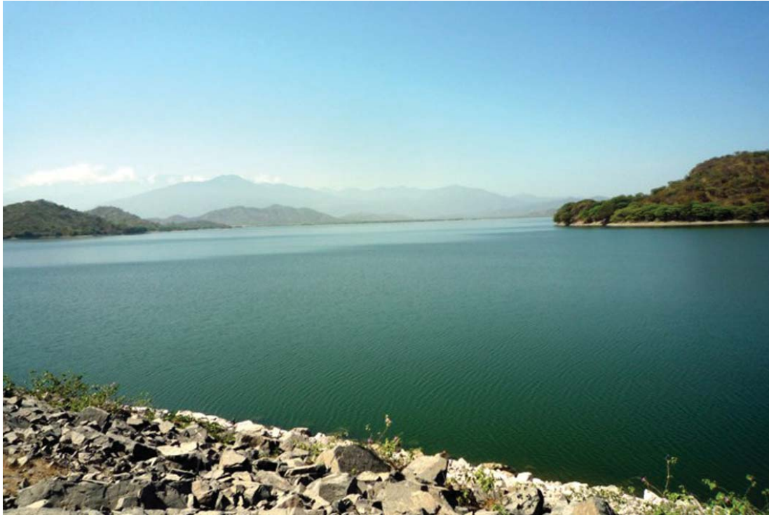
Fotografía 5.35 Vaso de la presa de San Lorenzo, distrito de Las Lomas, Piura, agosto de 2009
