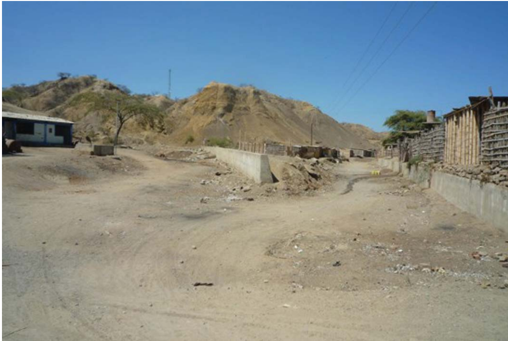
Fotografía 6.69 Quebrada Camal, tramo encauzado en el sector de Mancora
