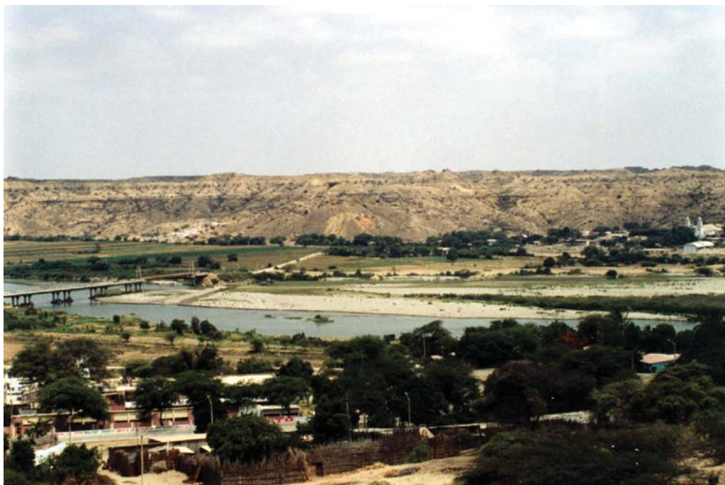
Fotografía 6.52 Vista panorámica del valle del río Chira entre los distritos de Amotape (margen derecha) y El Arenal (margen izquierda), afectados por inundaciones y erosión fluvial que hicieron colapsar el puente Simón Rodríguez, actualmente habilitado solo para el tránsito peatonal
