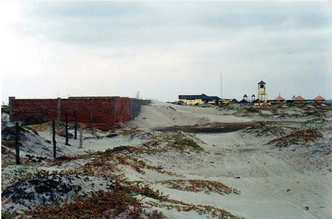
Fotografía 6.34 Arenamiento en la avenida Costanera del poblado de La Esmeralda-Colán, provincia de Paita. La arena se acumula sobre las paredes de las viviendas
