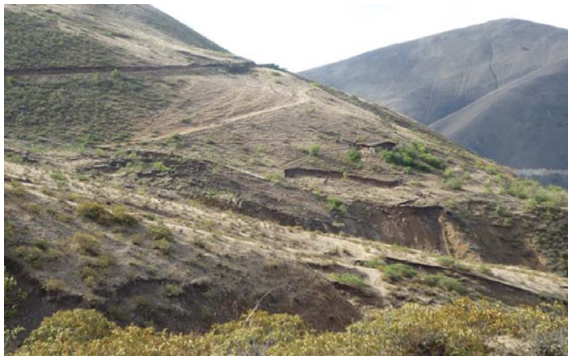
Fotografía 6.61 Sector Las Pampas, donde se presenta un deslizamiento-flujo de gran magnitud, reactivado con deslizamientos en el cuerpo, que puede afectar viviendas
