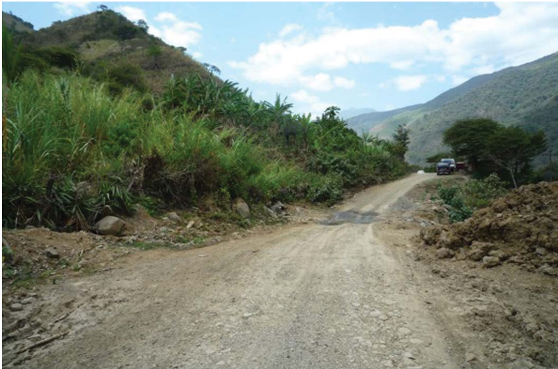
Fotografía 6.40 Deslizamiento que compromete la carretera hacia Montero, sector Las Viudas
