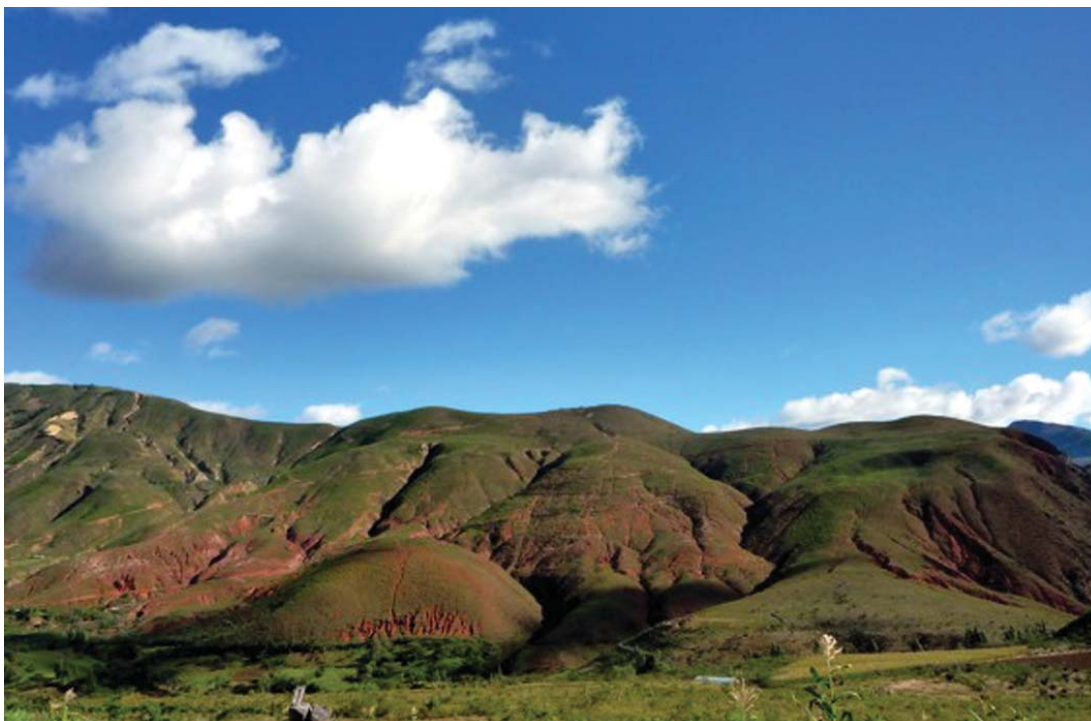
Fotografía 6.37 Cerro Tortero, cortado por surcos y cárcavas, que afectan al poblado de Tacarpo y la carretera de acceso al poblado de Tuluze. Distrito de Sondor, provincia de Huancabamba
