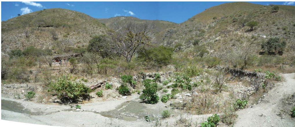
Fotografía 6.60 Carretera Aranza-El Puerto-Pacaypampa, se presentan gran cantidad de cárcavas y torrenteras por donde discurren flujos de detritos, que interrumpen el tránsito
