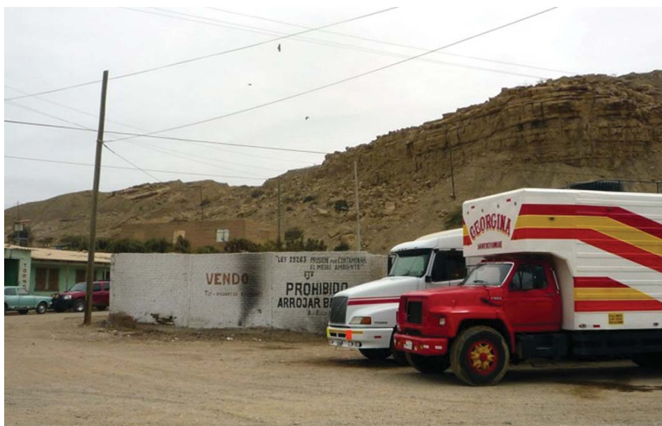
Fotografía 6.2 Caída de rocas desde acantilados de areniscas poco consolidadas en el sector de Pariñas, distrito de Talara, región Piura
