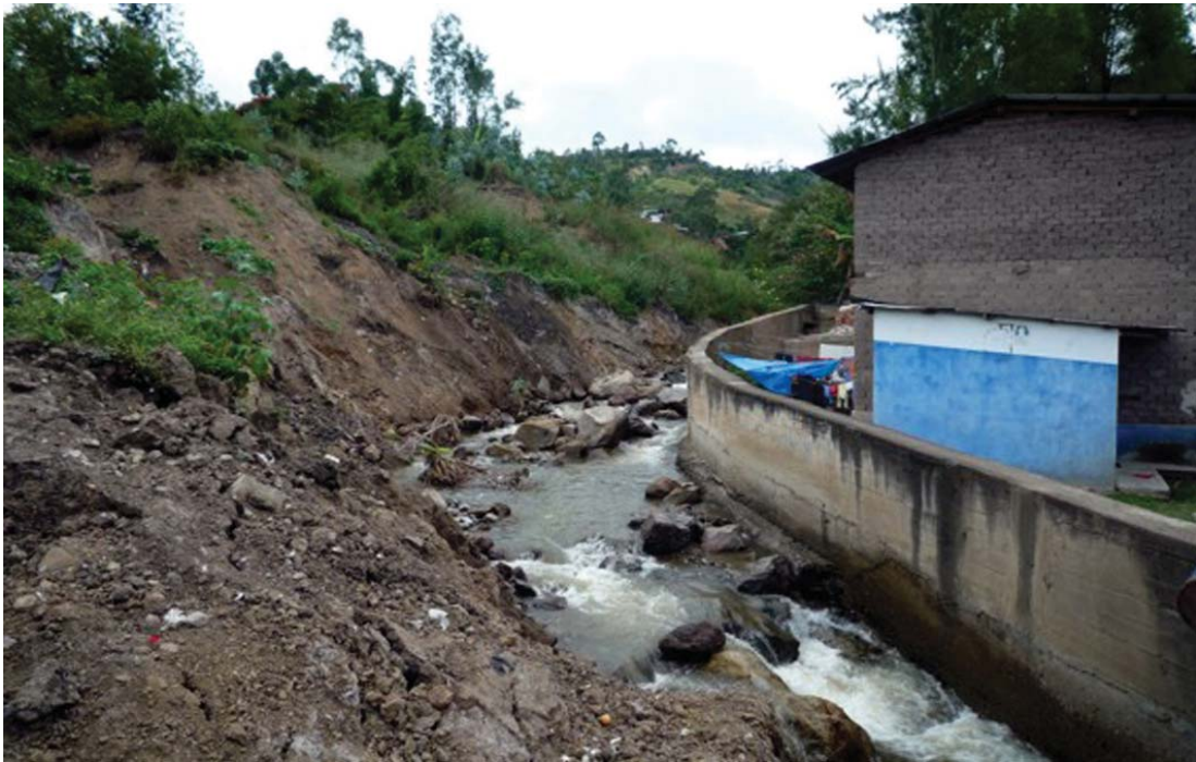
Fotografía 6.11 Flujo de detritos discurre por la quebrada Unguio, la cual ha sido encauzada aguas abajo; distrito y provincia de Huancabamba
