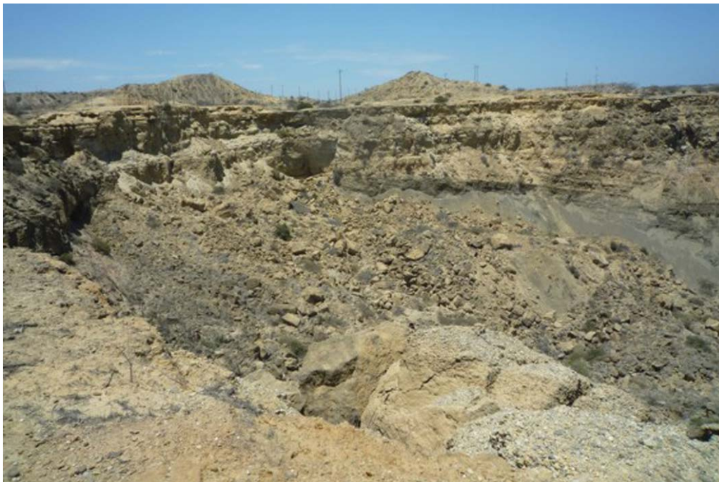
Fotografía 6.68 Cabeceras de la quebrada El Verde, con avance retrogresivo de derrumbes y deslizamientos, que puede comprometer la carretera Panamericana Norte
