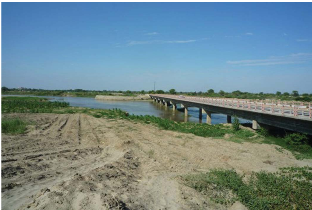
Fotografía 6.38 Puente Independencia, vista aguas arriba. En su margen izquierda se han colocado espigones y gaviones para controlar la erosión
