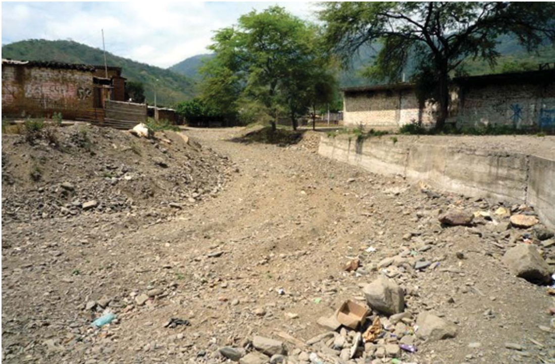
Fotografía 6.12 Huayco de la quebrada Palo Blanco, en el sector San Juan de Bigote. Todos los años acarrea flujo, material conformado por bloques subredondeados y árboles de algarrobos; distrito de San Juan de Bigote, provincia de Morropón
