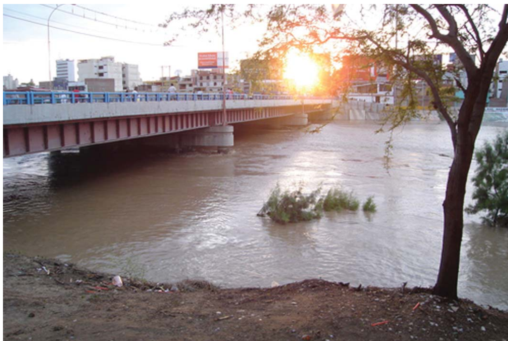
Fotografía 6.55 Vista del puente Sánchez Cerro sobre el río Piura
