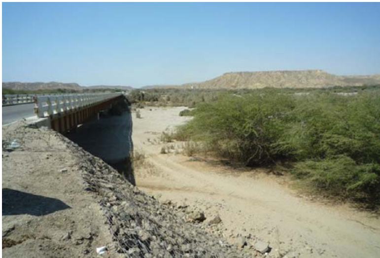
Fotografía 6.75 Carretera Panamericana Norte entre las quebradas Paiñas y Honda. Tramo cortado de la carretera se ha variado el trazo gaviones colocadas en estribo de puente Quebarda Seca
