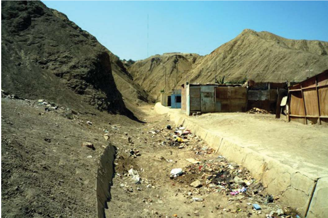
Fotografía 6.18 Sector Luis Alba Castro, Flujo de lodo excepcional, el cual ha sido canalizado aguas abajo de la quebrada. Distrito de Pariñas, provincia de Talara
