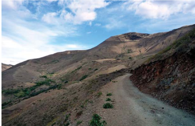
Fotografía 6.6 Sector las Pampas, deslizamiento antiguo que se comportó como flujo, presenta reactivaciones en el cuerpo por sectores como deslizamientos, reptación de suelos y derrumbes. Distrito de Pacaipampa, provincia de Ayabaca, región Piura
