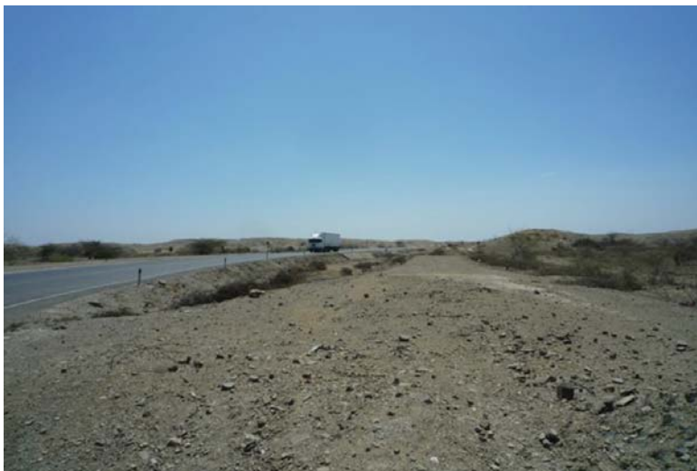
Fotografía 6.76 Vista de flujo de detritos en la quebrada Pan de Azúcar, que cortó la carretera Panamericana Norte a la altura del km 65, se ha tenido que variar el tramo.
