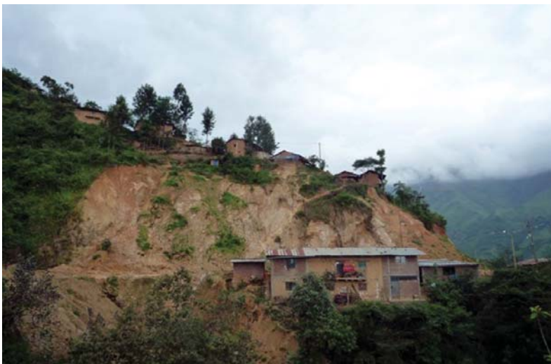
Fotografía 6.8 Sector El Higerón, zona generalmente afectada por constantes deslizamientos y derrumbes. Destruyó una vivienda en el año 2009 y está afectando la carretera. Presenta suelo saturado. Además, presenta erosión en cárcava de actividad retrogresiva, en el km 13+940. Distrito de San Miguel de El Faique, provincia de Huancabamba, región Piura
