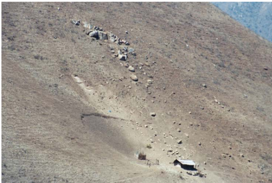
Fotografía 6.1 Caída de rocas sobre una vivienda ubicada en la trocha carrozable Ayabaca-Sausal, región Piura
