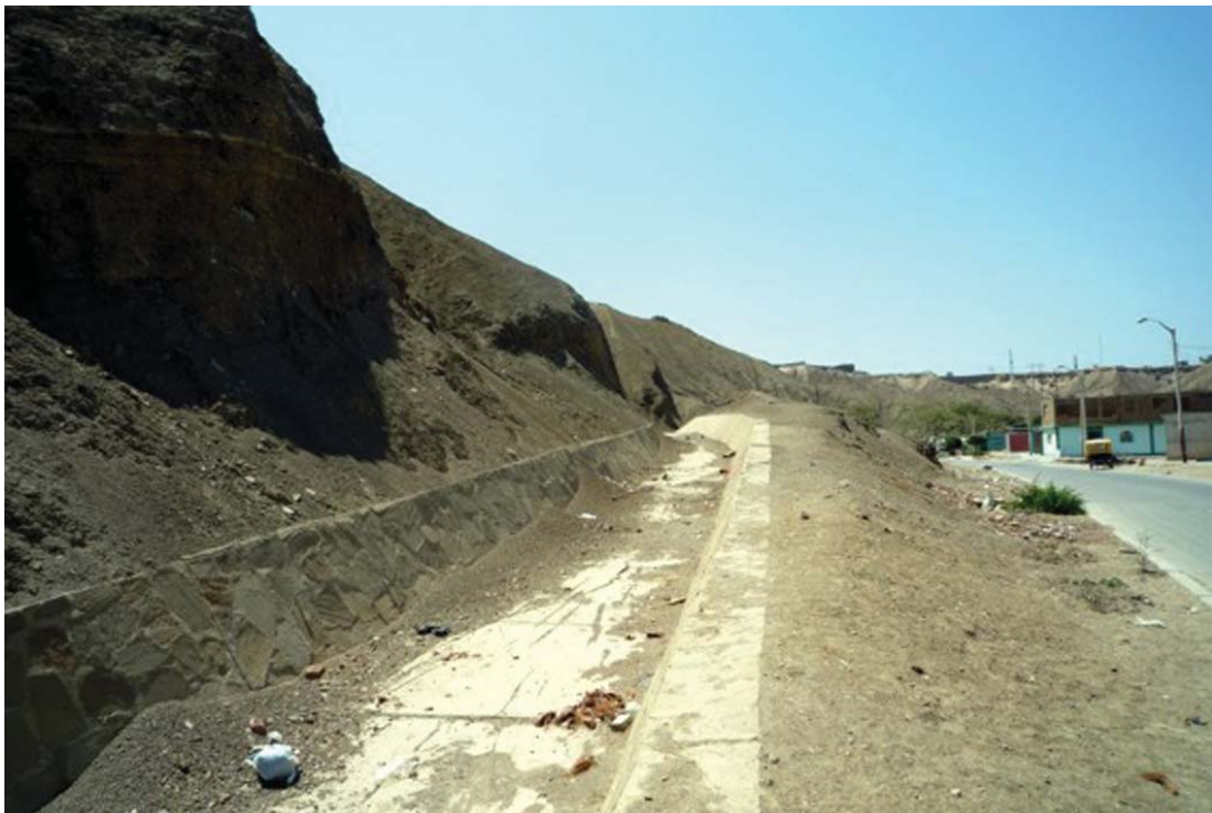
Fotografía 6.19 Urb. James Store, zona donde se producen flujos de lodo de forma excepcional, las torrenteras han sido canalizadas. Distrito de Pariñas, provincia de Talara
