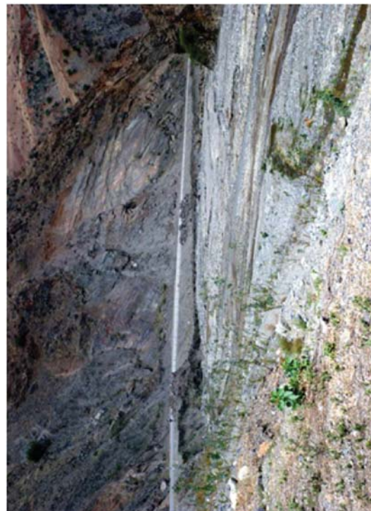
Fotografía 6.28 Erosión fluvial en la margen izquierda de la quebrada Hualapampa, al pie del cerro Minas, afecta 100 m de la carretera Hualapampa-Jaén. Distrito de Huarmaca, provincia de Huancabamba
