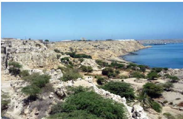
Fotografía 5.25 Deslizamiento en los acantilados de Paita, Piura, agosto de 2009
