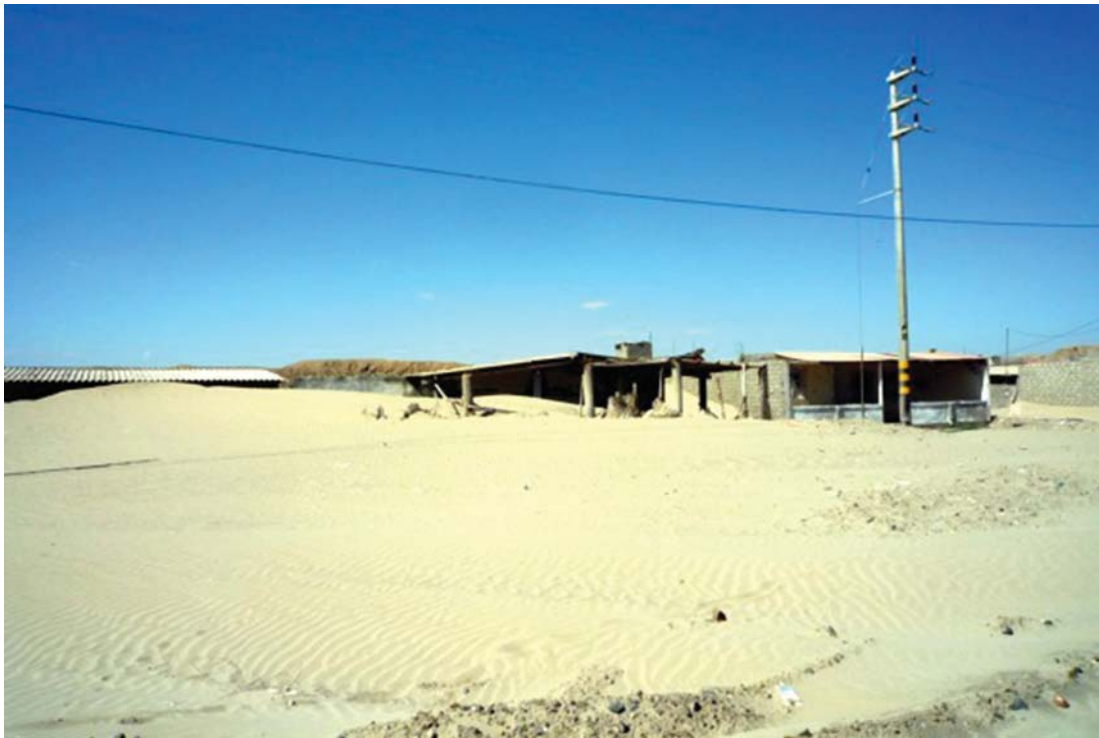
Fotografía 6.35 Sector Playa Cangrejos, campo de dunas de 3 m de altura, que invaden viviendas, veredas, postes de transmisión eléctrica y carretera de acceso a la playa. Distrito y provincia de Paita
