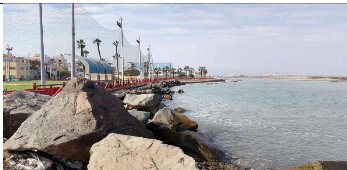
La Bocana de la Poza la Arenilla colindante con área verde y polideportivo
