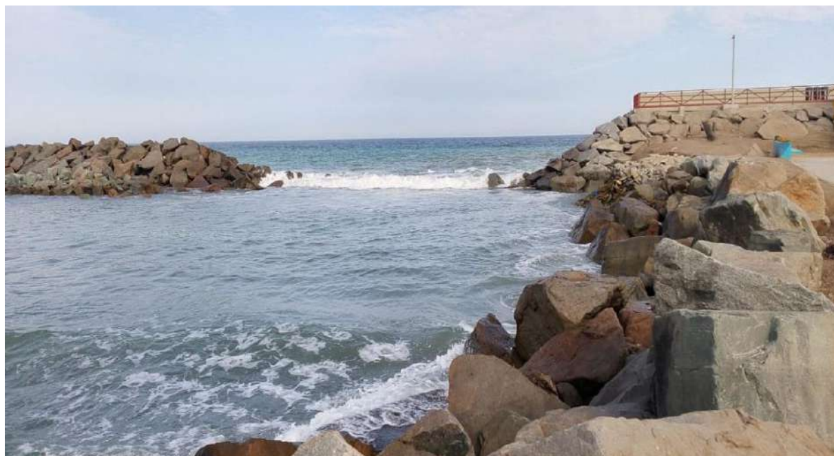
Falta mejorar los enrocados
