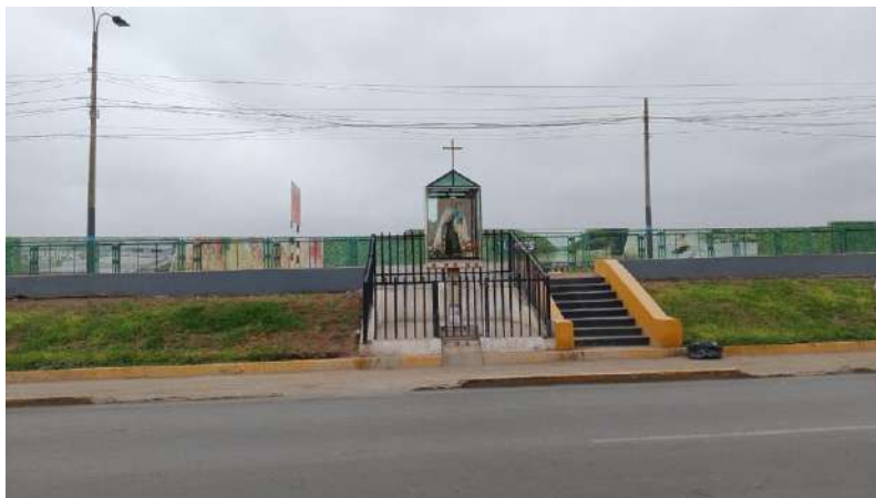
Figura N°20: Av. Morales Duarez, tiene un desnivel de 1.50m de altura paralela al río Rímac
