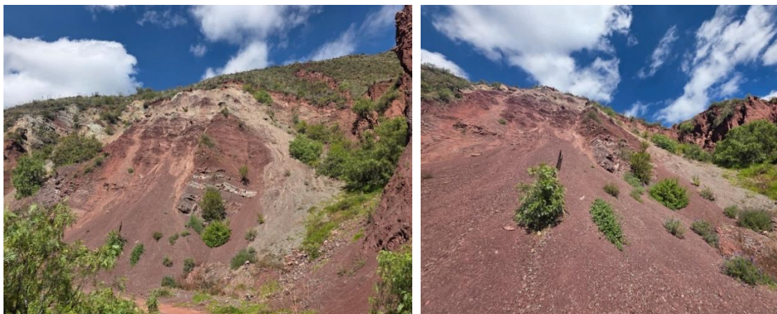
FOTOGRAFÍA 38: ZONA AFECTADA POR PROCESOS DE DESLIZAMIENTOS EN LA PARTE ALTA DE LA APV. MOLLEMOLLEYOC.
