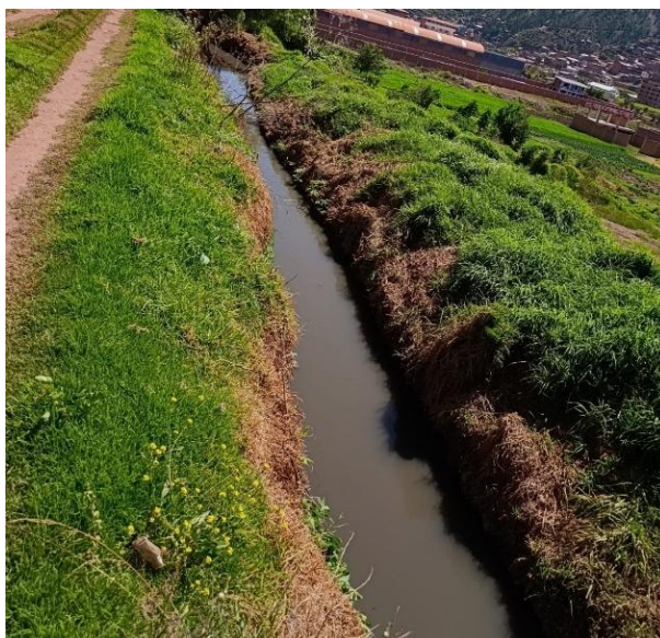
FOTOGRAFÍA 9: CANAL DE RIEGO EXPUESTO EN EL SECTOR DE CONDORCCATA
