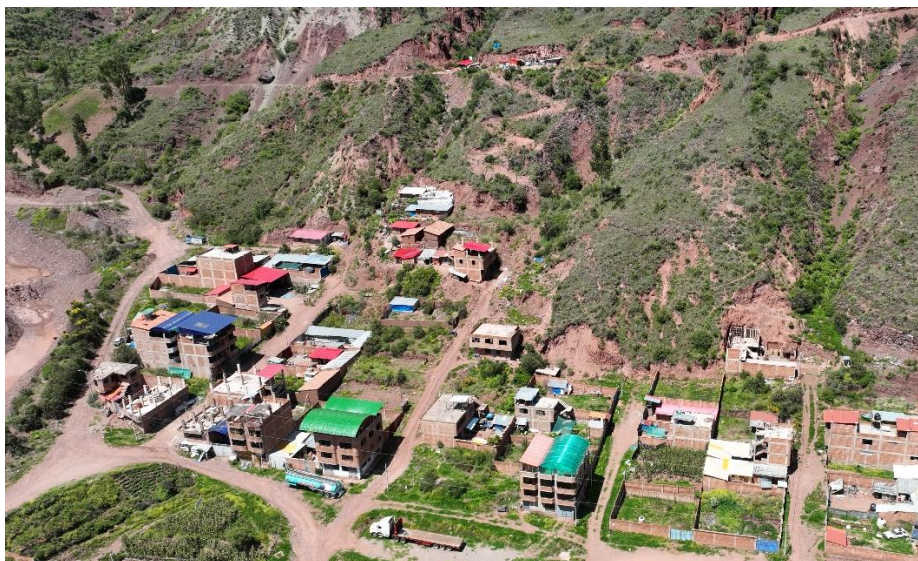
FOTOGRAFÍA 30: MANZANA A, B, C Y D DE LA APV. MOLLEMOLLEYOC, SE OBSERVA CORTES DE ALTURA CONSIDERABLE QUE DESESTABILIZAN LOS TALUDES.
