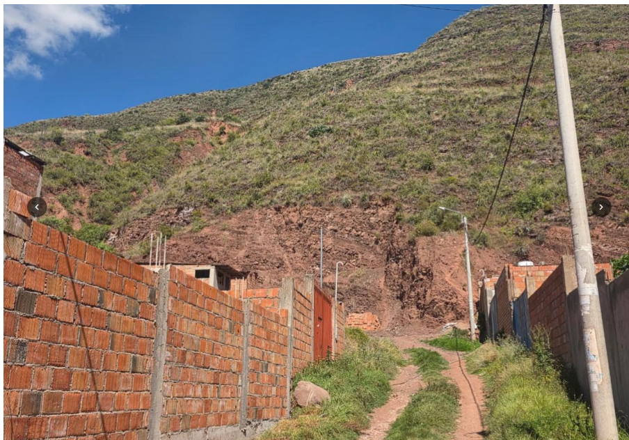
FOTOGRAFÍA 35: CORTES DE TALUD DE ALTURA CONSIDERABLE EN LA Mz E - APV. MOLLEMOLLEYOC
