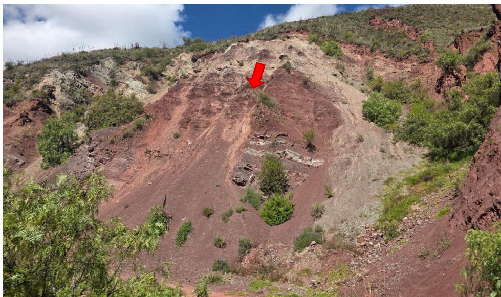
FOTOGRAFÍA 24: DESLIZAMIENTO DE ROCAS EN LA PARTE SUPERIOR DEL SECTOR DE MOLLEMOLLEYOC
