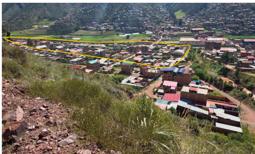
FOTOGRAFÍA 14: DEPÓSITO ALUVIAL EN LA ZONA DE ESTUDIO
