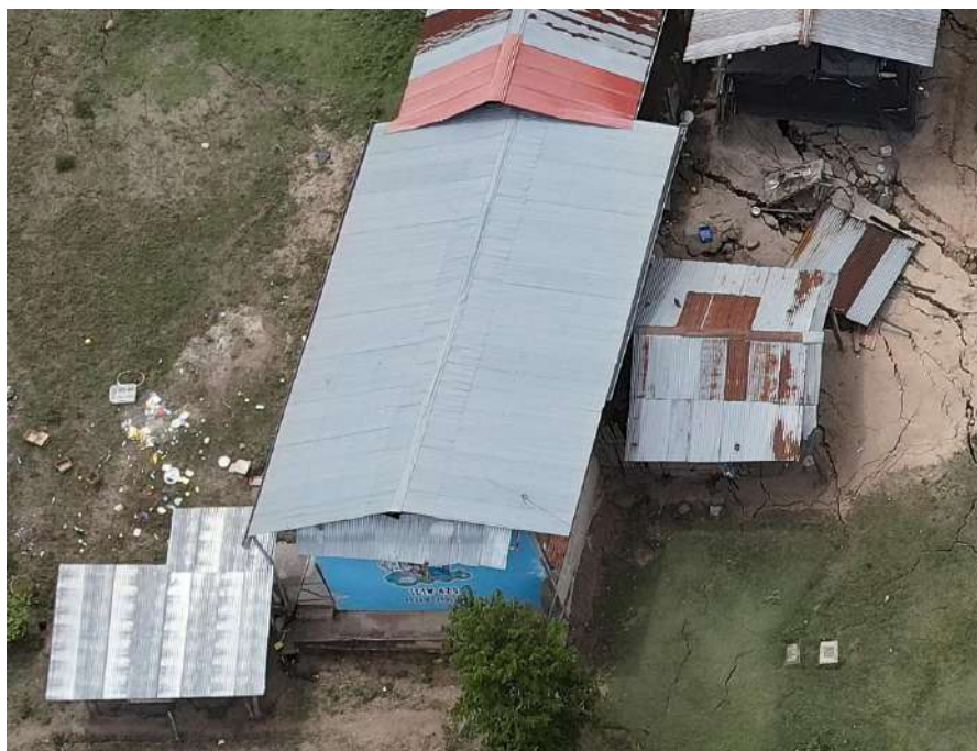
Foto N° 30: Elemento expuesto I.E nivel inicial.
