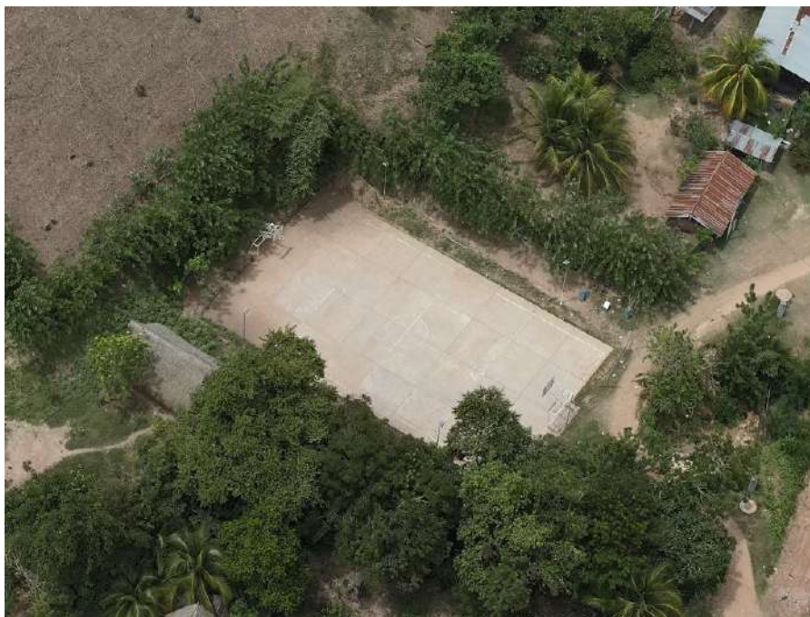
Foto N° 31: Elemento expuesto loza deportiva.
