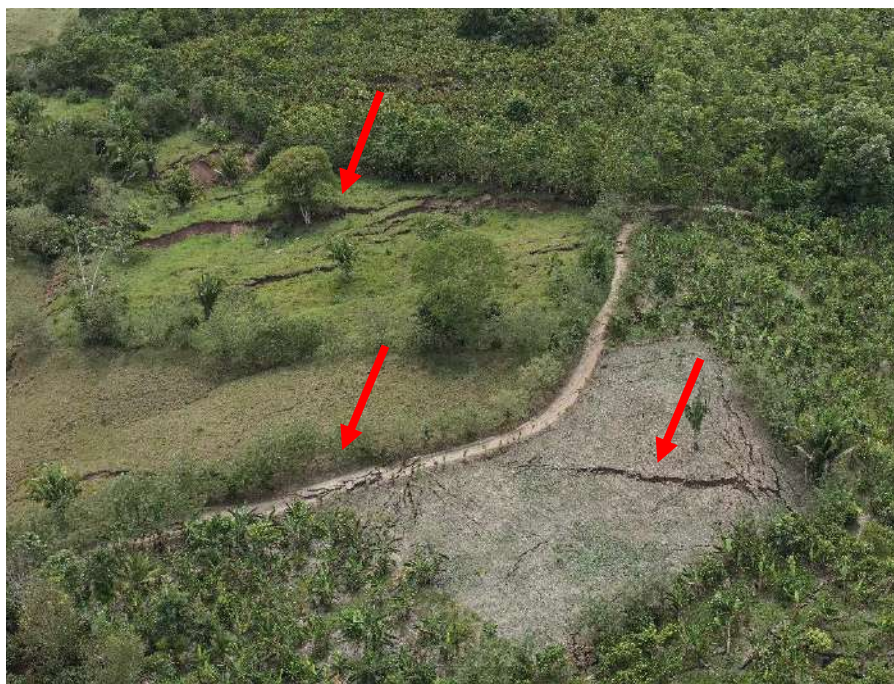
Foto N° 27: Agrietamiento y afectación de camino de herradura.
