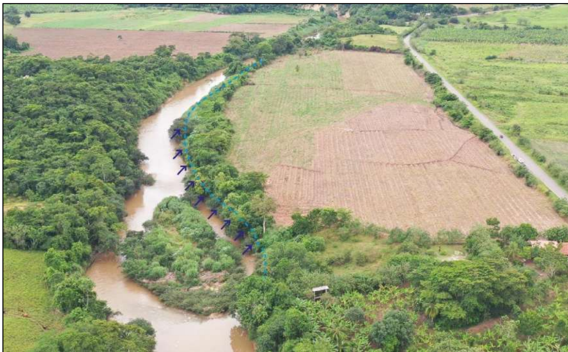
Figura 32: Vista aérea hacia el sur donde se observa la zona propensa a erosión fluvial (flechas azules) dentro de la zona de reubicación 1.
