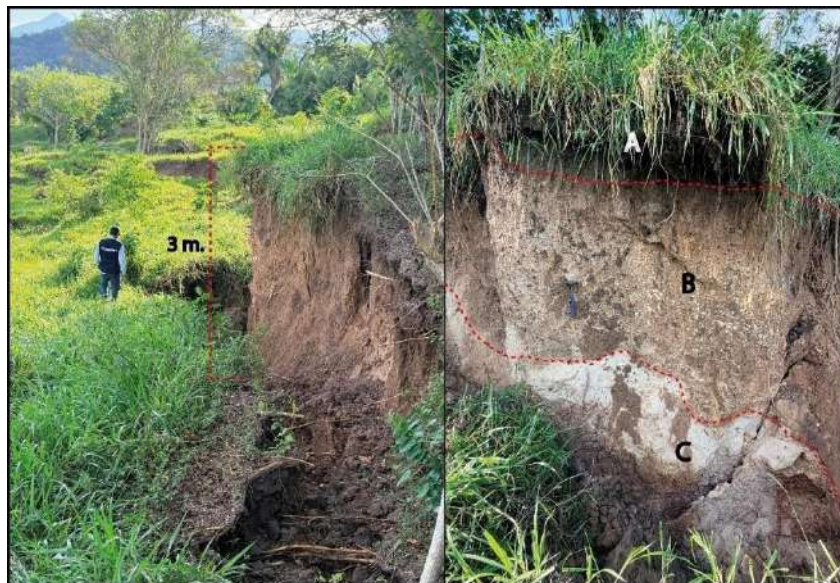
Figura 15: Escarpe secundario en la parte media de la masa deslizada, el escarpe llega a ser de 3 m, a su vez el escarpe muestra cómo se encuentra la roca completamente meteorizada y convertida en suelo (Coordenadas UTM – 18s 9261479 N, 313414 E).
