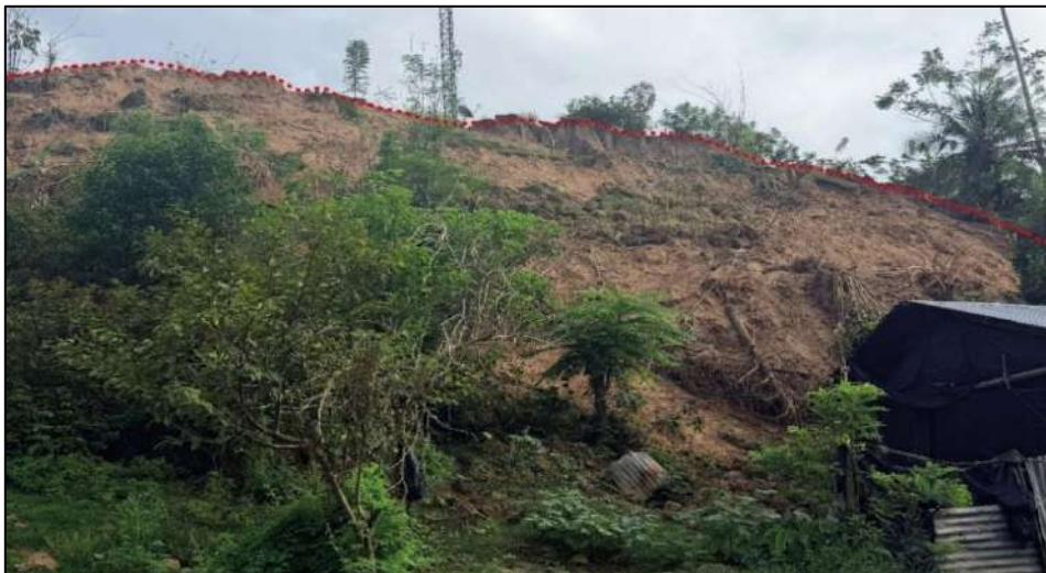
Figura 21: Pie del deslizamiento, donde se observa el incremento del relieve y la pendiente del talud producto del movimiento y empuje de la masa desplazada pendiente abajo (Coordenadas UTM – 18s 9261165 N, 313463 E).
