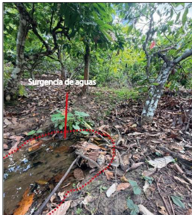
Figura 19. Evidencia de surgencia de agua en la masa del deslizamiento (Coordenadas UTM – 18s 9261785 N, 313766 E).
