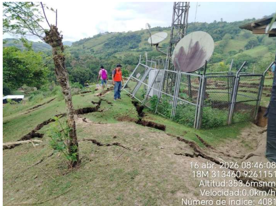
Foto N° 23: Afectación de antena por deslizamiento rotacional.
