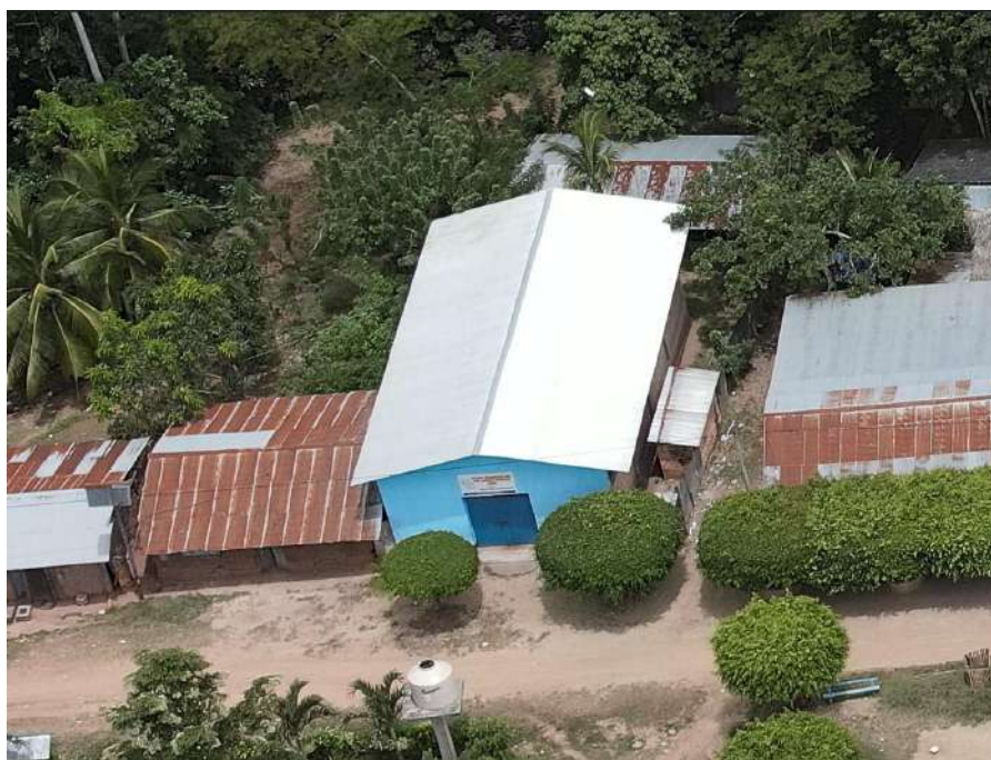
Foto N° 32: Elemento expuesto iglesia evangélica.
