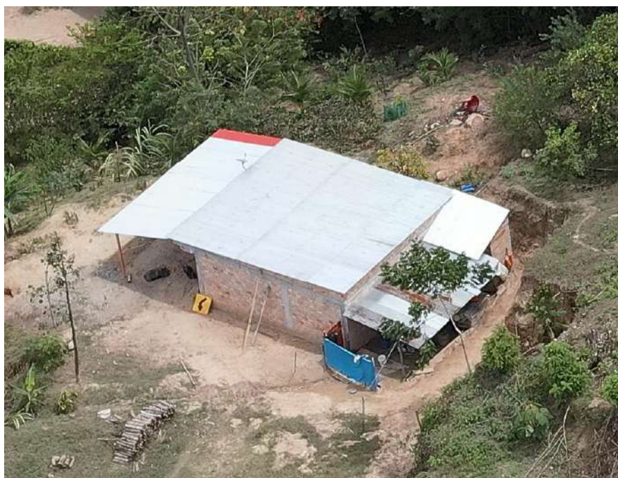
Foto N° 34: Elemento expuesto viviendas localidad Eladio Tapullima.
