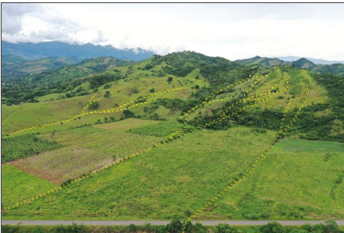
Figura 33: Vista aérea hacia el norte noroeste, se evidencia erosiones de la ladera y pequeñas quebradas que atraviesan la zona de reubicación 1.
