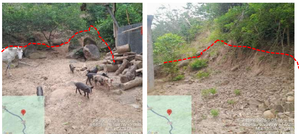
Foto N° 9: Flujos de detritos en laderas de la localidad de Eladio Tapullima de material no consolidado o depositados de forma violenta.
