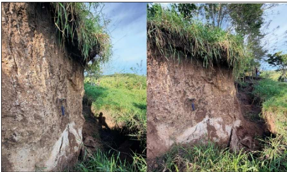
Figura 4. Afloramiento de areniscas muy meteorizadas de la Formación Ipururo. Presenta una coloración rojiza oscura debdo a la alta concentración de humedad por filtraciones de agua de lluvia (Coordenadas UTM – 18s 9261477 N, 313428 E).
