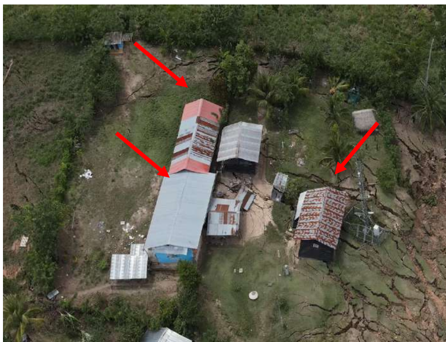
Foto N° 28: Agrietamiento y afectación a institución educativa y a viviendas colindantes.
