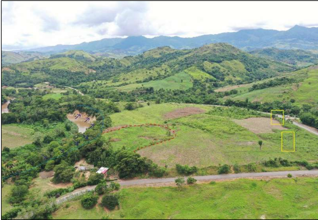
Figura 35. Vista hacia el sur de la zona de reubicación 2. Se presenta un deslizamiento rotacional activo (líneas rojas), erosión fluvial por dinámica del río sisa (flechas azules). Asimismo, se presenta postes y líneas de alta tensión sobre dicha área (cuadros amarillos).
