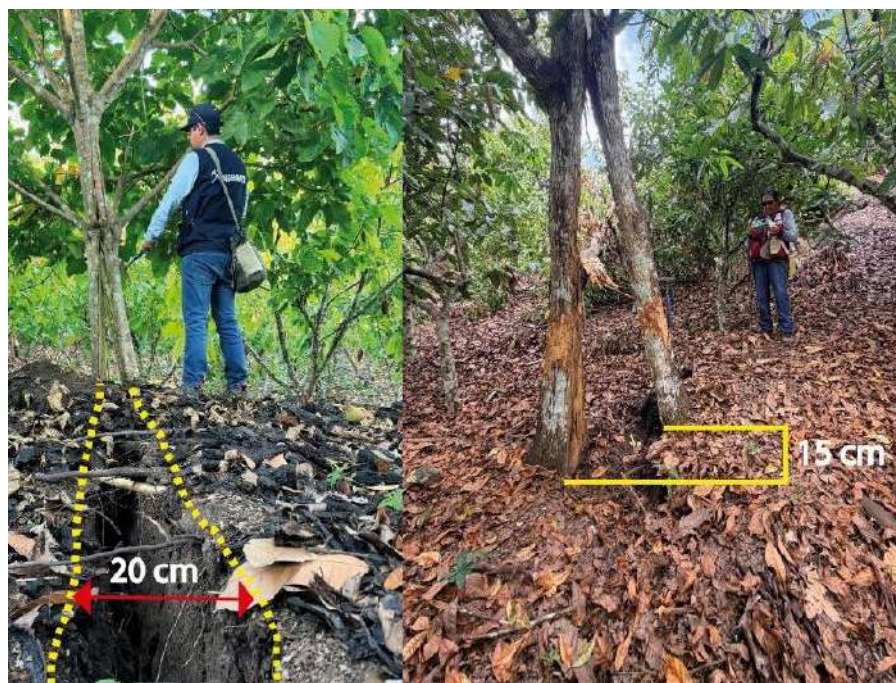
Foto N° 26: Agrietamiento del terreno y afectación a plantaciones.
