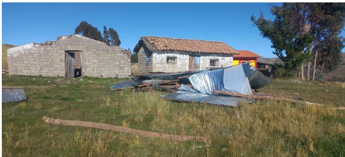
Imagen 51. Vista de afectación de viviendas por peligro de vientos fuertes.
