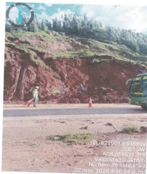
Fotografía 26: Deslizamiento en la zona de huampar
