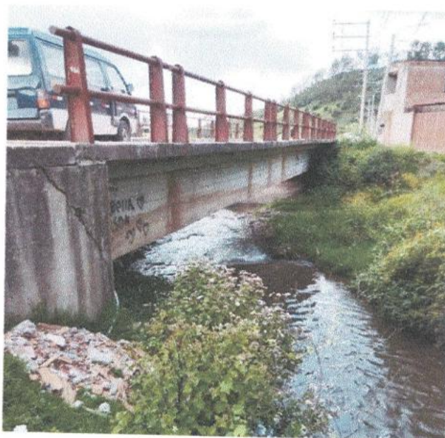
fotografía 41: Estructura del puente
