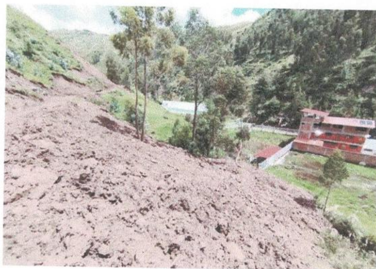
Fotografía 24: Deslizamiento de depósitos coluviales
