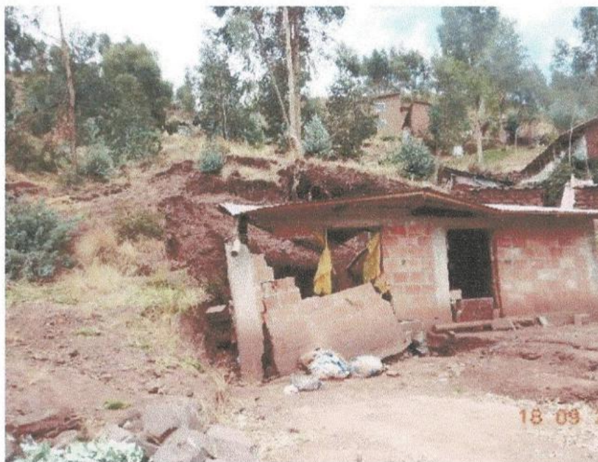
Fotografía 15: Vivienda colapsada producto de la reactivación de la ladera noreste del cerro Roquelloccata en derrumbe
