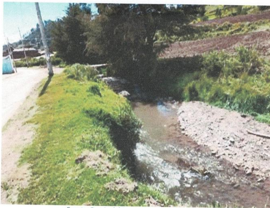
Fotografía 8: Vía asfaltada en riesgo por crecida del río Hatunmayo
