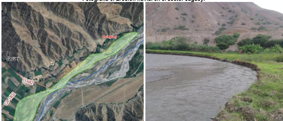
Fotografía 6. Erosión fluvial en el sector Jaguey.
