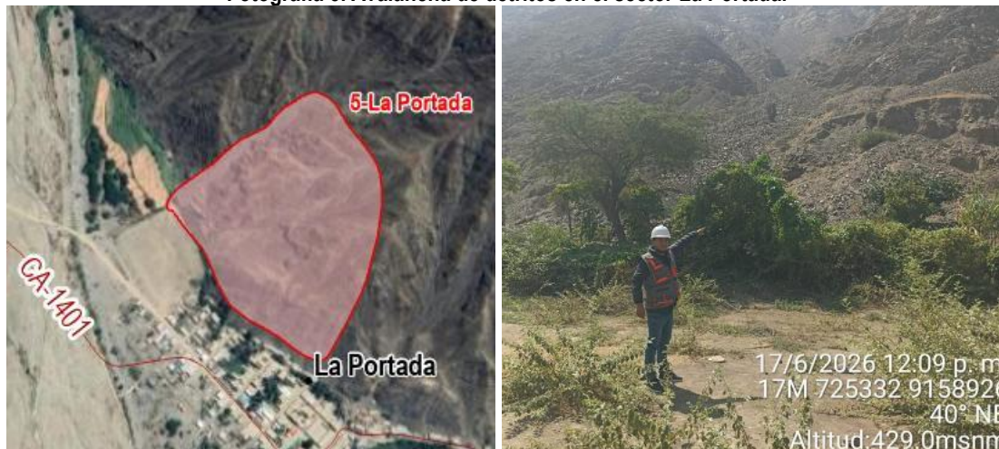
Fotografía 5. Avalancha de detritos en el sector La Portada.
