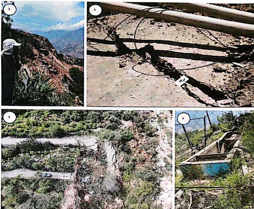
Ilustración 5. Imagen del deslizamiento, con el desprendimiento de la vía AN-545 tramo Yuracmarca - Sihuas
