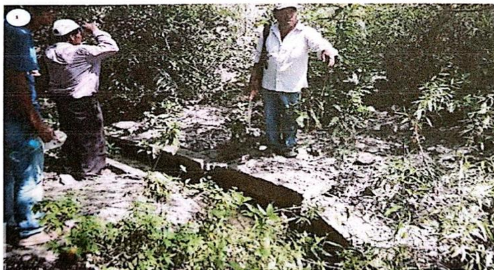
Ilustración 19. Imagen del deslizamiento en el sector San Cayetano.
