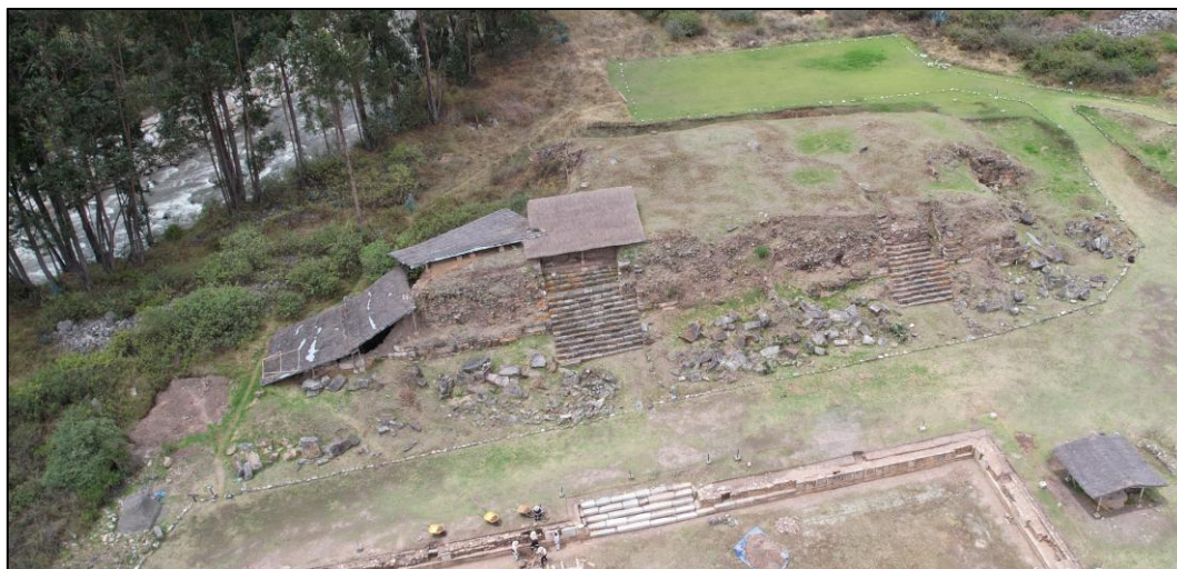
Figura 53. Vista del Edificio G
