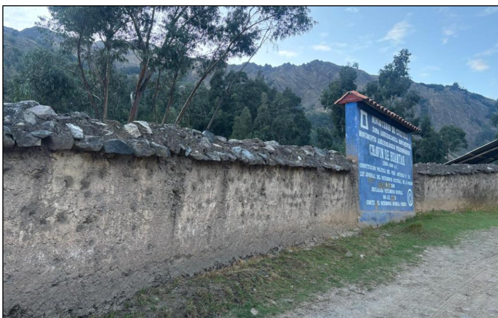
Figura 65. Vista del Cerco Perimétrico
