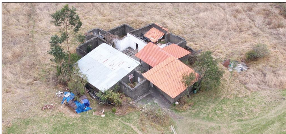
Figura 61. Vista del Almacén 2
