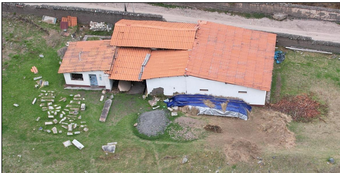
Figura 60. Vista del Almacén 1
