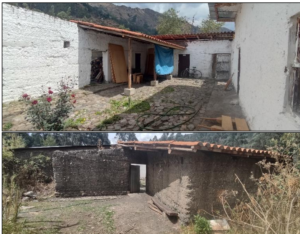
Figura 62. Vistas interna y externa del Almacén 2
