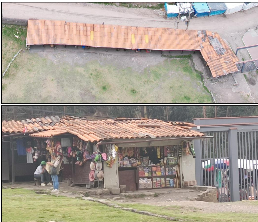
Figura 66. Vista de los Kioscos
