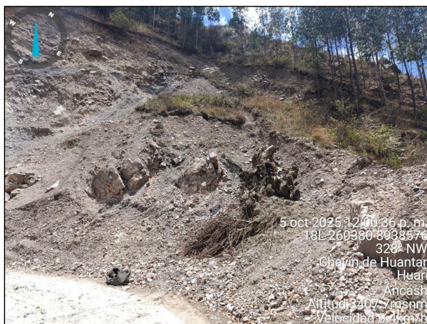
Figura 76. Derrumbe activo en la vía hacia Cochas. El derrumbe está conformado por suelo y roca en menor proporción
