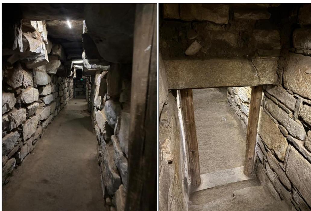
Figura 45. Vista de las Galerías del Edificio A
