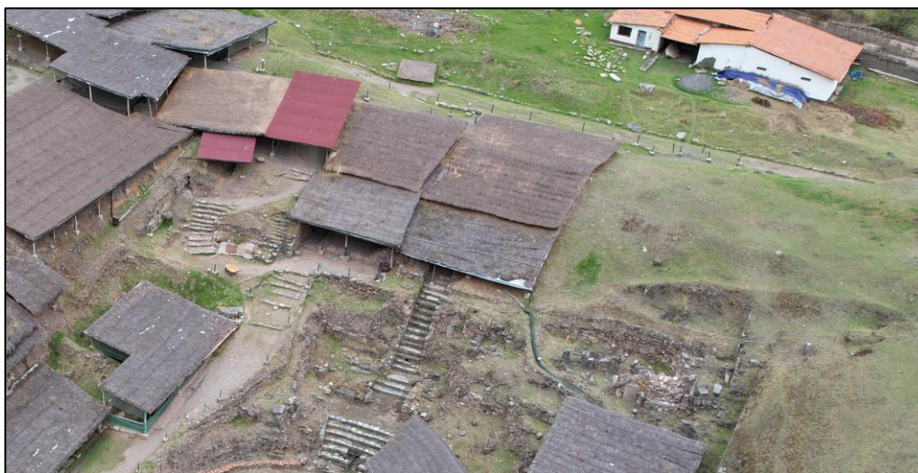
Figura 47. Vista del Edificio B
