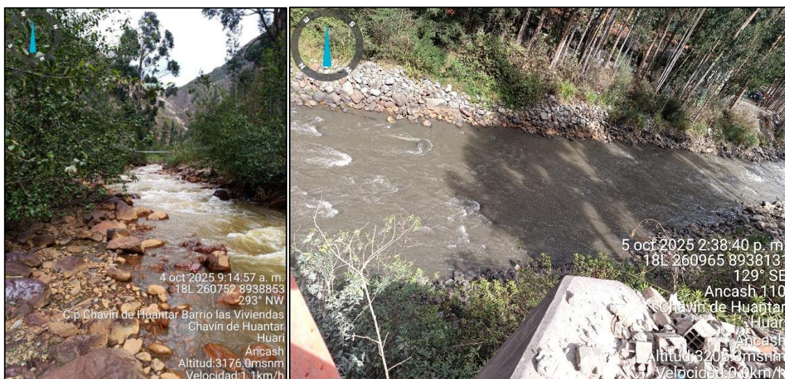
Figura 18. Depósitos fluviales del río Huachecsa (izquierda) y del río Mosna (derecha)
