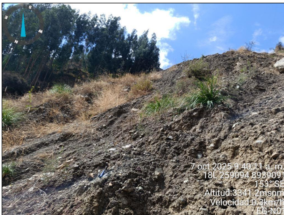
Figura 21. Depósitos de deslizamiento formando parte del cuerpo deslizante en la zona de Nunupata, próximo al río Huachecsa
