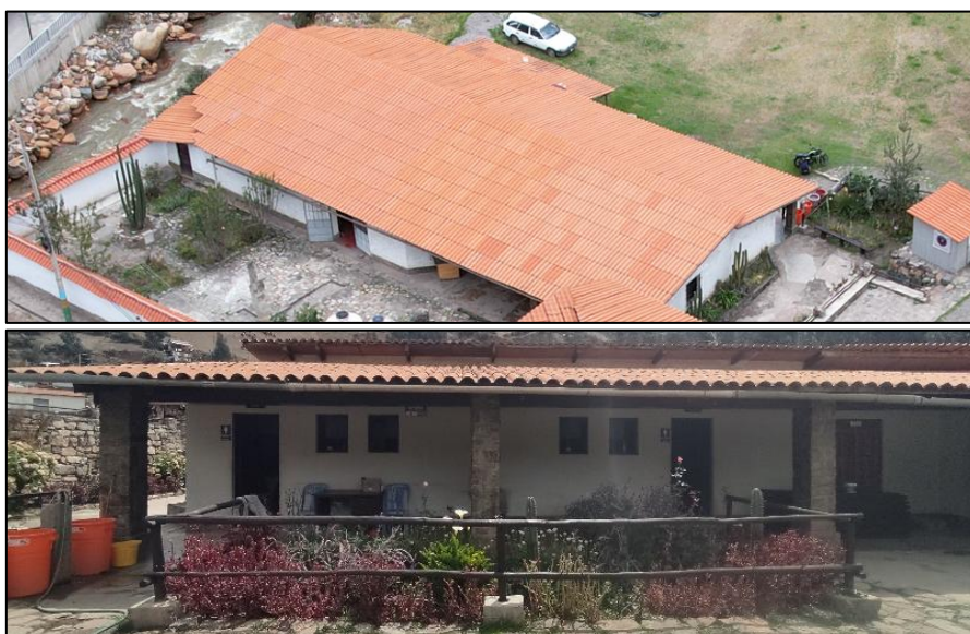
Figura 67. Vista de las Oficinas
