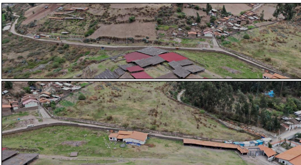
Figura 64. Vista aérea del Cerco Perimétrico
