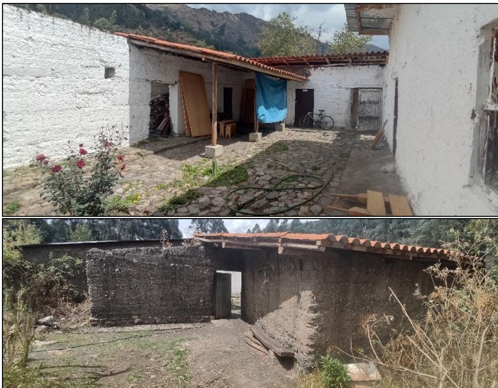
Figura 72. Vistas interna y externa del Almacén 2
