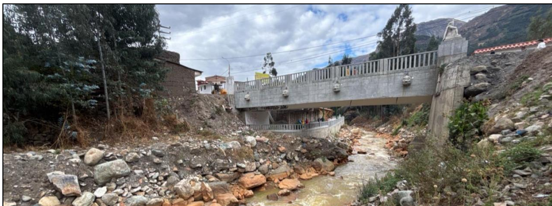
Figura 110. Infraestructura del puente sobre el río Huachecsa
