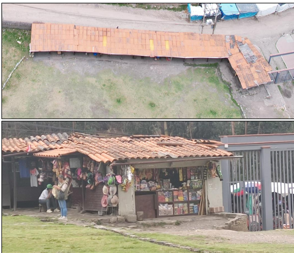
Figura 76. Vista de los Kioscos
