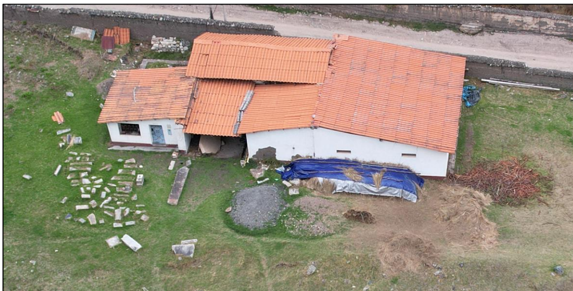
Figura 70. Vista del Almacén 1
