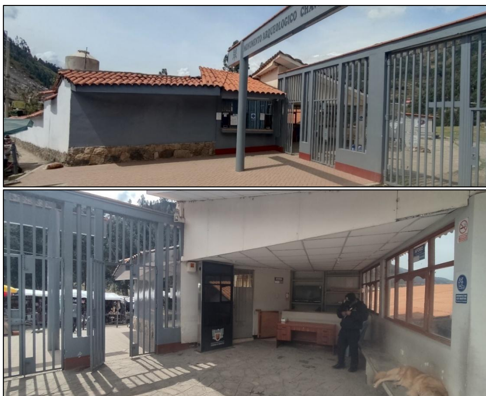
Figura 73. Vista de la Boletería
