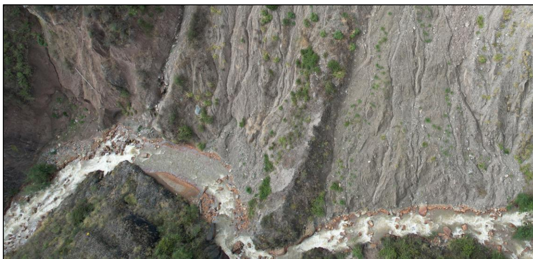
Figura 36. Depósitos coluviales en la ribera del río Huachecsa, sector deslizamiento Nunupata
