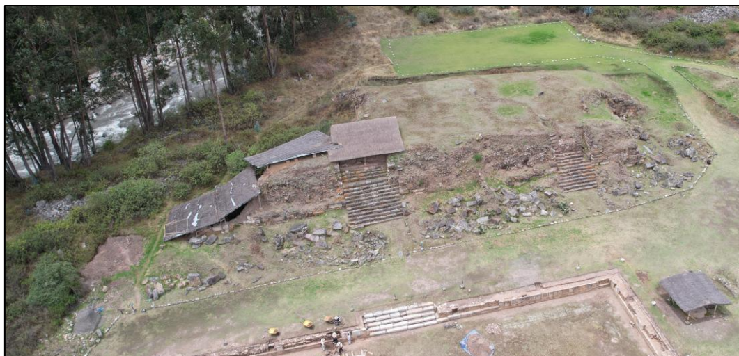
Figura 63. Vista del Edificio G
