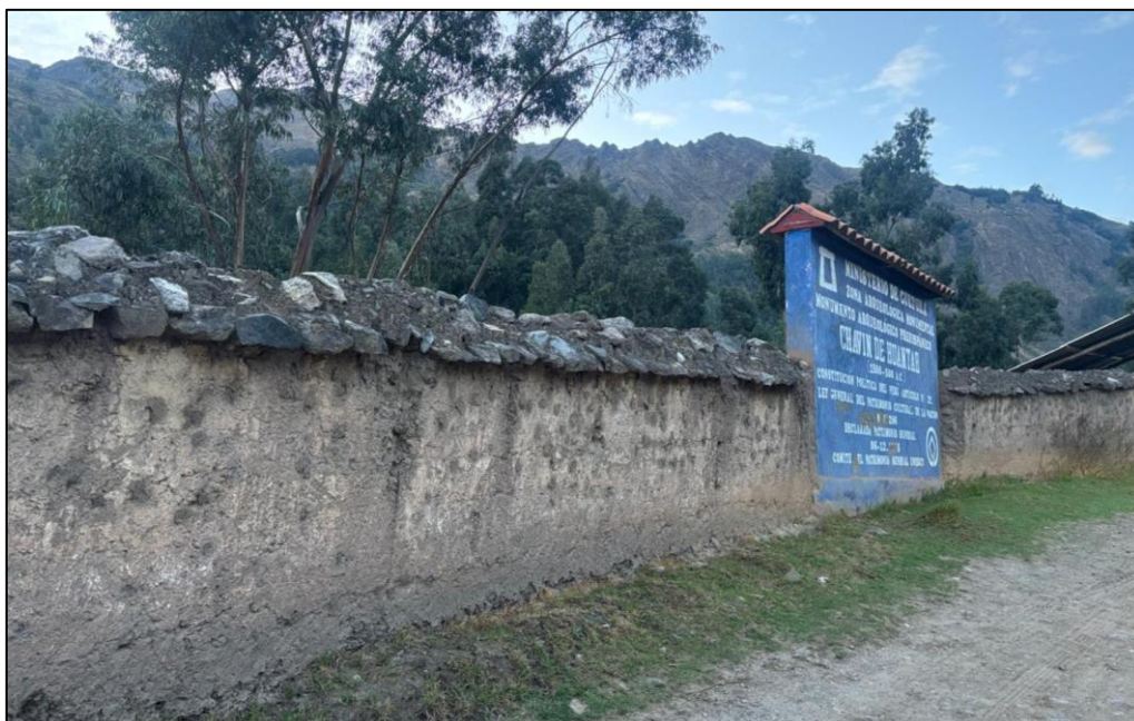
Figura 75. Vista del Cerco Perimétrico
