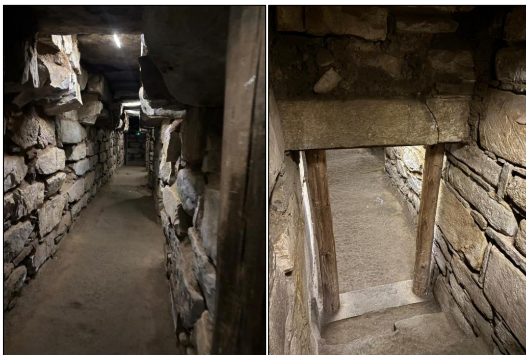
Figura 55. Vista de las Galerías del Edificio A
