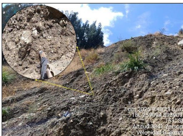
Figura 95. Vista del depósito del Des_4 conformado por gravas angulosas sostenidos en una matriz limo arcillosa
