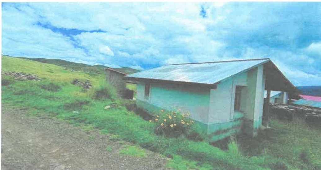
Fotografía 11 Vista de Vivienda del Programa Nacional de Vivienda Rural (PNVR) en el centro poblado de Chaupibanda
