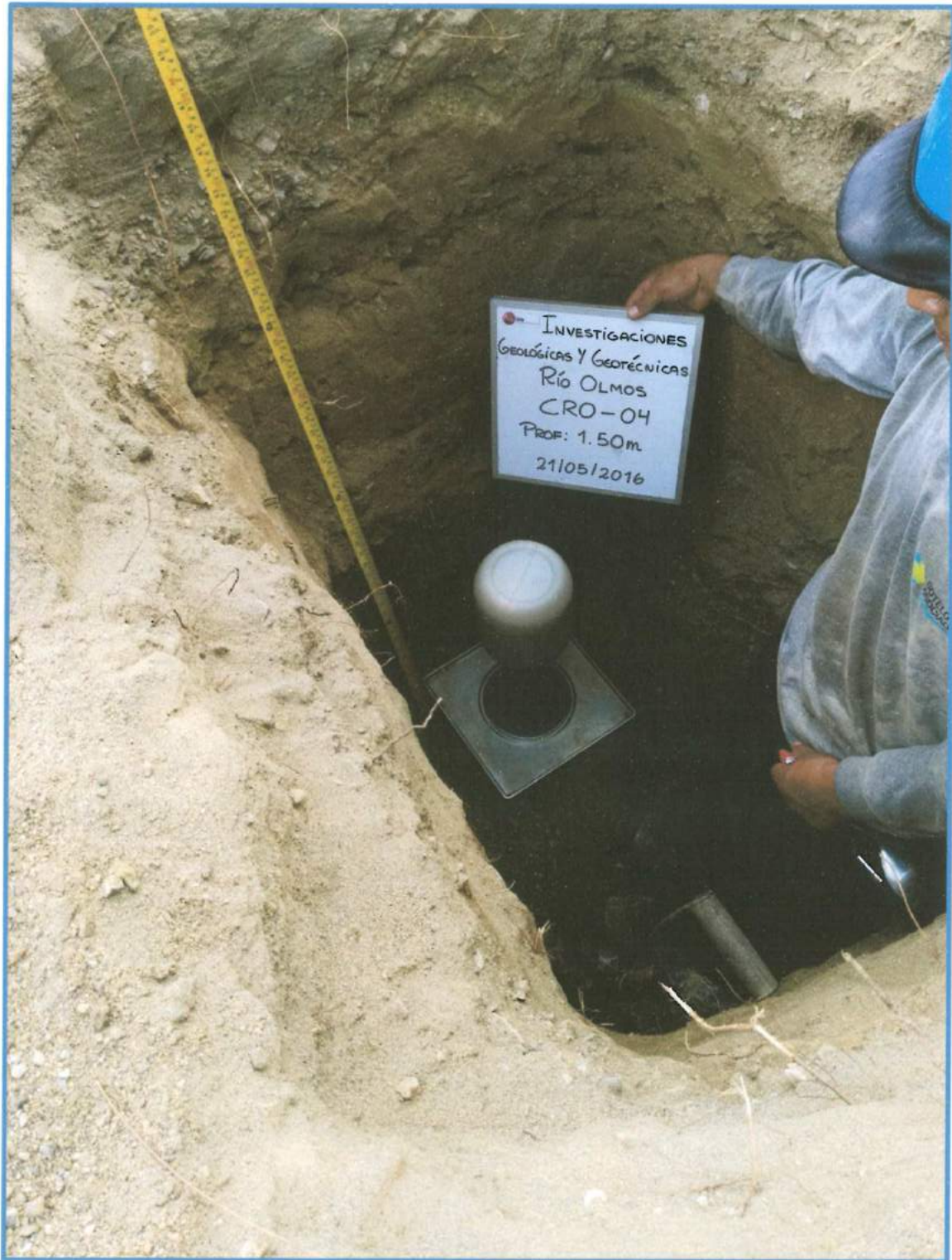
Figura 21.- Calicata CRO-04 Haciendo prueba de densidad natural.
