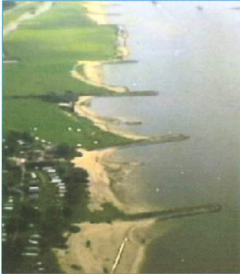
Figura 11.- Espigones en donde se puede observar la acumulación de sedimentos entre ellos – Fuente Internet.
