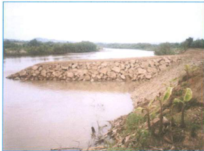
Figura 10.- Espigón. Sector Plateros II Tumbes. Fuente PERPEC.
