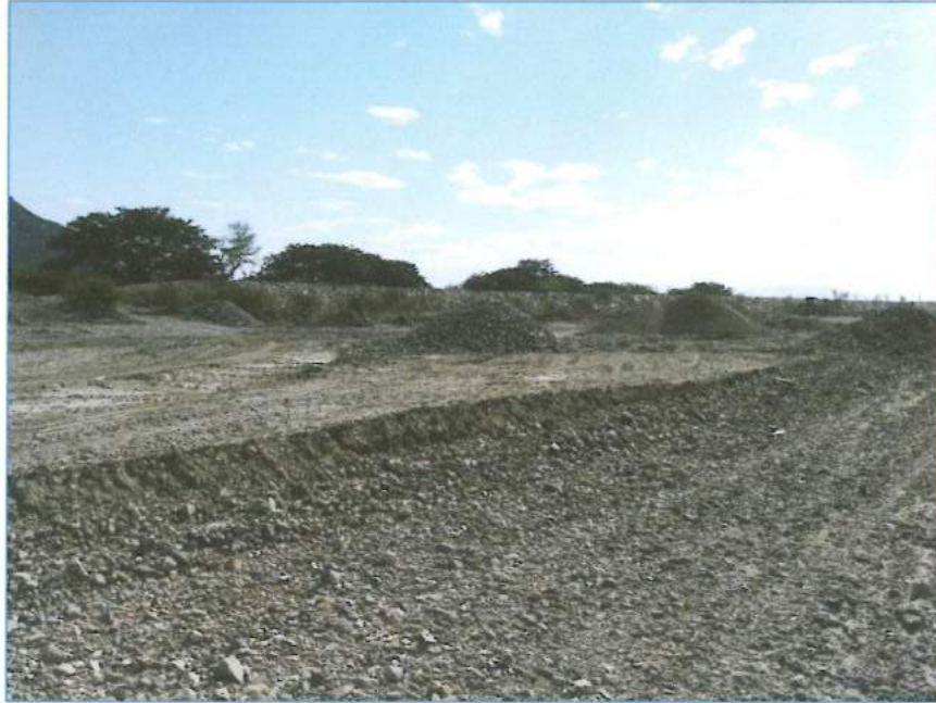
Figura 07.- Dique de enrocado construido en la margen derecha del río Olmos cerca de la ubicación de la calicata CRO-01
