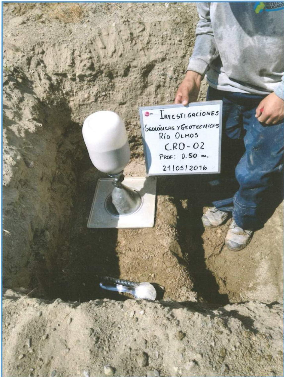
Figura 17.- Calicata CRO-02. Haciendo prueba de densidad natural.
