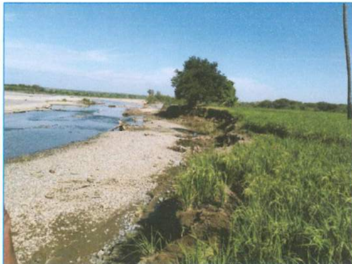
Figura 03.- Vista panorámica tomada aguas abajo del río Chira. Se puede observar depósitos fluviales compuesto de gravas y arenas. En la margen derecha se observa la erosión ribereña producida por el río durante las crecidas.
