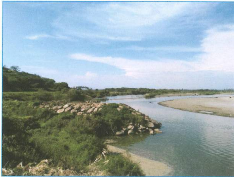
Figura 14.- Se observa espigón parcialmente erosionado. Toma tomada aguas arriba de la calicata CRCH-01
