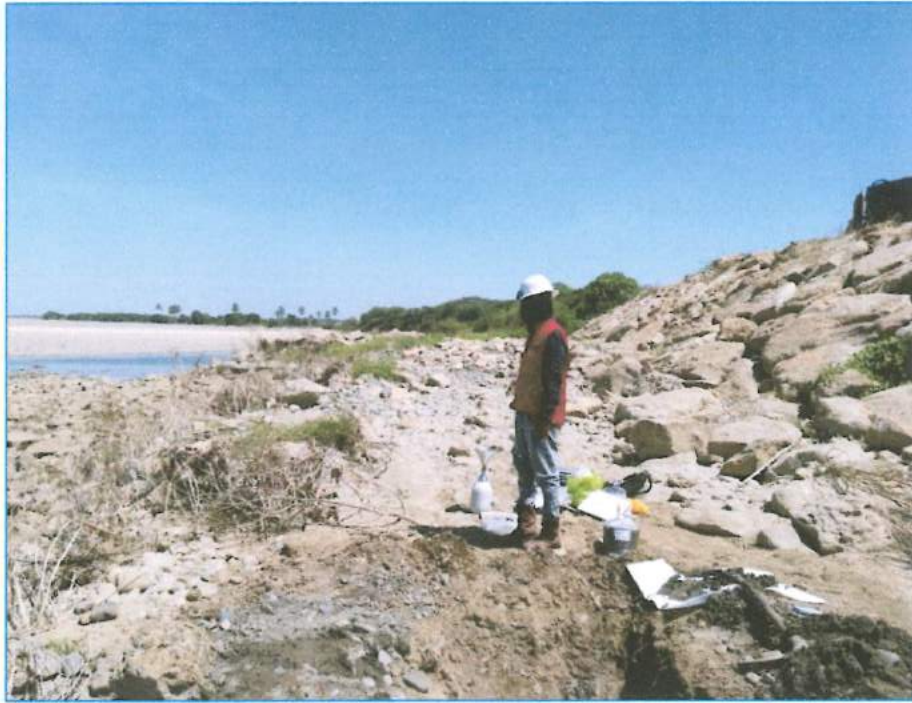
Figura 08.- Dique de enrocado construido en la margen derecha del río Chira, aguas abajo de la Presa Poechos.
