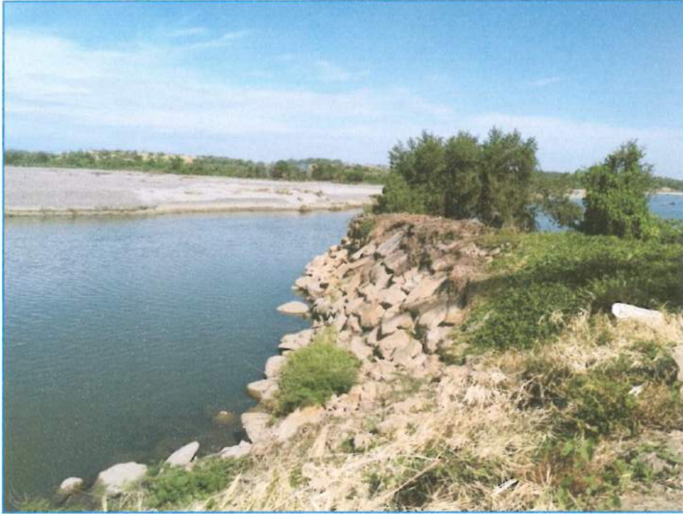
Figura 05.- Sector en donde se observa muro de enrocado construido a fin de evitar la erosión de laderas e inundación. Este lugar se encuentra aguas abajo de la Presa de Poechos. Se observa la roca de arenisca grande colocada al volteo.
