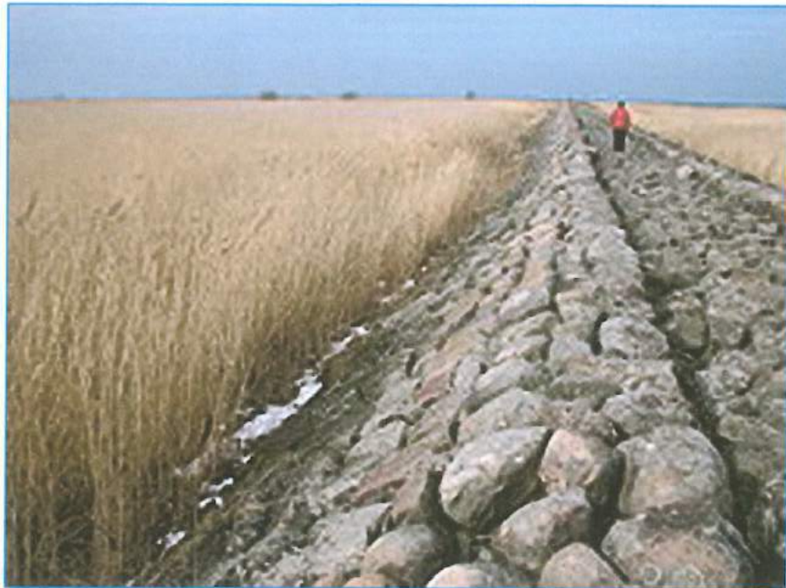
Figura 10.- Dique de enrocado. Fuente internet.
