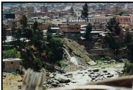
DESCARGA DIRECTA DE DESAGÜE AL RIO SANTA
