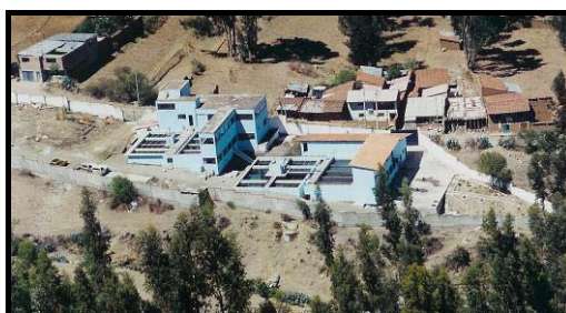
PLANTA DE TRATAMIENTO-AGUA POTABLE (ZONA BELLAVISTA)
