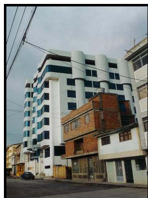
CONSTRUCCIÓN DE 9 PISOS EN ZONA DE PELIGRO ALTO. POTENCIAL DE LICUACIÓN
