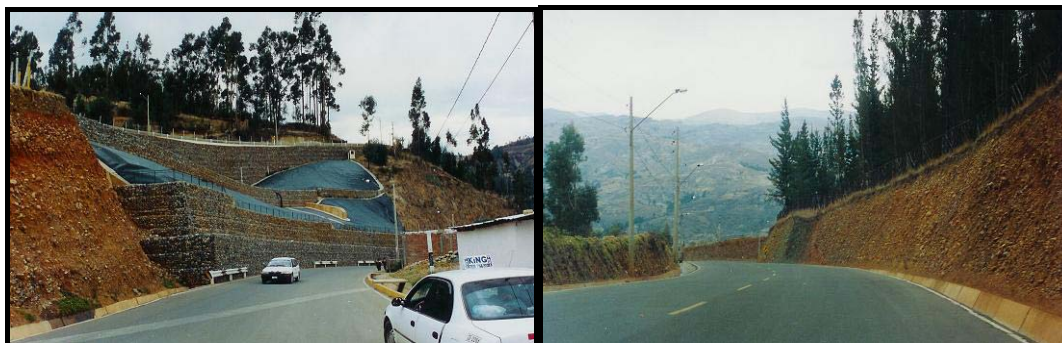
OBRAS DE DEFENSA VIA HACIA EL PINAR
