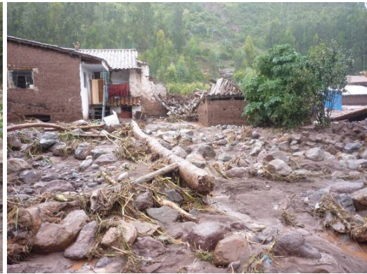
Fotos 25 y 26: Material depositado por el aluvión (bloques, grava, arena, limo, arcillas, troncos, etc.); viviendas de adobe muy afectadas, muchas de ellas colapsadas.
