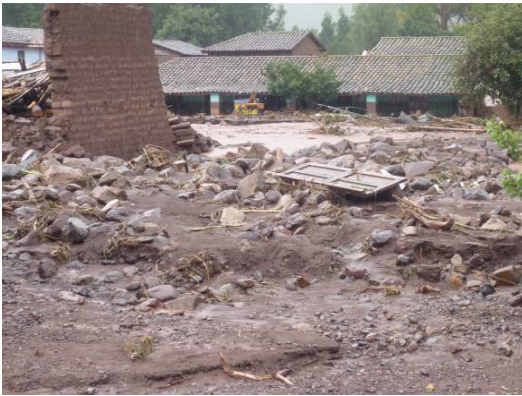
Fotos 25 y 26: Material depositado por el aluvión (bloques, grava, arena, limo, arcillas, troncos, etc.); viviendas de adobe muy afectadas, muchas de ellas colapsadas.
