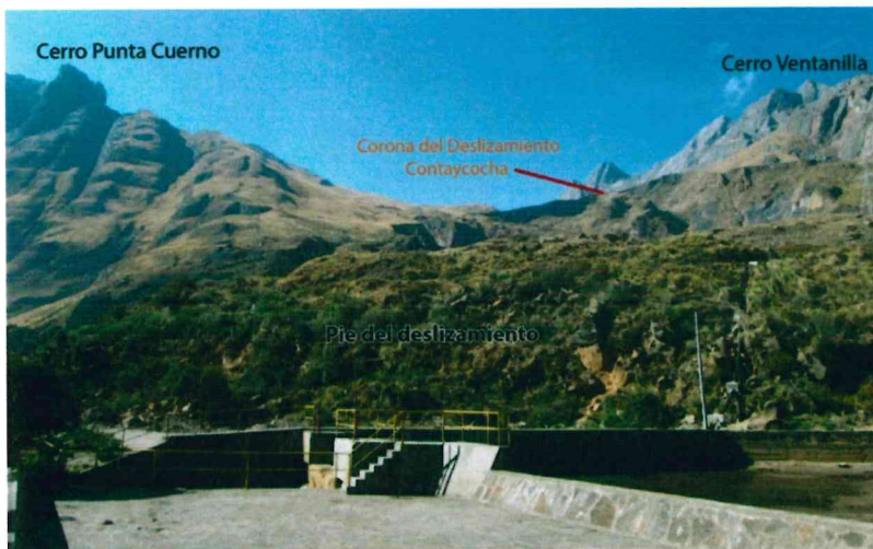
Foto 1: Vista del deslizamiento desde la laguna Contaycocha.
