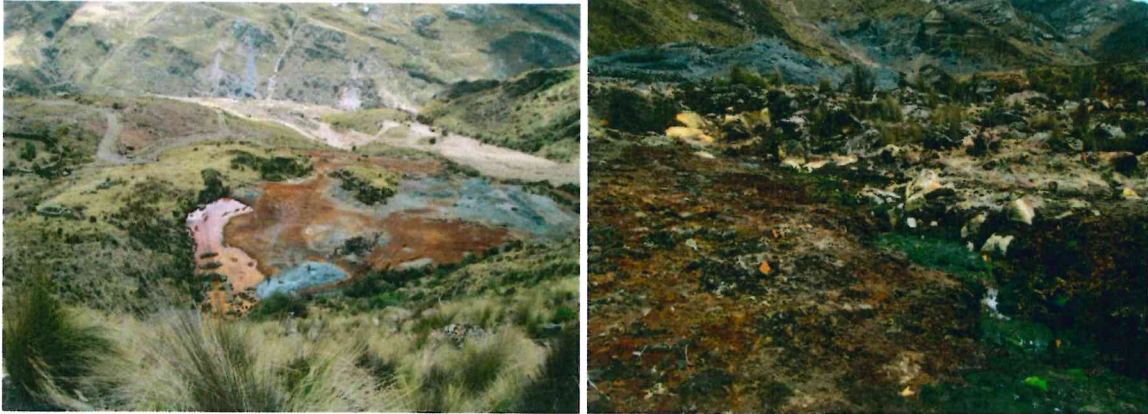
Foto 11: Vista desde la parte alta del deslizamiento, la plataforma de la antigua mina Banco, que origina el empozamiento de las aguas. Foto 12) Surgencia de agua en la parte inferior de la antigua mina Banco. La presencia de grandes bloques y la naturaleza de la matriz del terreno (arcillosa), genera la infiltración de agua en la masa móvil y la retención de agua; esto favorece a la vez un desplazamiento lento en toda la masa.
