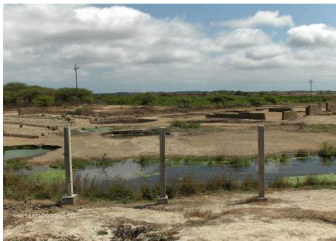
En la vista se observa los huecos que deja la remoción de suelos
