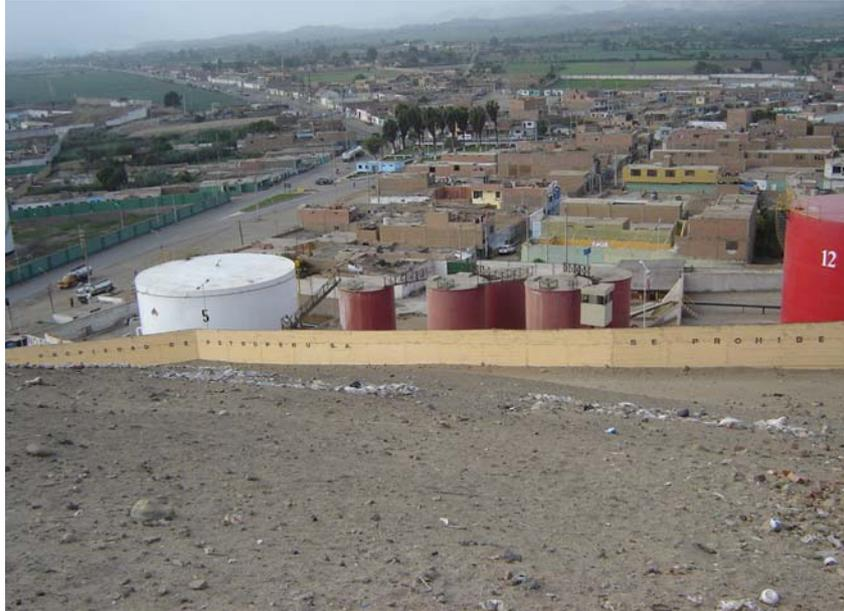
Foto 3. Supe Puerto. Tanques de Almacenamiento de Aguas contra Incendio. Consorcio Terminales GMBH.
