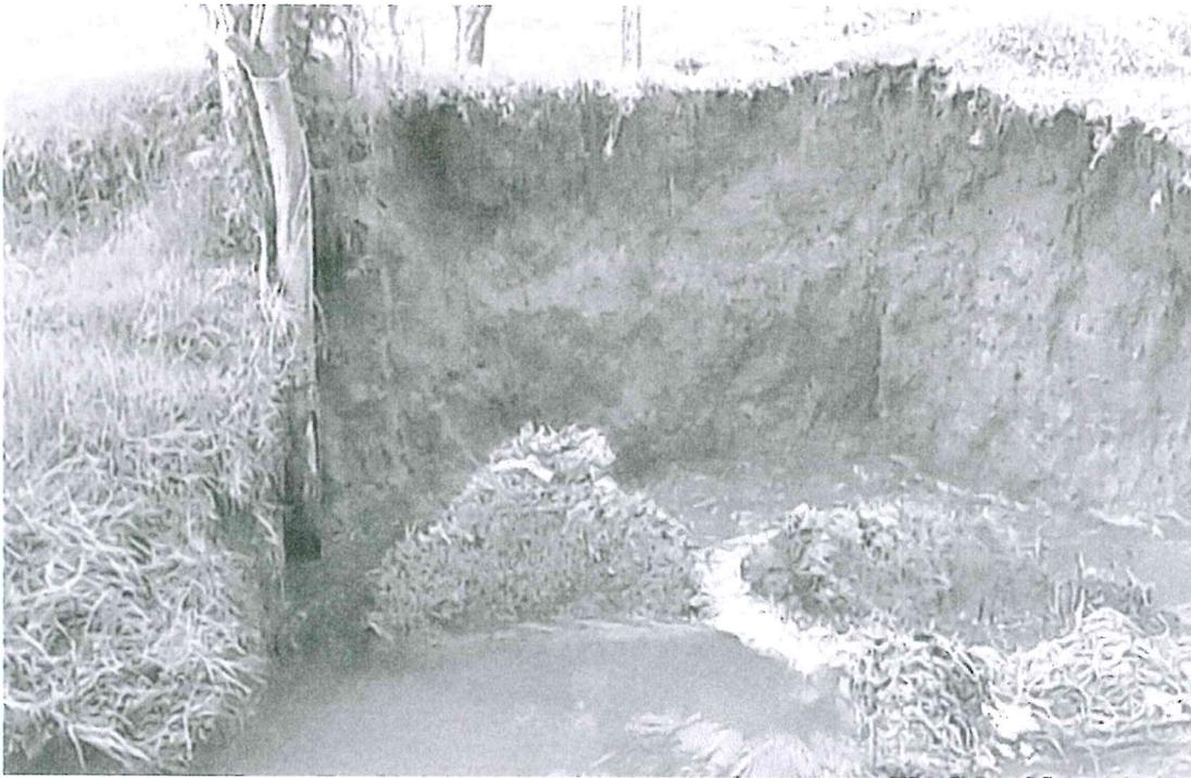
FOTO N° 04: SOCAVAMIENTO DEL RIO EN TRAMOS EN CURVA, NOTESE EL DERRUMBE DE LA PARTE ALTA DEL TERRENO AFECTADO.
