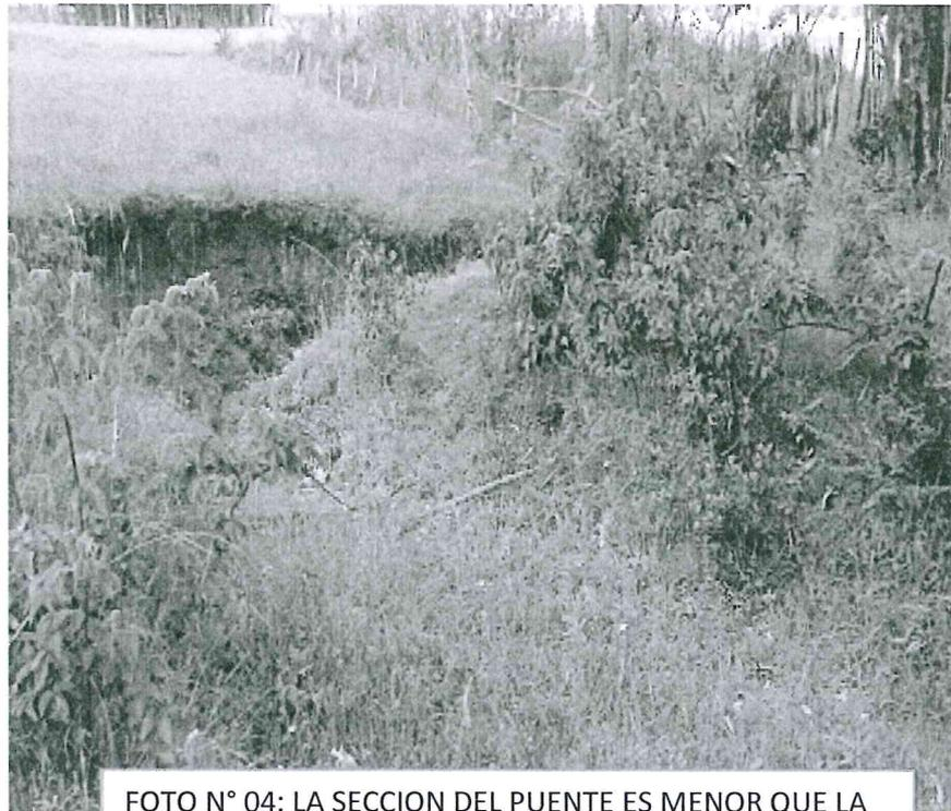
FOTO N° 04: LA SECCION DEL PUENTE ES MENOR QUE LA SECCION DEE LA QUEBRADA, EN CASO DE DESBORDE EL AGUA AFECTARÍA A VIVIENDAS Y TERRENOS ALEDAÑOS.
