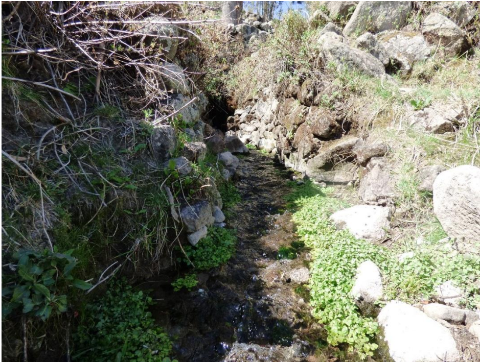
Foto 11. Surgencia de agua
