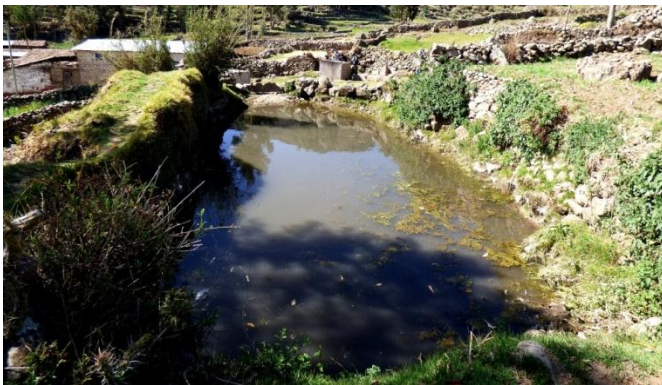
Foto 12. Estanque de agua sin revestimiento
