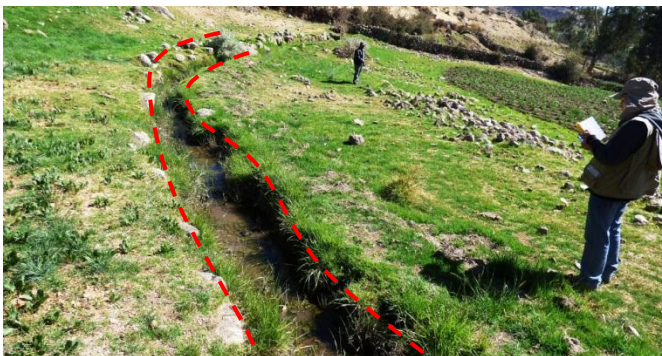
Foto 13. Canal de agua sin revestimiento usado para riego de cultivos.
