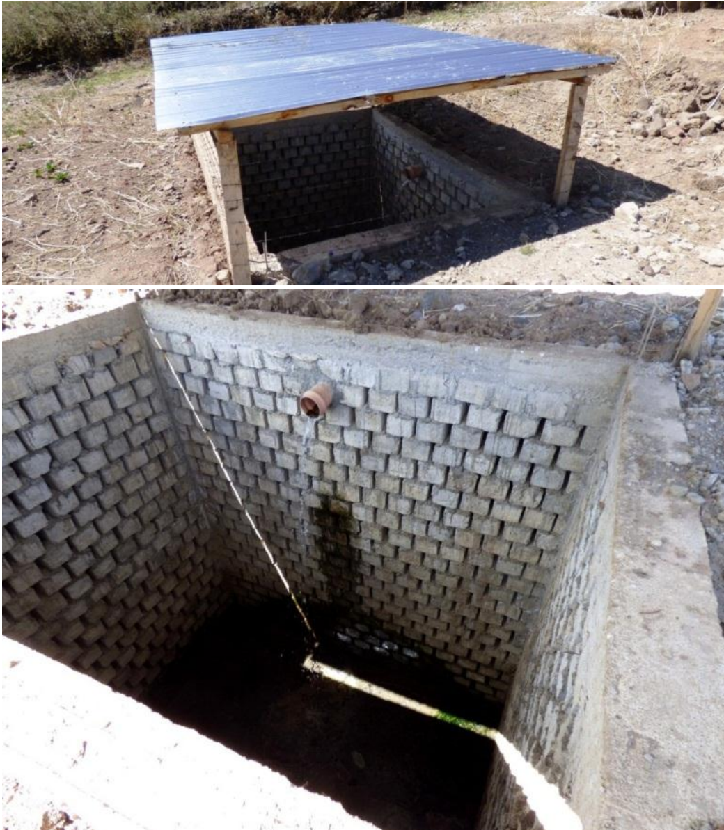
Foto 14. Poza de infiltración de aguas servidas tratadas ubicada a 250 metros de “Deslizamiento Ccochalla”.
