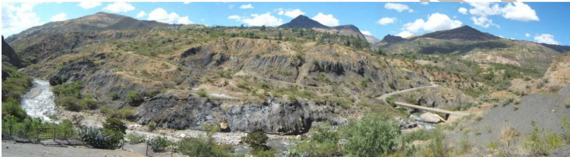
Foto N° 26 Deslizamiento, reptación y flujos de tierra en el sector de Socosbamba. Movimiento de carácter lento detonado con lluvias estacionales; afecta varios tramos de carretera que conduce a Piscobamba.
