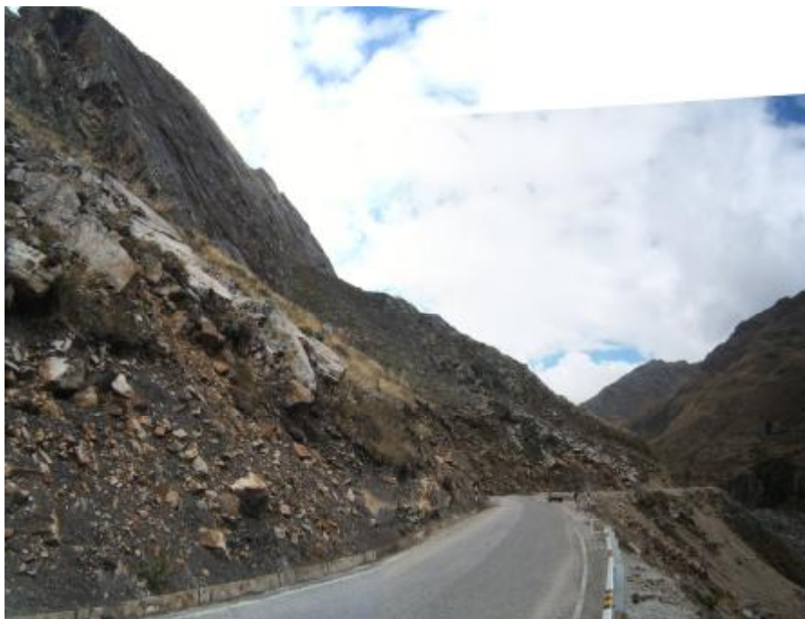
Foto N° 6 Vistas del sector del valle del río Vizcarra; muestra laderas con deslizamientos y derrumbes en los cortes de carretera entre Huallanca y Huanzalá.
