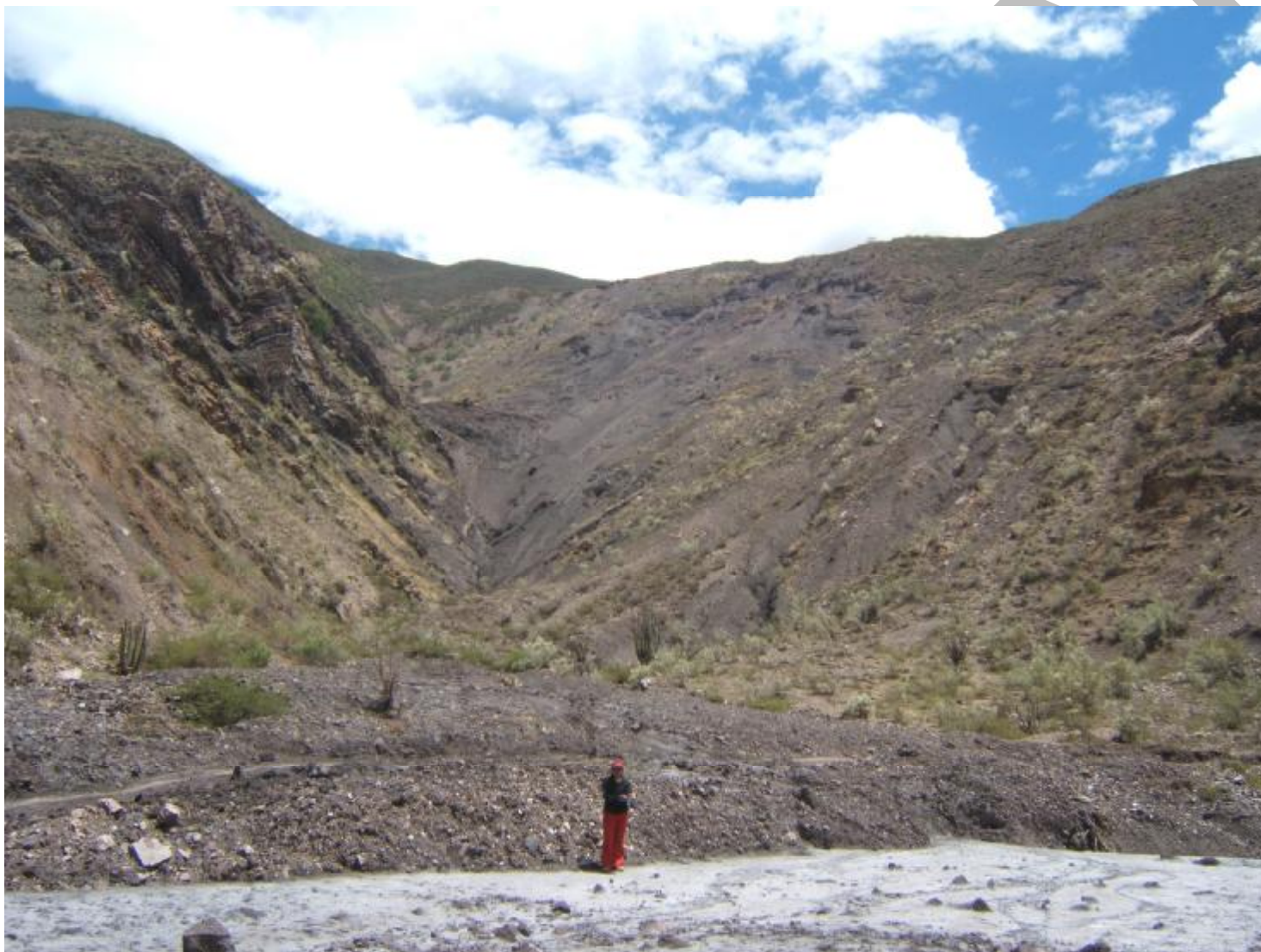
Foto N° 32 Huayco en el sector de Huallanga; derrumbes activos que generan periódicamente flujos obstruyendo tramo de carretera Sihuas-Huacrachuco.
