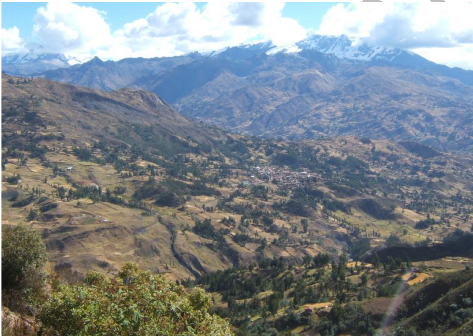
Foto N° 10 Vista de la localidad de San Luis ubicada en el cuerpo de un antiguo deslizamiento; movimientos lentos ocurren en el período de lluvias afectando la carretera y pie del valle, parte del poblado y en el sector superior.
