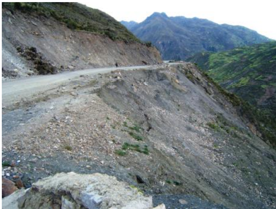
Foto Nº 20 Vistas de la zona del Mirador Bandera, afectada por deslizamientos y caídas de rocas, carretera a Chavín.
