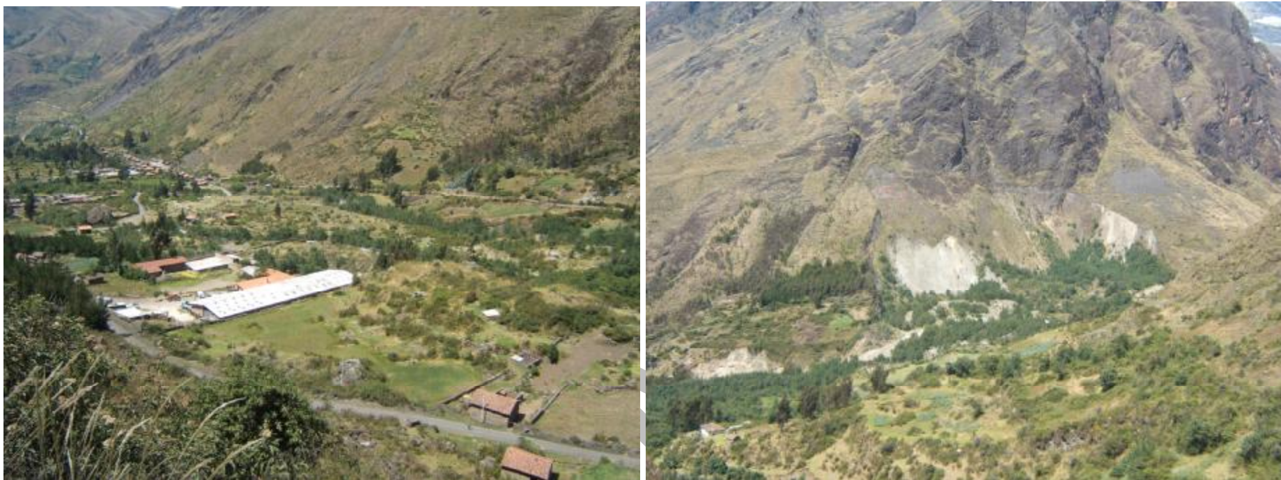
Foto Nº 4 Huayco en la quebrada Potaca y Coyo. Se distingue material de flujo reciente, carretera Carhuáz-Chacas. En la vista derecha del deslizamiento de Pompey que represó la quebrada Vesubio en 1975.
