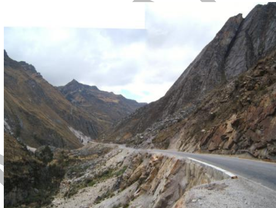
Foto N° 6 Vistas del sector del valle del río Vizcarra; muestra laderas con deslizamientos y derrumbes en los cortes de carretera entre Huallanca y Huanzalá.
