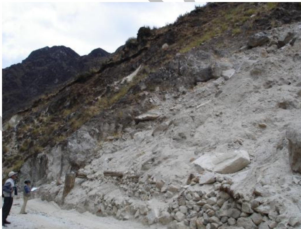
Foto N° 28 Carretera hacia la laguna Pelagatos, que se ve seriamente afectada por deslizamientos y derrumbes
