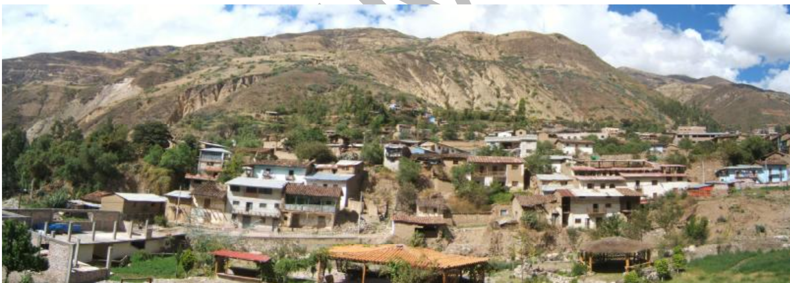
Foto N° 38 Dos vistas del sector de Sihuas afectado por erosión fluvial, derrumbes y erosión de laderas
