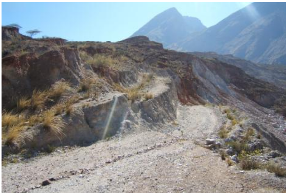
Foto N° 15 Dos vistas de cerca del proceso de deslizamiento en los sectores de Tres Cruces-La Pampa. En la vista izquierda parte de la antigua carretera Yuracmarca-Sihuas hoy abandonada, y en la vista derecha las escarpas y saltos de terreno que dan hacia el sector de La Pampa.
