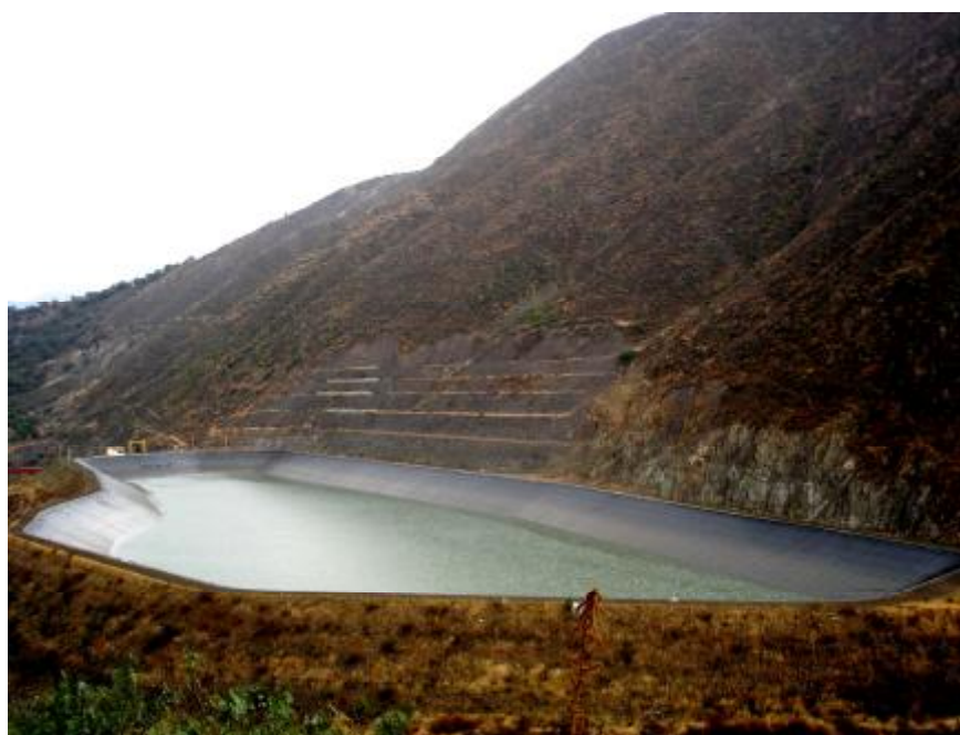
Foto N° 15: Represa de Duke Energy, afectada por un deslizamiento.
