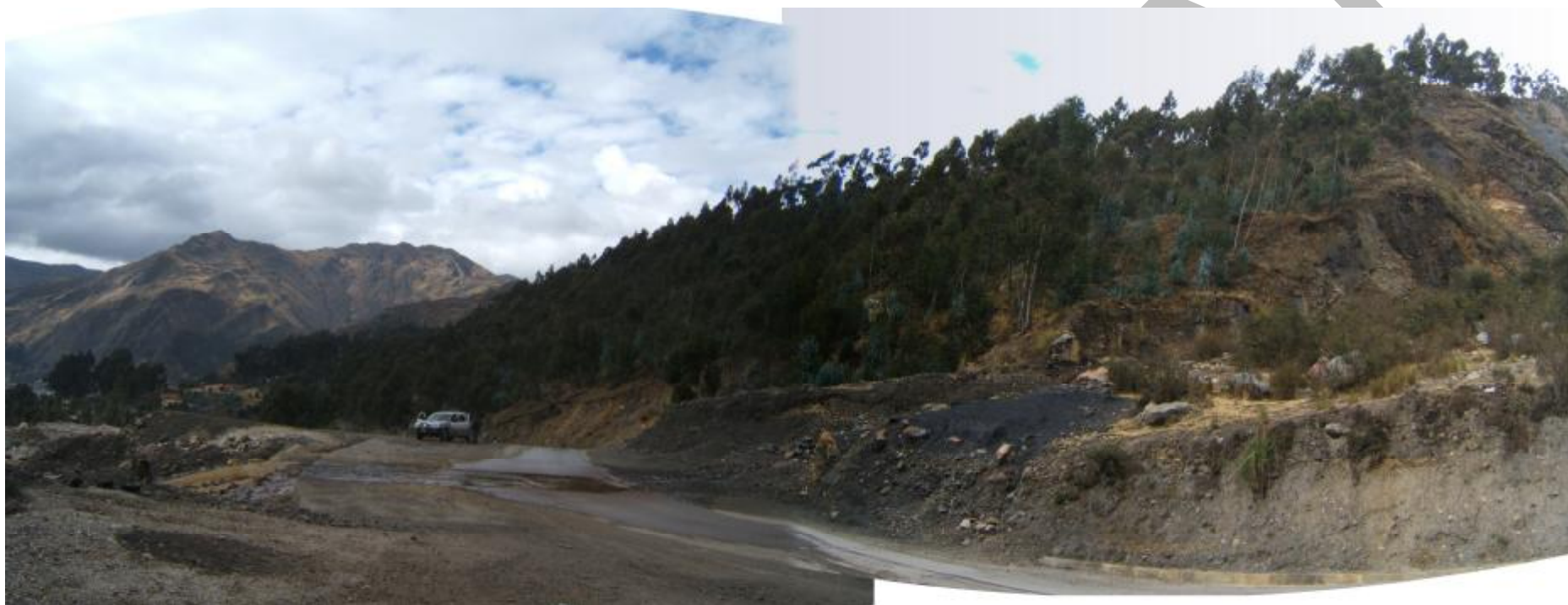
Foto N° 5 Huayco en la quebrada Yuracpuquio y derrumbes en el cerro Santa Cruz, afectan tramo de la carretera Huallanca – Mina Huanzalá.
