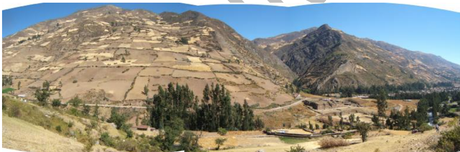
Foto N° 23 Sector del Templo y poblado de Chavín afectados por el aluvión de 1945 que descendió por la quebrada Huachecsa.
