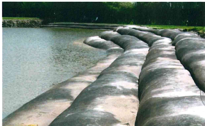
Imagen N° 11: Protección con geotubos
