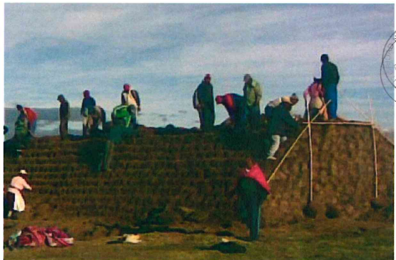
Imagen N° 17: Dique de bloques vegetativo
