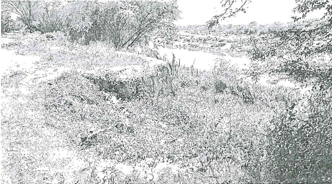
**Sector San Fernando viene siendo protegido por defensa viva, la cual no soporta los máximos caudales del río Chira, por lo cual se viene erosionando el talud de la ribera**
