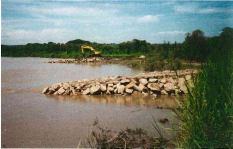
Imagen N° 15: Protección con espigones de gaviones
