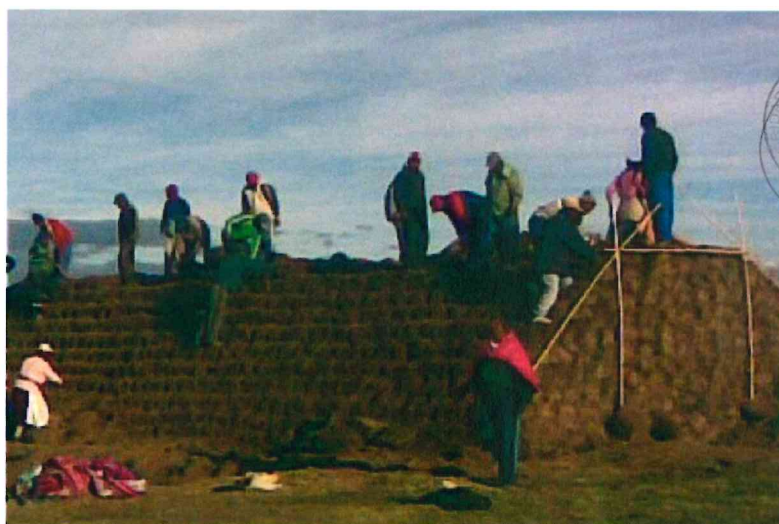
Imagen N° 17: Dique de bloques vegetativo
