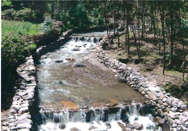
Imagen 18: Disipadores de Energía
