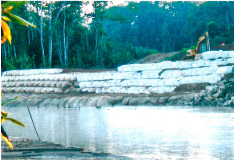
Imagen N° 12: Protección con geobolsas
