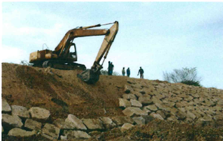
Imagen 10: Conformación de dique enrocado
