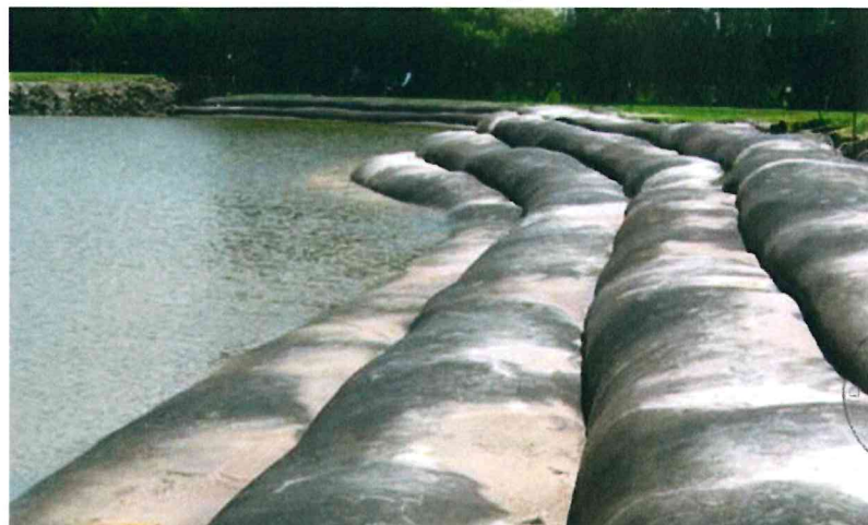
Imagen N° 11: Protección con geotubos
