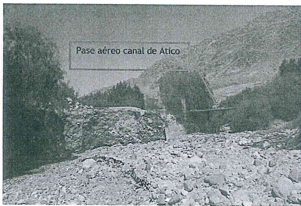
VISTA: RIO ATICO HACIA AGUAS ABAJO, TRAMO 2 SANTA ELENA
