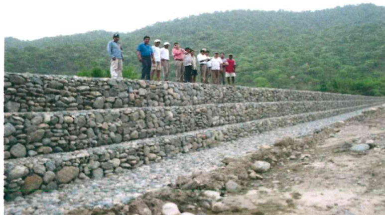
Imagen N° 13: Protección con gaviones
