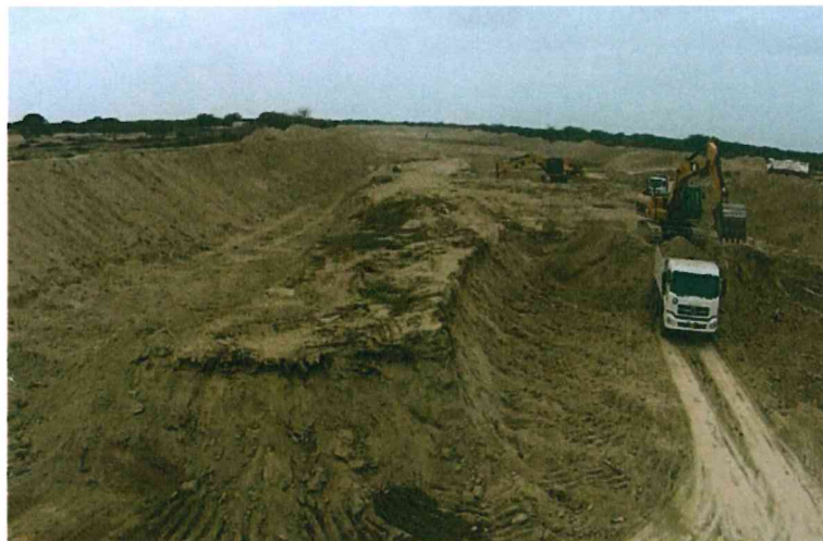
Imagen N° 20: Extracción de material sedimentado de cauce
