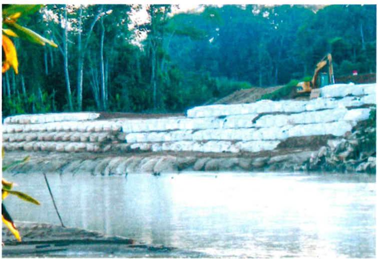
Imagen N° 12: Protección con geobolsas
