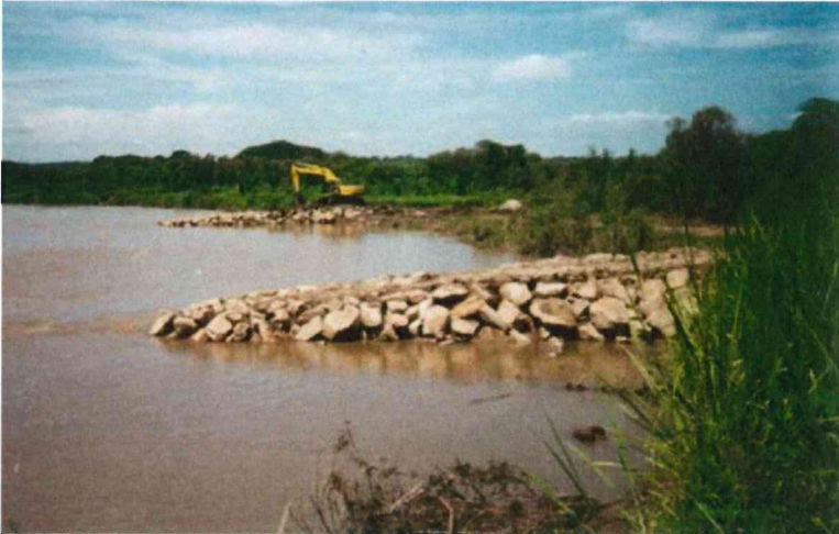
Imagen N° 15: Protección con espigones de gaviones
