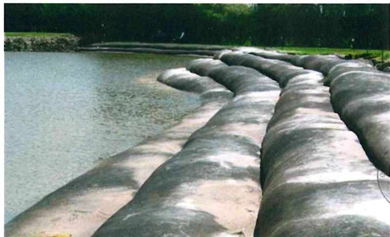
Imagen N° 11: Protección con geotubos
