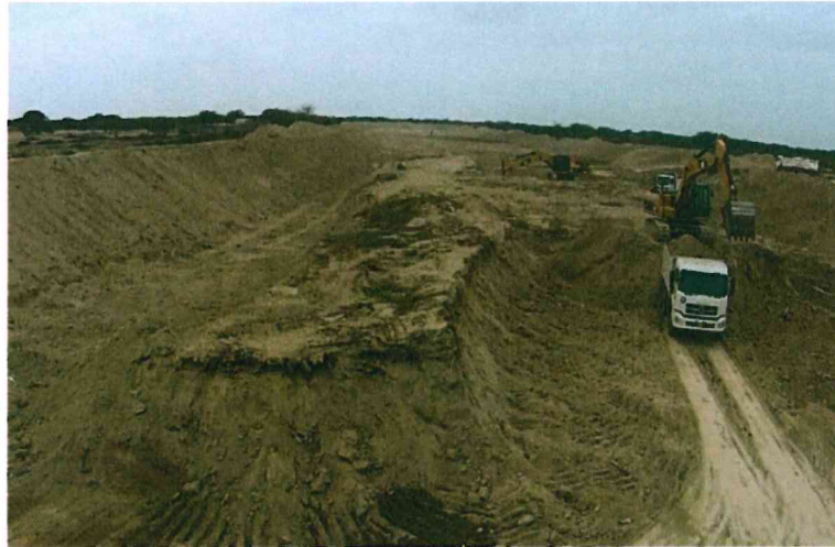
Imagen N° 20: Extracción de material sedimentado de cauce
