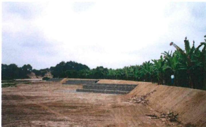
Imagen N° 14: Protección con espigones de gaviones
