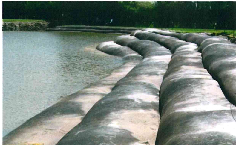
Imagen N° 11: Protección con geotubos
