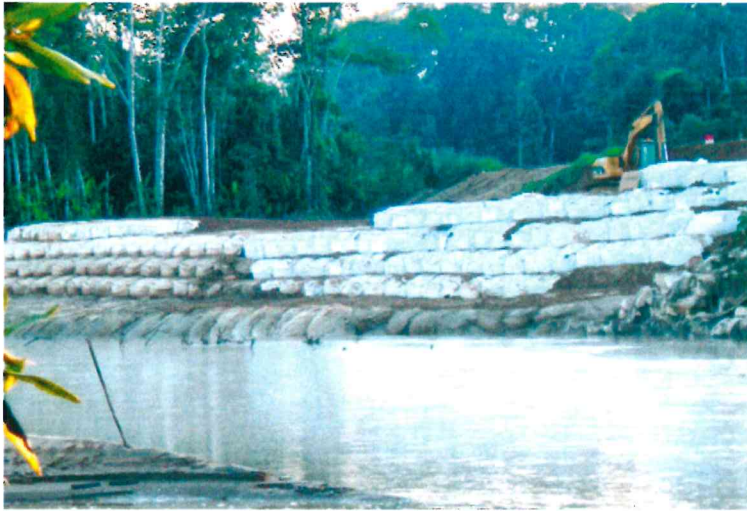
Imagen N° 12: Protección con geobolsas
