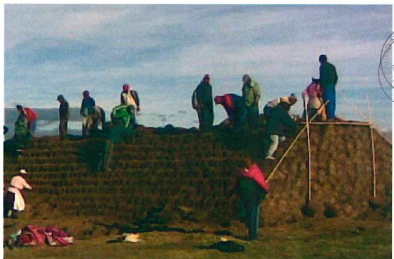
Imagen N° 17: Dique de bloques vegetativo
