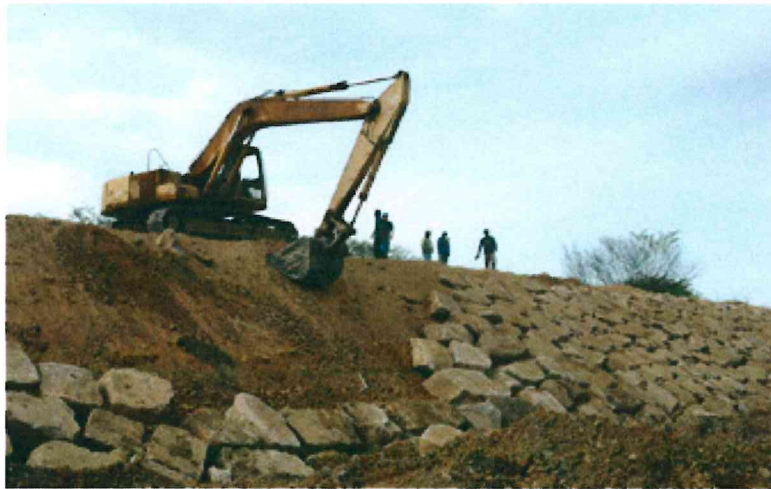
Imagen 10: Conformación de dique enrocado
