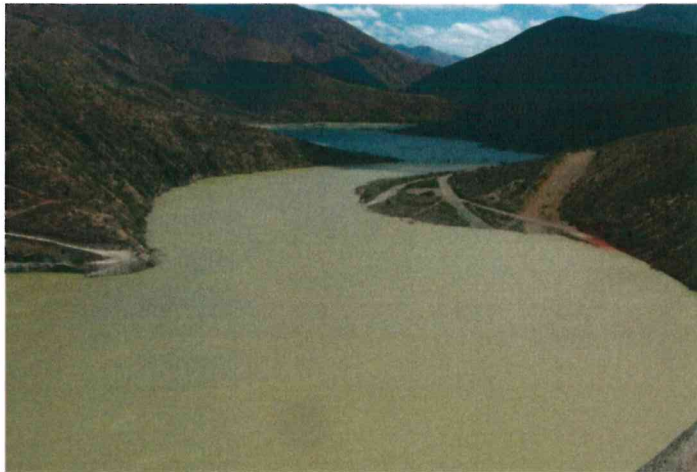
Imagen 06: Reducción de la capacidad de presas
