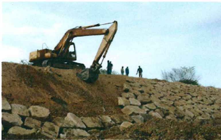
Imagen 10: Conformación de dique enrocado
