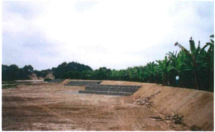
Imagen N° 14: Protección con espigones de gaviones
