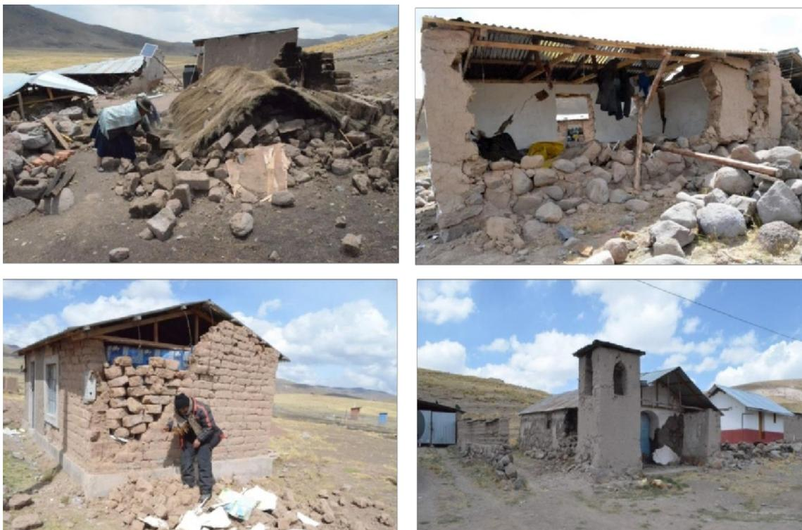
Figura 4.- Imágenes de viviendas dañadas por el sismo de Lampa, fisuras y caída de paredes de adobe (imágenes El Comercio).
