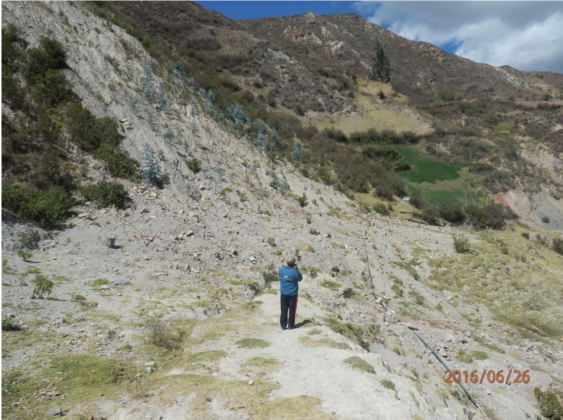
Foto 3 Vista al pie del derrumbe donde se observa material detrítico
