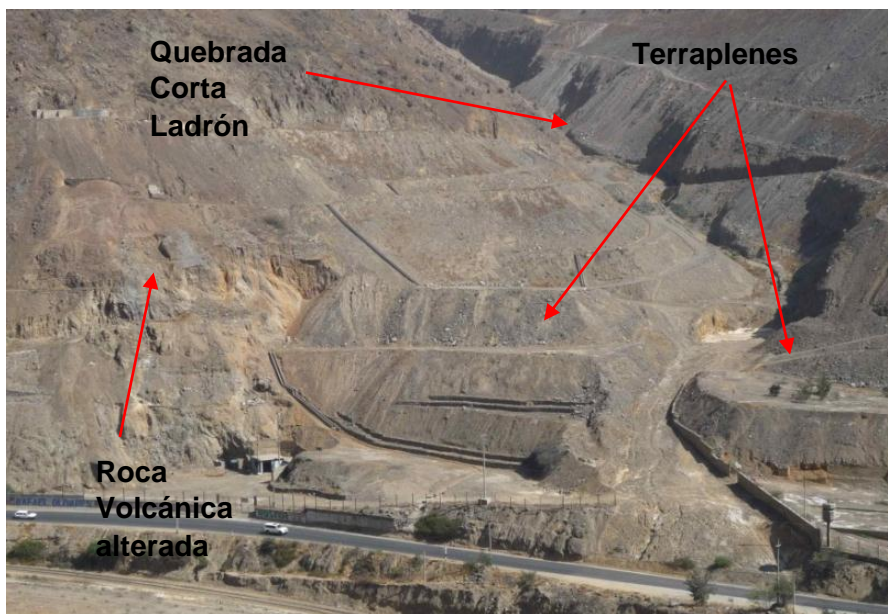
Foto 4. Terraplenes construidos para depositar material de relave y estéril de la mina Leonila
