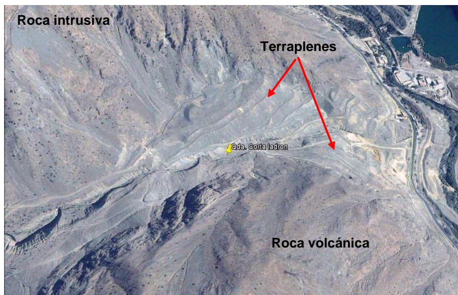
Figura 5. Vista de los diversos terraplenes construidos en la quebrada Corta Ladrón
