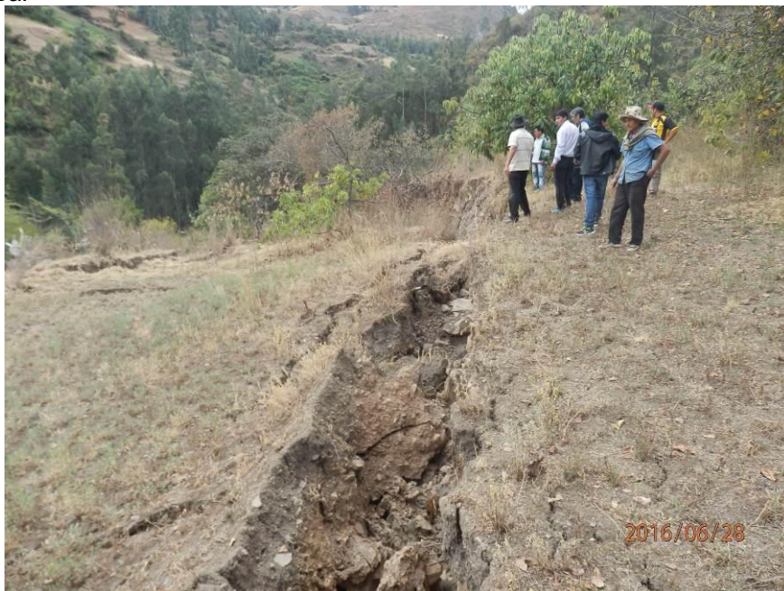
Foto 9 Vista tomada con dirección norte al pie del deslizamiento Cachipampa, se observa escarpa principal y salto vertical.
