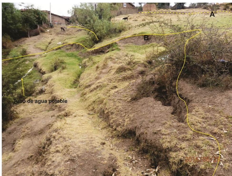
Foto 4. Vista de la parte superior del deslizamiento Huayobamba, se observan escarpas A de longitud 107 m, donde afecta paredes de vivienda y terrenos de cultivo y pastoreo; escarpa B de longitud 200 m. afecta caminos de acceso y tubería de agua potable.
