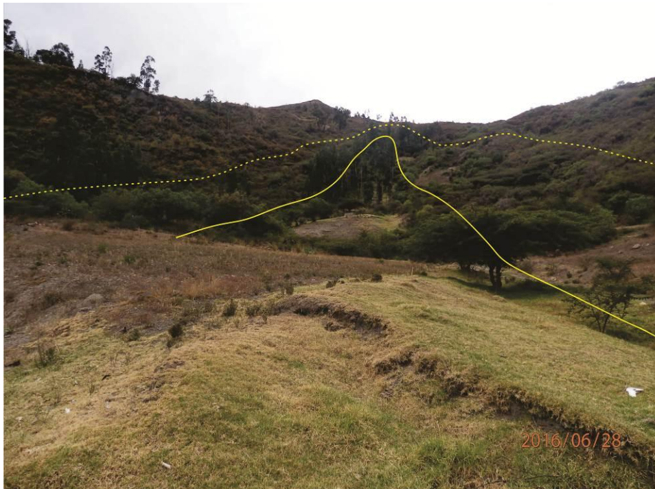
Foto 7 Vista tomada con dirección este, se observa parte superior del deslizamiento en el Sector Cachipampa.
