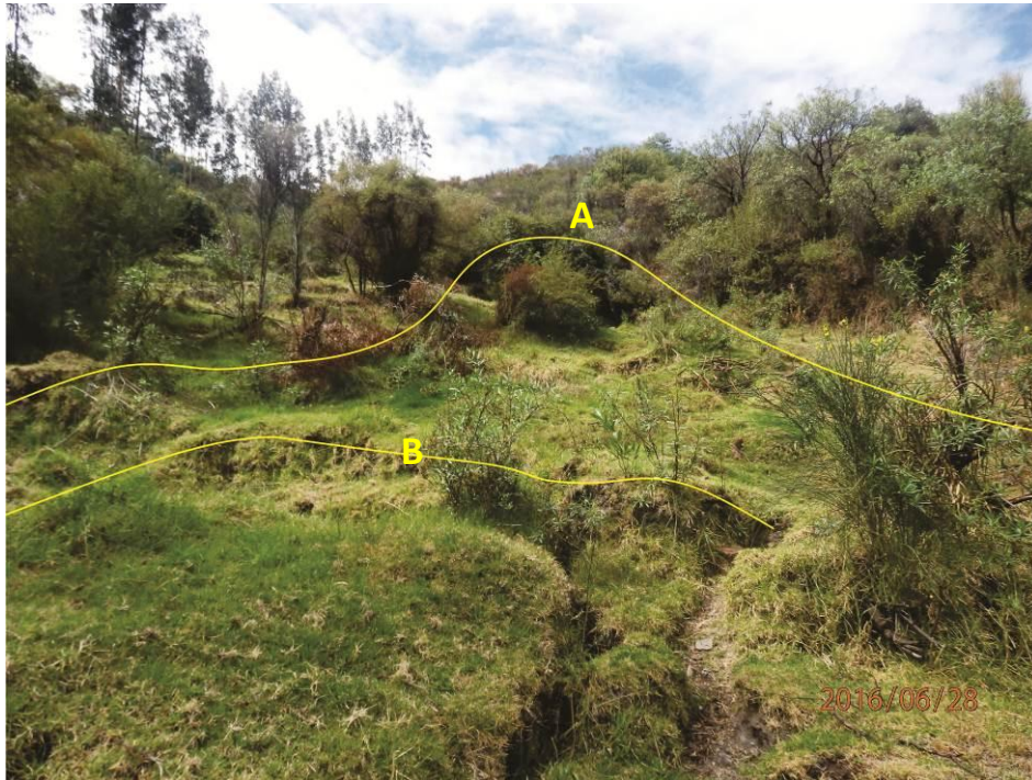
Foto 6 Vista tomada con dirección este en el sector Cachipampa, se observa escarpa A de longitud 145 m., escarpa B de longitud 125 m. ambos con dirección de desplazamiento norte 285°, reactivación en la parte superior del deslizamiento.
