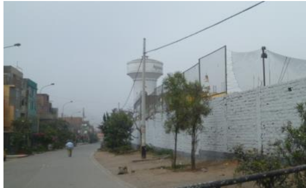
Figura 109. Tanque de agua.
