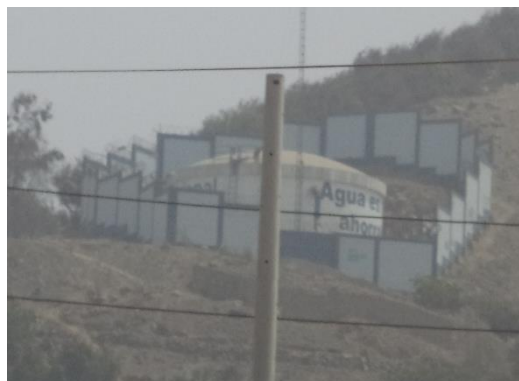
Figura 212. Tanque de agua – SEDAPAL.
