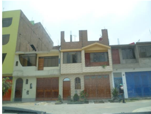
Figura 19. Viviendas de albañilería de dos niveles con losas aligerada.
