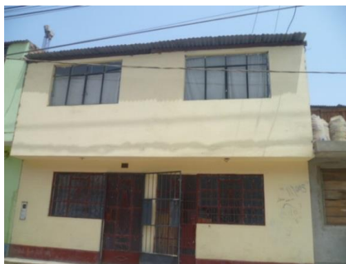
Figura 47. Viviendas de albañilería de dos niveles con cubiertas ligeras en el último nivel en el sector 15.
