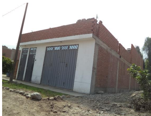
Figura 44. Viviendas de albañilería de un nivel en sector 14.
