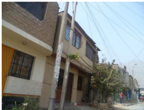
Figura 46. Viviendas de albañilería de dos niveles con losas aligerada del sector 15.
