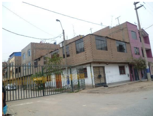
Figura 20. Viviendas de albañilería de dos niveles con cubiertas ligeras en el último nivel.
