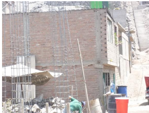
Figura 22. Vivienda de albañilería de dos niveles con cubierta ligera en el último nivel.
