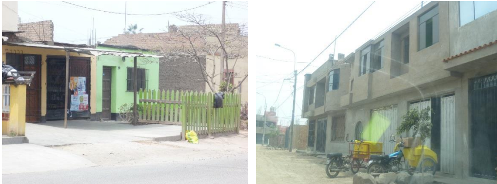
Figura 36. Edificaciones de uno y dos niveles techo aligerado y calamina.
