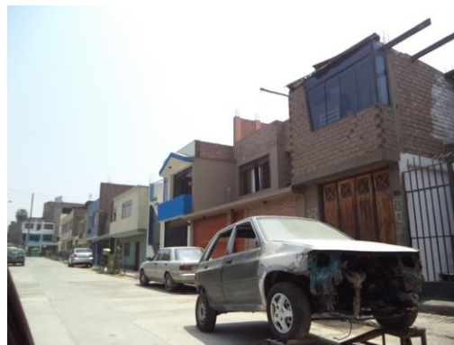
Figura 24. Vivienda de mampostería de 02 niveles.
