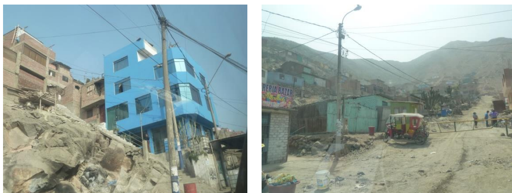
Figura 32. Construcciones en albañilería y madera en laderas de cerro.
