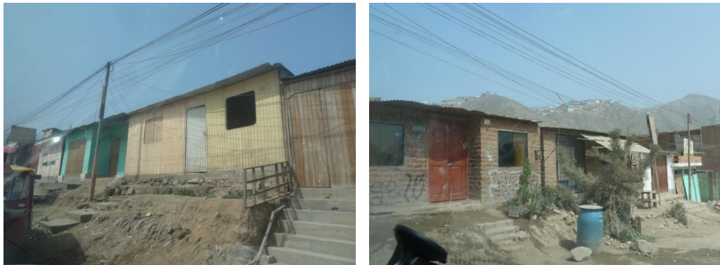
Figura 31. Viviendas de madera y en albañilería informal.
