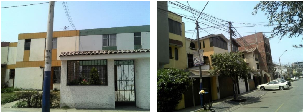
Figura 10. Edificaciones Vivienda del Sector 01.
