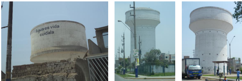
Figura 158. Tanques de agua.
