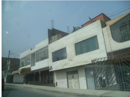
Figura 45. Vivienda de mampostería de 02 niveles del sector 15.
