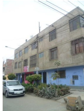
Figura 16. Vivienda de albañilería con losa aligerada.
