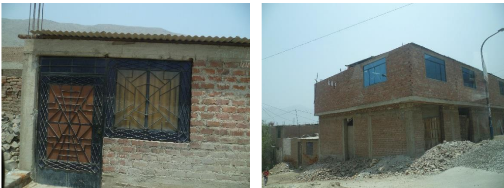
Figura 41. Viviendas construidas con ladrillo artesanal sólido y diafragmas flexibles.
