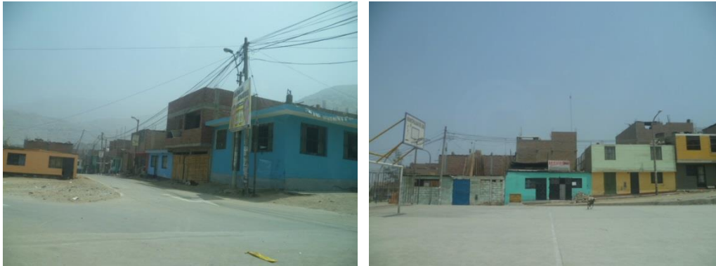
Figura 50. Edificaciones de albañilería, uso predominante como vivienda.
