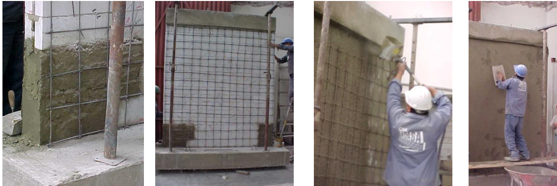
Figura 251. Detalle de refuerzo sobre las caras del muro.
