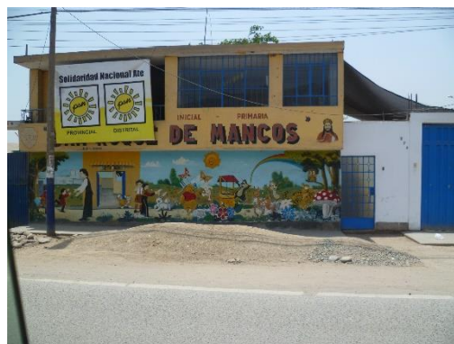
Figura 183. Colegio San Roque de Mancos.
