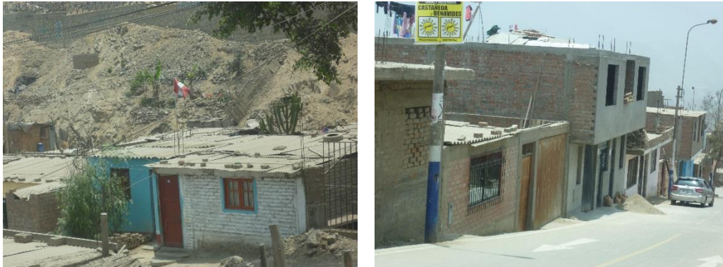
Figura 40. Edificaciones de uno y dos niveles.
