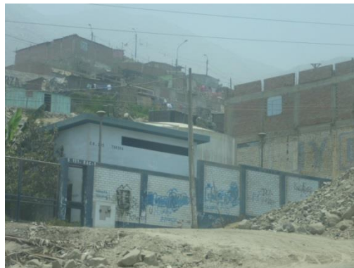
Figura 241. Reservorio de agua.
