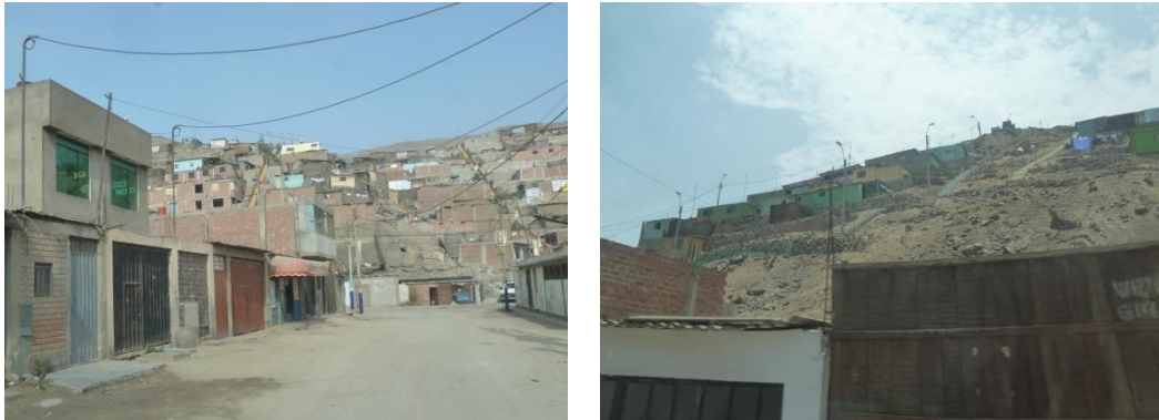
Figura 28. Construcciones en albañilería y madera en las laderas de los cerros.
