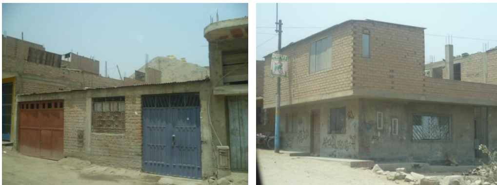
Figura 51. Edificaciones de uno y dos niveles con techo de calamina.
