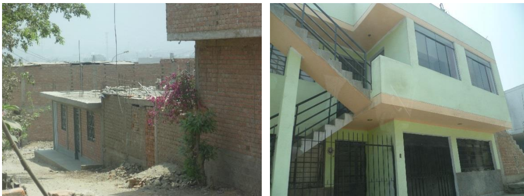
Figura 39. Edificaciones de albañilería, uso como vivienda.
