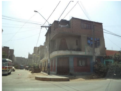
Figura 26. Viviendas de albañilería de tres niveles sin tarrajeo.
