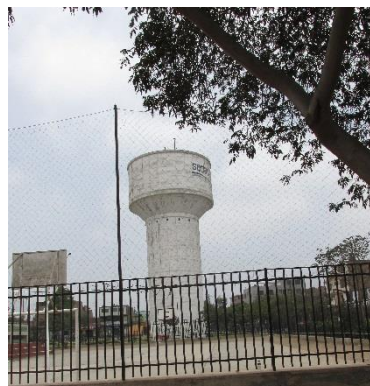
Figura 99. Tanque de agua.
