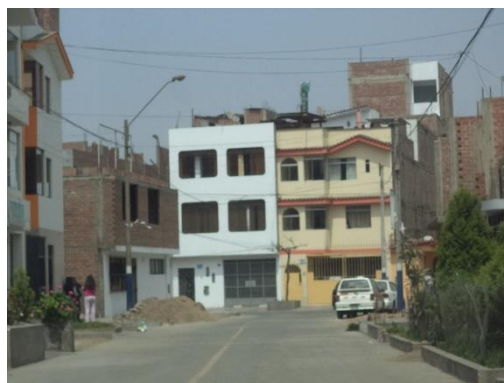
Figura 25. Viviendas de albañilería de tres niveles con tarrajeo.
