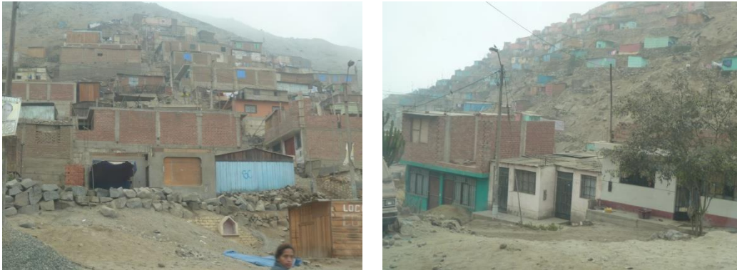
Figura 55. Construcciones en albañilería y madera en laderas de cerro.
