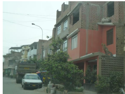
Figura 27. Viviendas de albañilería confinada del Sector 08.
