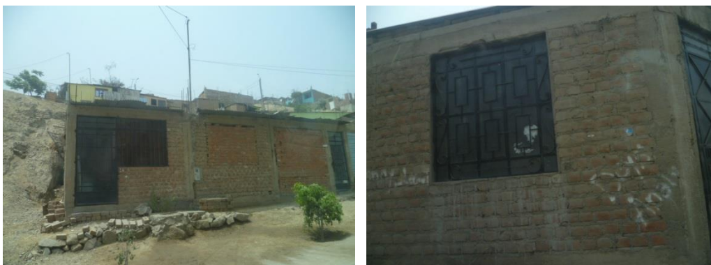
Figura 52. Viviendas construidas con ladrillo artesanal sólido.
