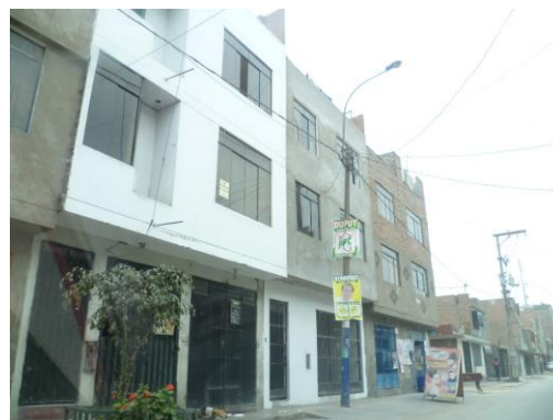
Figura 18. Vivienda de mampostería de 03 niveles.
