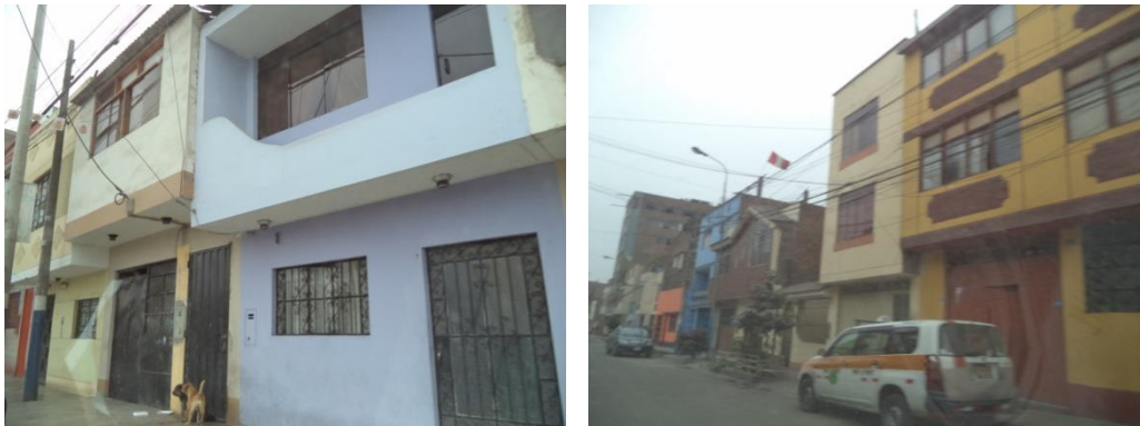
Figura 12. Edificaciones de uno, dos y tres niveles.
