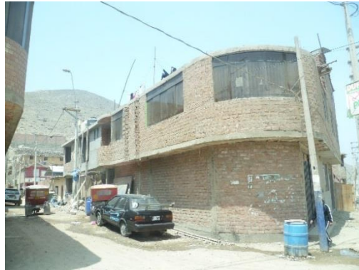
Figura 21. Vivienda de albañilería con losa aligerada.
