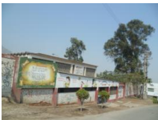
Figura 93. Centro de recreación familiar Tahuantinsuyo IV Zona.
