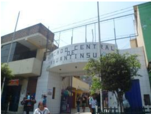
Figura 138. Mercado Central de Tahuantinsuyo.
