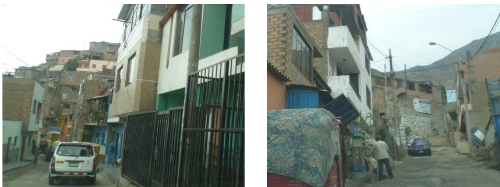
Figura 60. Viviendas en laderas de cerros y muros de contención en concreto.
