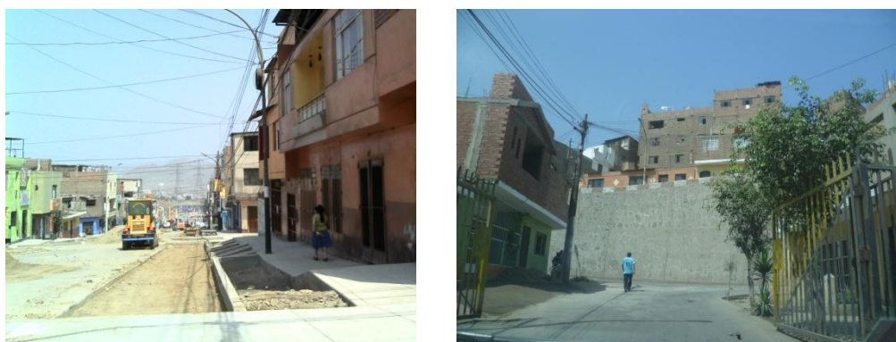
Figura 40. Terreno en pendiente y muros de contención.
