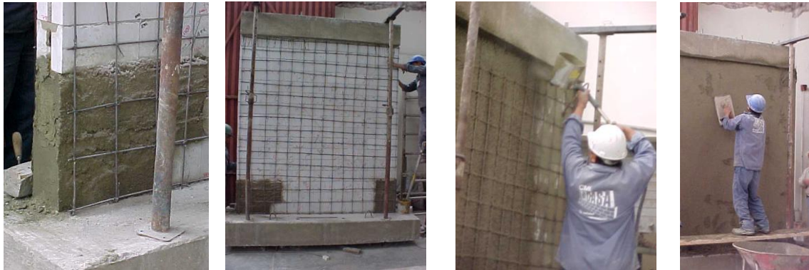
Figura 200. Detalle de refuerzo sobre las caras del muro.
