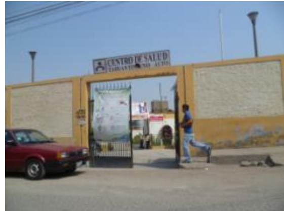
Figura 141. Centro de Salud Tahuantinsuyo Alto.
