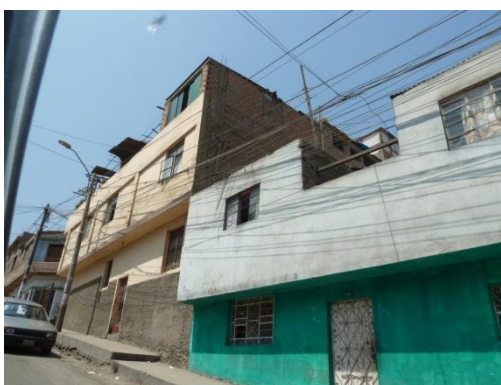
Figura 56. Terreno en pendiente.
