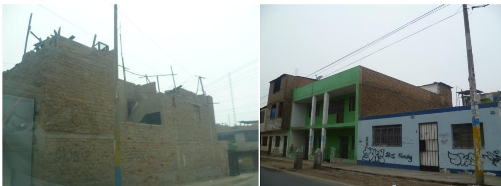
Figura 20. Construcción informal en albañilería.
