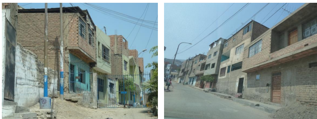
Figura 54. Viviendas típicas del Sector 15.
