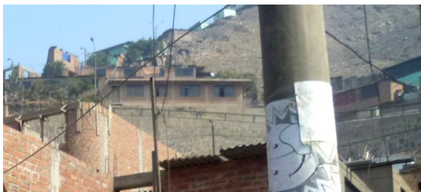
Figura 15. Muros de contención de concreto.
