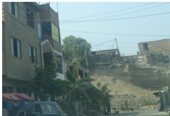
Figura 14. Muros de contención en piedra apilada.
