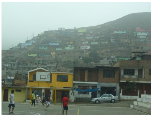
Figura 12. Construcción de viviendas en laderas de los cerros.
