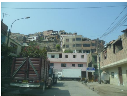
Figura 41. Construcción de viviendas en laderas de los cerros.
