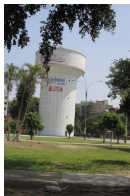
Figura 165. Reservorio de agua.
