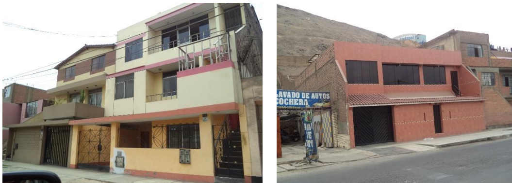
Figura 14. Edificaciones del sector 4 de tres y dos pisos.
