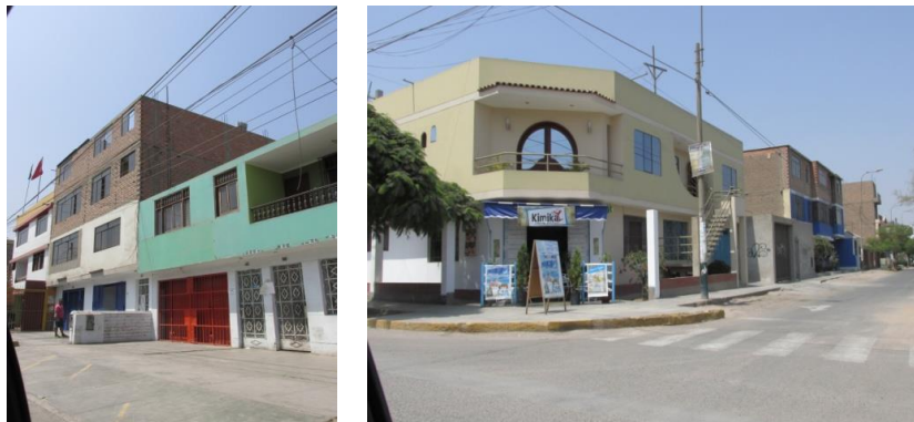
Figura 46. Edificaciones de albañilería.
