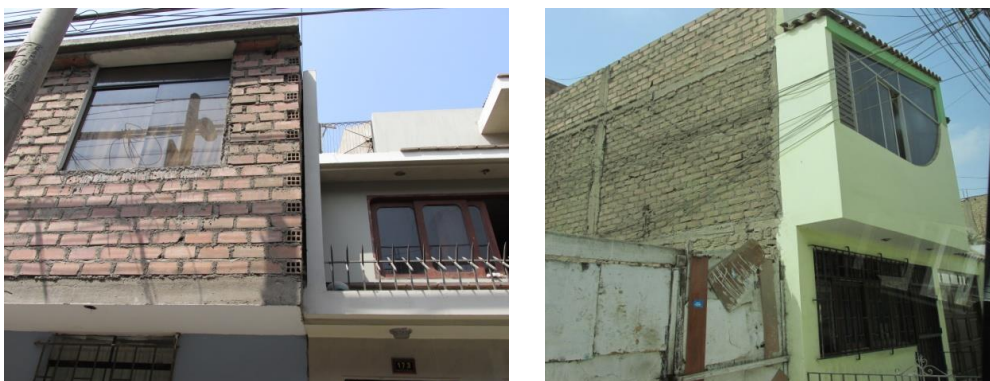
Figura 29. Viviendas construidas con ladrillo pandereta (izquierda) y ladrillo artesanal sólido (derecha).
