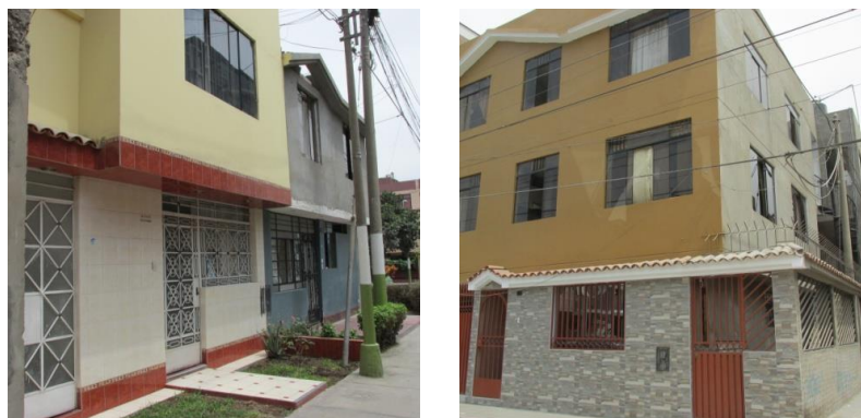
Figura 31. Edificaciones de dos y tres niveles.
