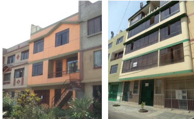
Figura 36. Edificaciones del sector 13, de tres pisos, hasta 5 pisos para viviendas.
