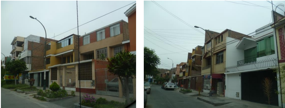
Figura 17. Viviendas típicas del Sector 05.
