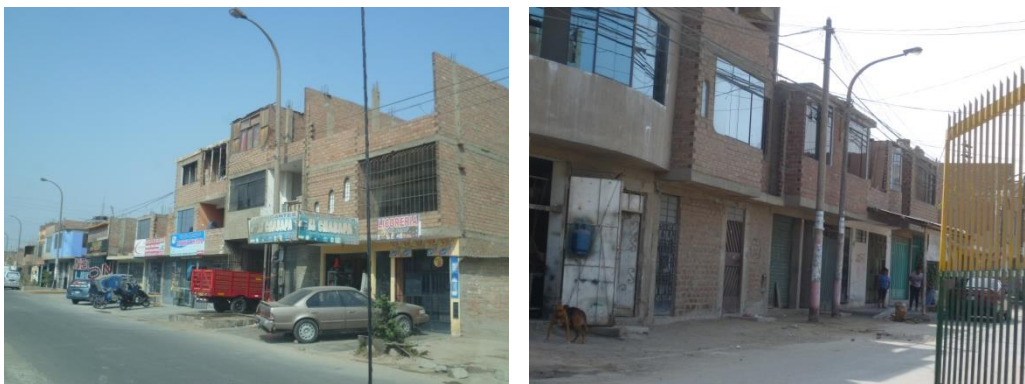
Figura 39. Viviendas típicas del Sector 14.
