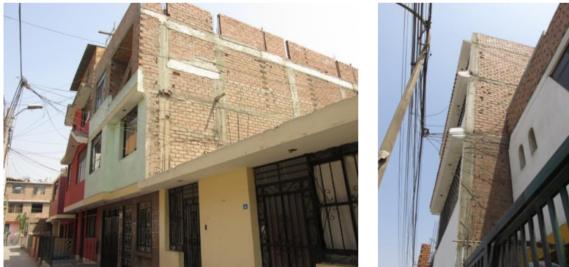
Figura 44. Viviendas construidas con ladrillo pandereta y ladrillo artesanal sólido.
