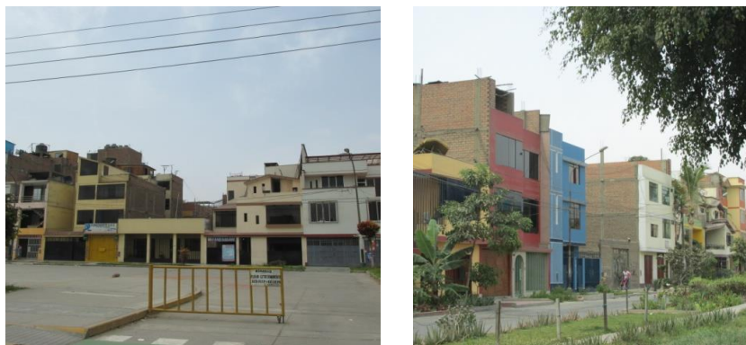
Figura 30. Edificaciones de albañilería.
