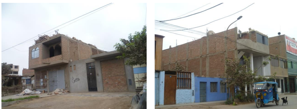
Figura 51. Viviendas construidas con ladrillo pandereta y ladrillo artesanal sólido.
