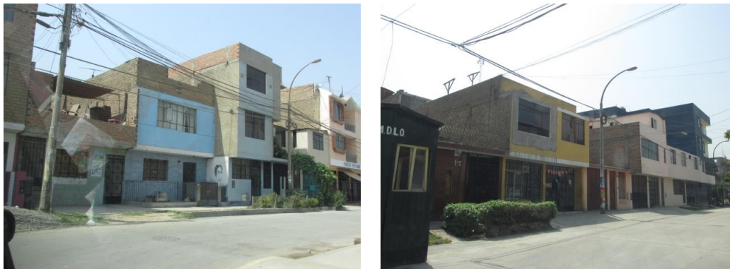
Figura 42. Edificaciones de albañilería.
