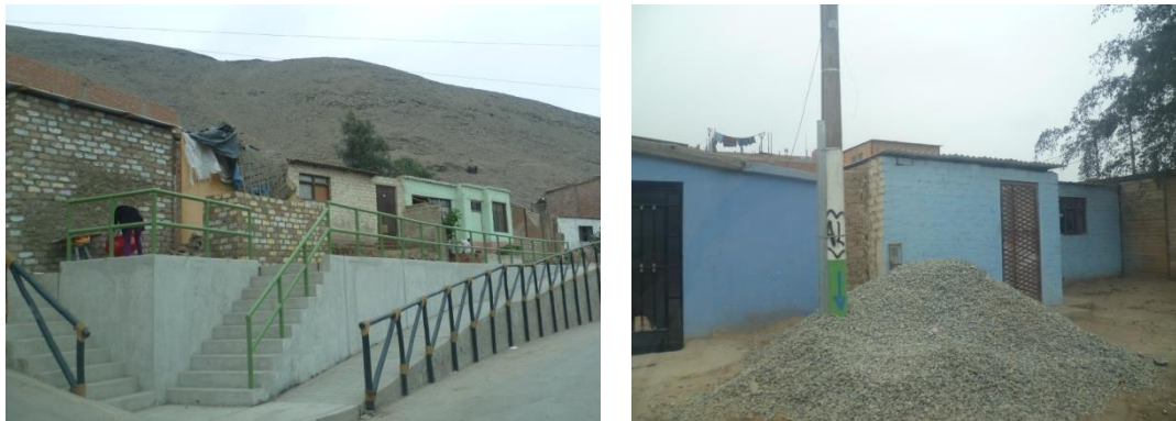
Figura 56. Viviendas de adobe.
