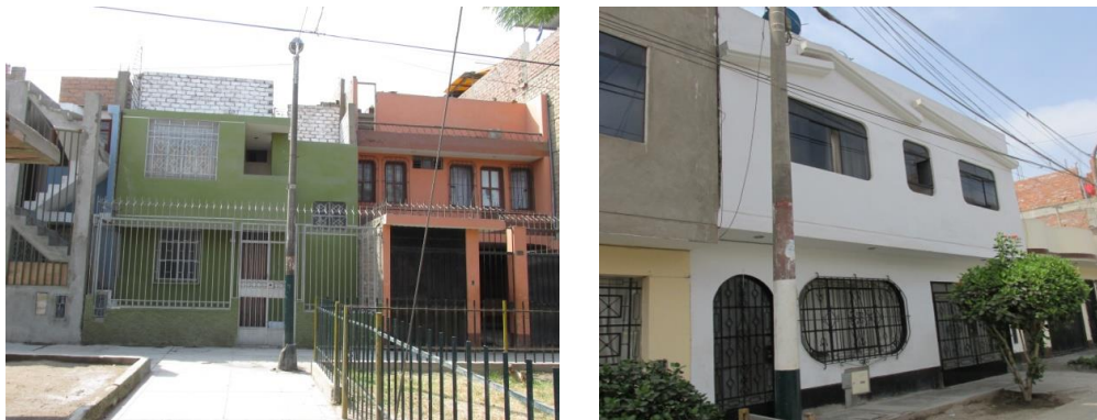
Figura 28. Edificaciones de dos niveles con techo aligerado.
