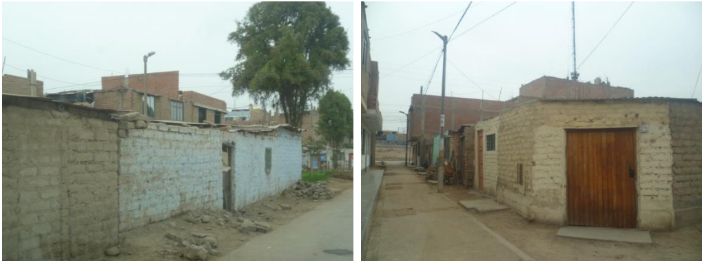
Figura 62. Viviendas de adobe.
