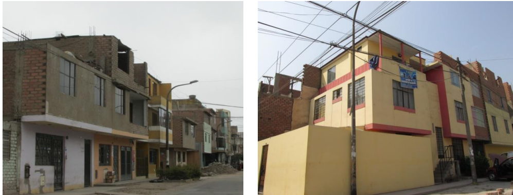
Figura 27. Edificaciones de albañilería del sector 10.
