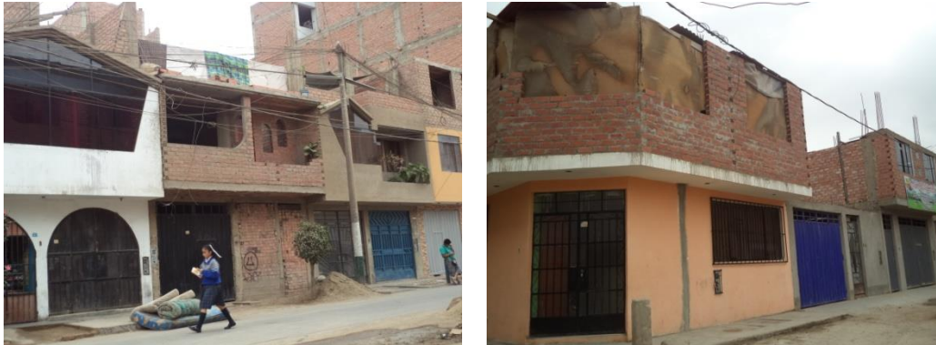
Figura 53. Viviendas de albañilería confinada del Sector 20.
