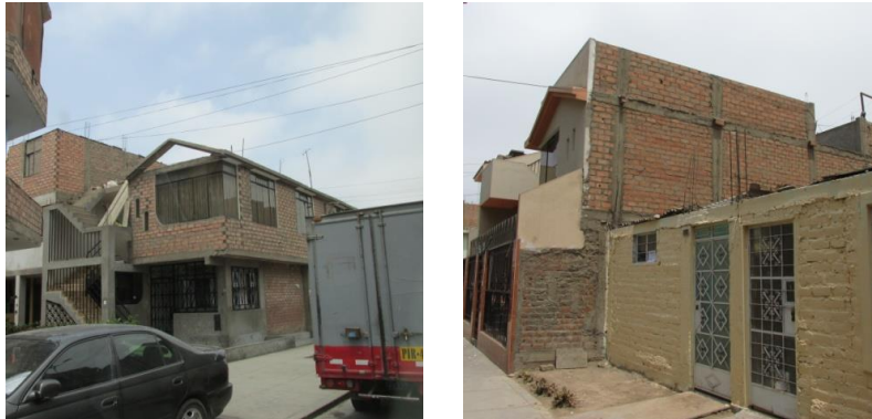
Figura 32. Viviendas construidas con ladrillo pandereta y ladrillo artesanal solido.
