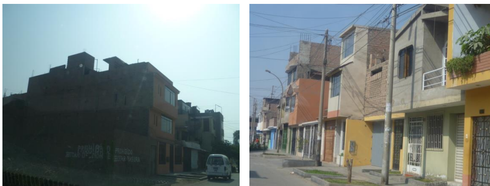
Figura 57. Viviendas típicas del Sector 22.
