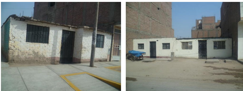
Figura 40. Viviendas de adobe.
