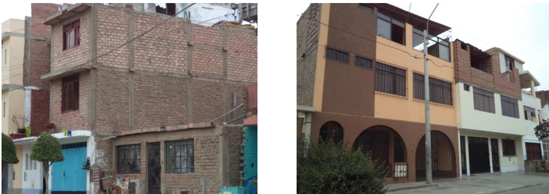
Figura 10. Viviendas de albañilería confinada del Sector 01.
