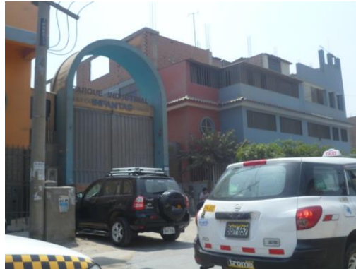
Figura 45. Viviendas de albañilería confinada del Sector 16.
