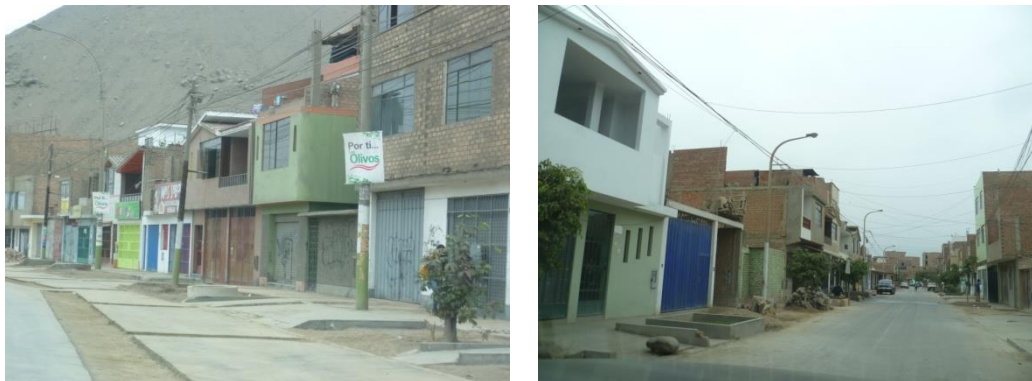
Figura 54. Viviendas típicas del Sector 21.
