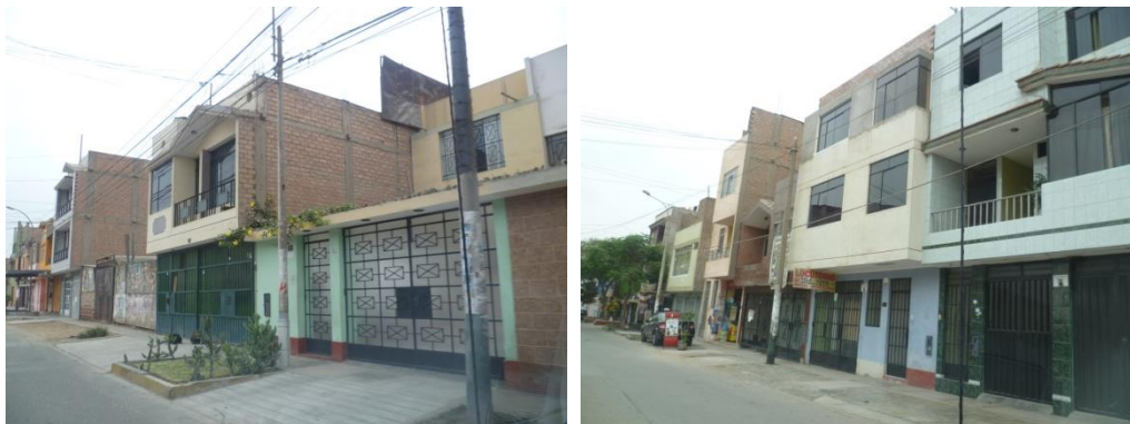
Figura 61. Viviendas típicas del Sector 24.
