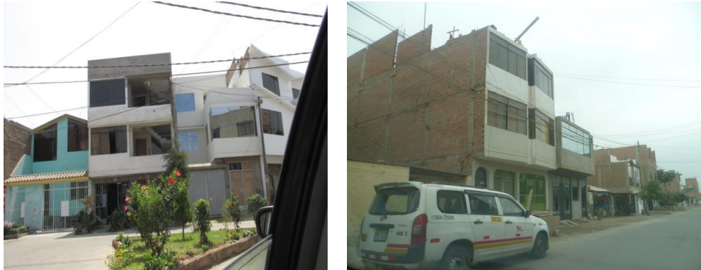
Figura 49. Edificaciones de albañilería.
