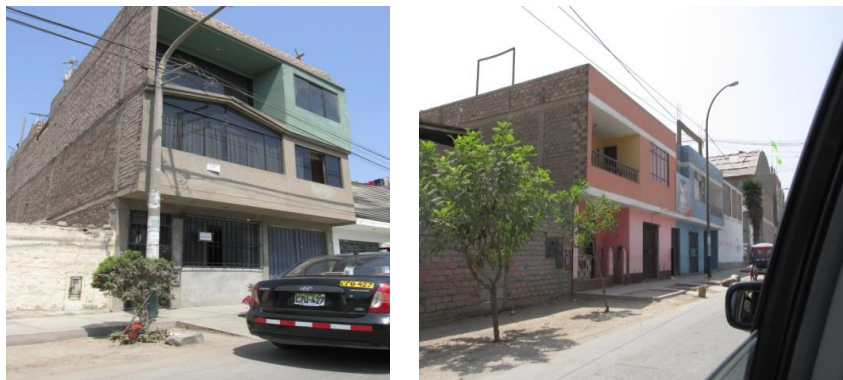
Figura 48. Viviendas construidas con ladrillo pandereta y ladrillo artesanal sólido.
