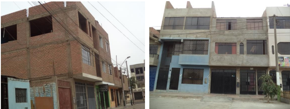
Figura 52. Viviendas de albañilería confinada del Sector 19.
