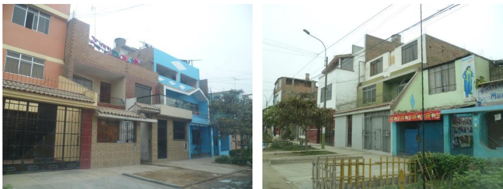
Figura 59. Viviendas típicas del Sector 23.
