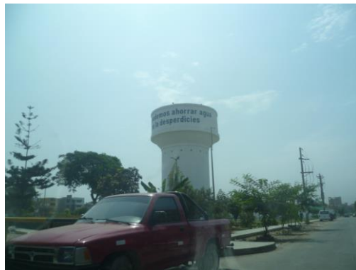
Figura 134. Tanque de agua del sector 09.
