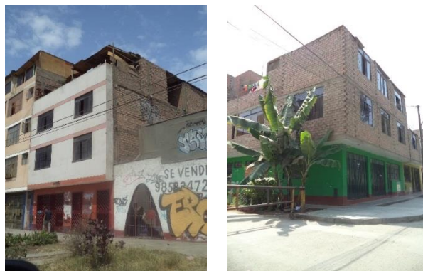
Figura 38. Uso de cobertura liviana sobre las paredes del último nivel.
