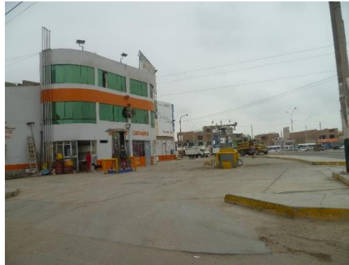
Figura 34. Centro de expendio de combustible.
