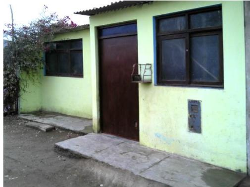
**Figura 32.** Vivienda de albañilería.
