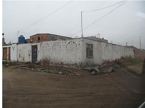
Figura 19. Edificaciones construidas con ladrillo artesanal.
