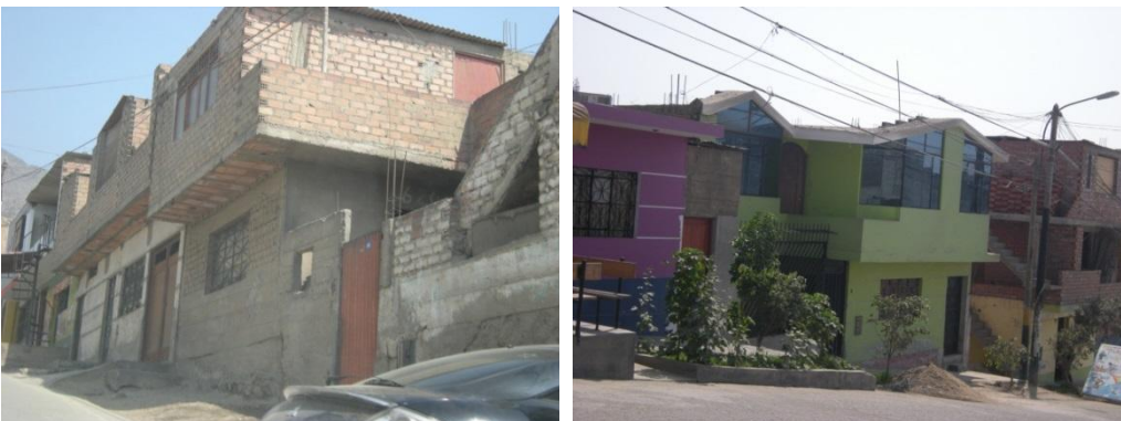
Figura 34. Edificaciones del sector 10, de dos pisos de techo aligerado y cobertura ligera.
