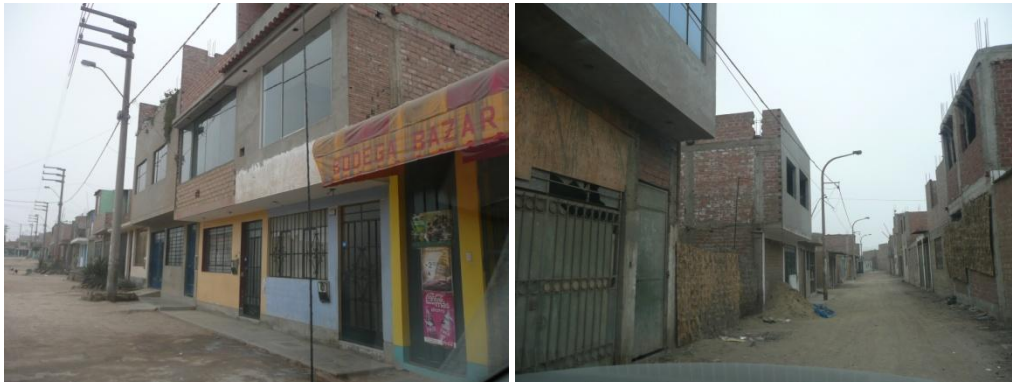
Figura 46. Viviendas típicas del Sector 14.
