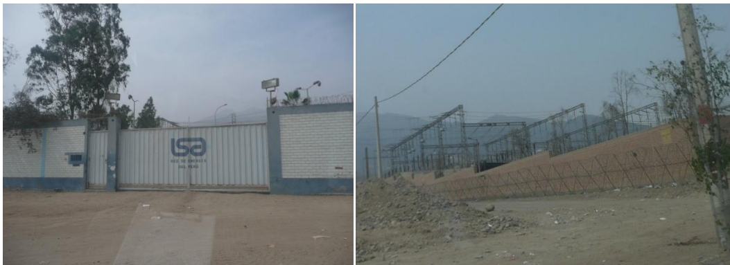
Figura 161. Red de Energía del Perú.
