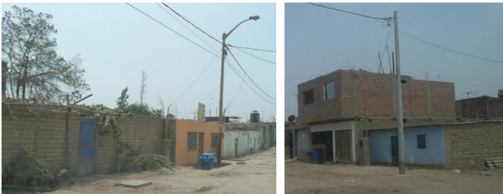
Figura 67. Viviendas de albañilería informal.
