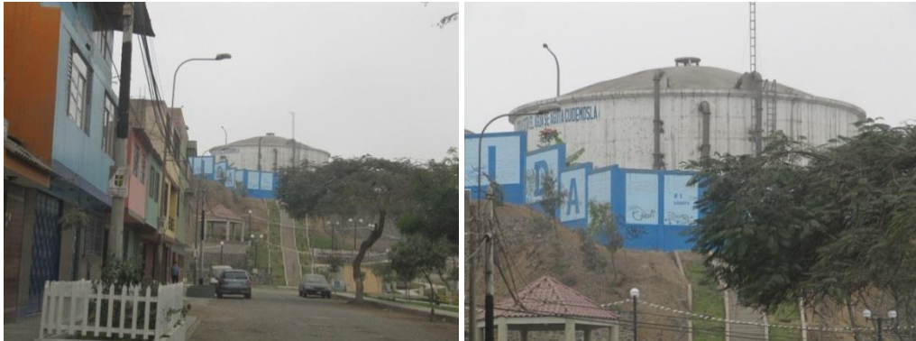
Figura 91. Tanque de Agua.
