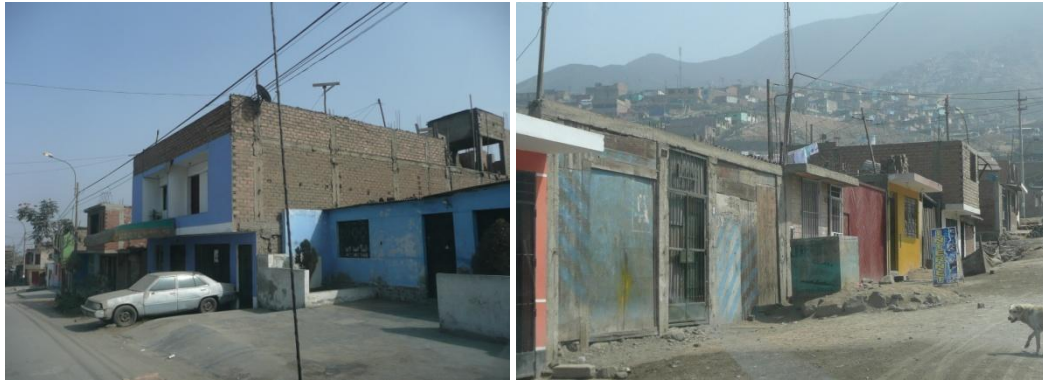
Figura 40. Viviendas típicas del Sector 12.
