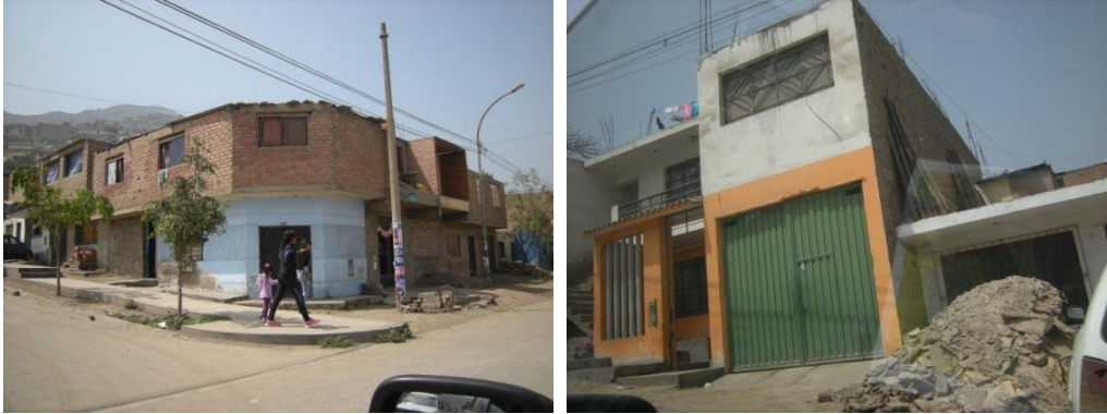
Figura 37. Edificaciones del sector 11, de dos niveles de techo aligerado y cobertura ligera.
