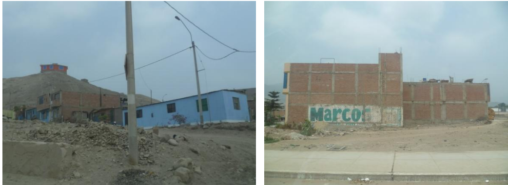
Figura 68. Viviendas típicas del Sector 28.
