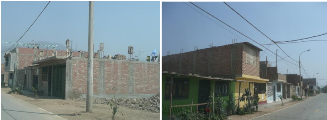
Figura 50. Viviendas típicas del Sector 17.
