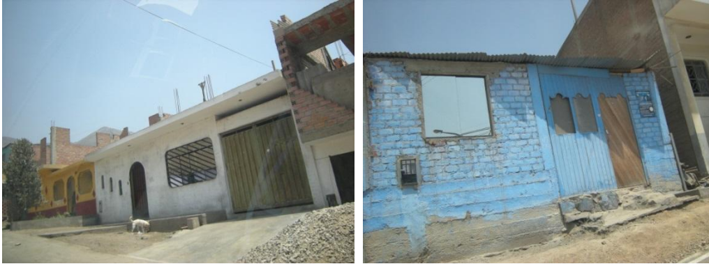
Figura 35. Edificaciones de un piso de techo aligerado y cobertura ligera.
