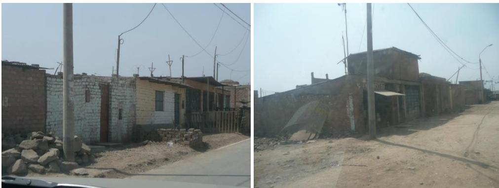
Figura 51. Viviendas informales en albañilería.
