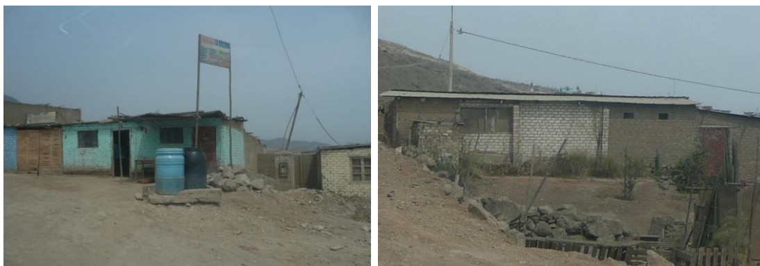
Figura 65. Viviendas de albañilería informal y adobe.
