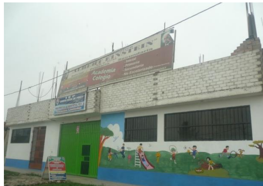
Figura 145. I.E.I. Santa Rosa de Ponte.
