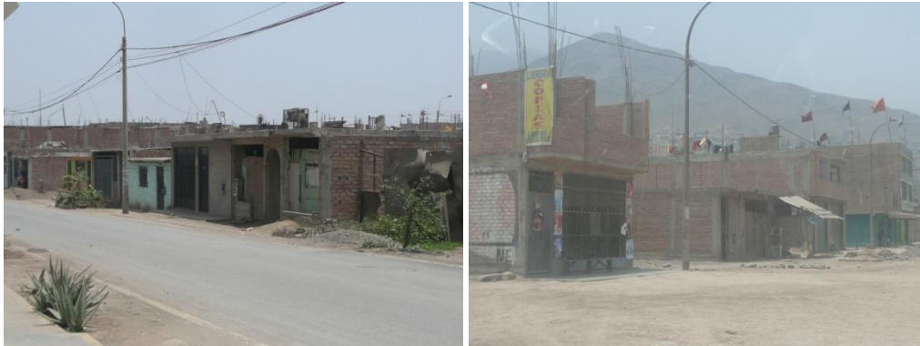
Figura 54. Viviendas típicas del Sector 19.
