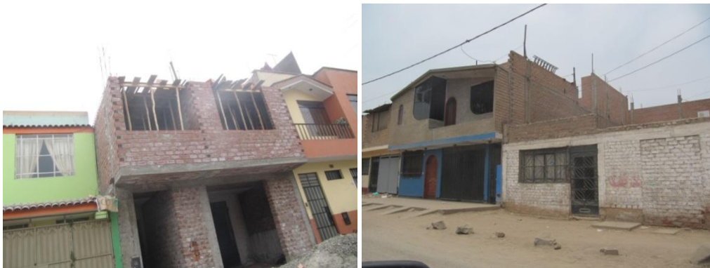
Figura 21. Uso de ladrillo artesanal y tubular en los muros de algunas edificaciones del sector 4.
