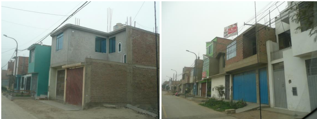
Figura 23. Viviendas típicas del Sector 05.
