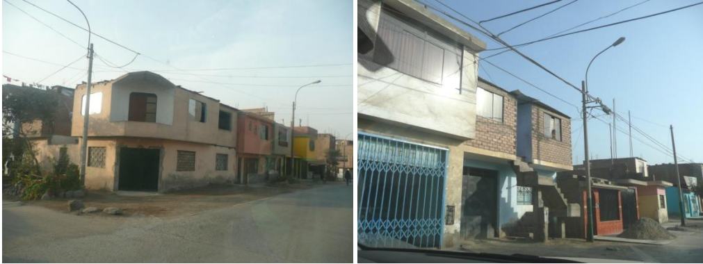
Figura 49. Viviendas típicas del Sector 16.
