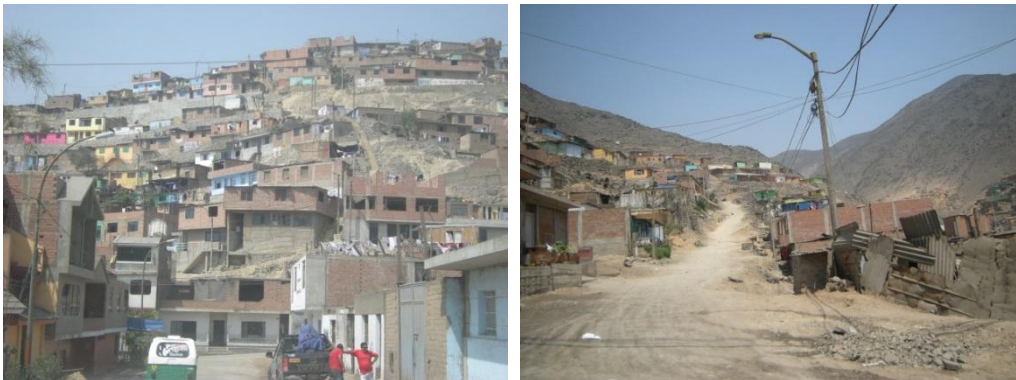
Figura 36. Viviendas en zonas de pendiente elevada y en quebradas.
