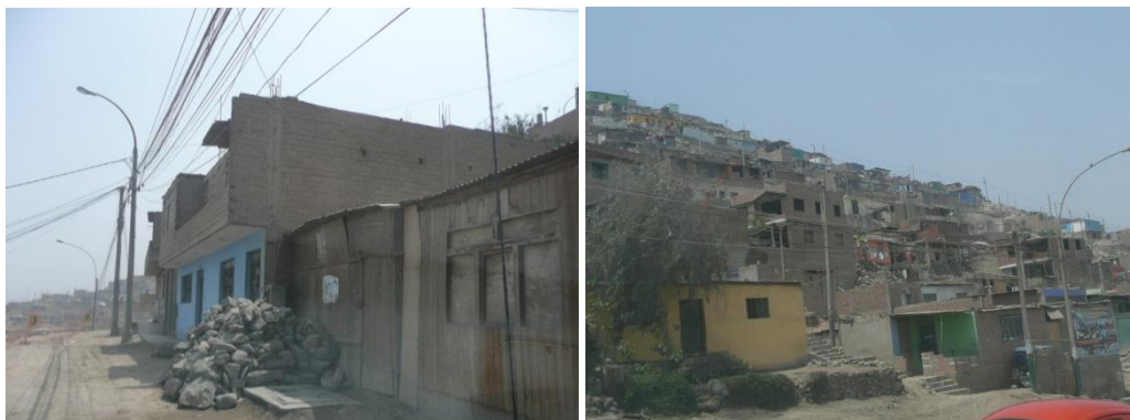
Figura 56. Viviendas típicas del Sector 20.
