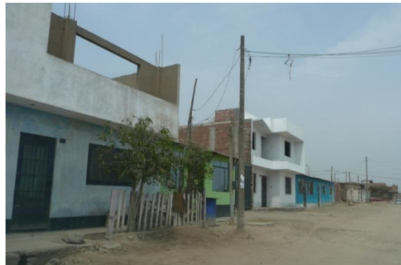
Figura 62. Viviendas típicas del Sector 24.
