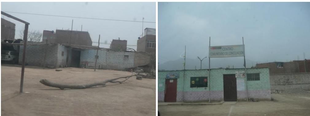
Figura 29. Viviendas de adobe y construcciones informales en albañilería.
