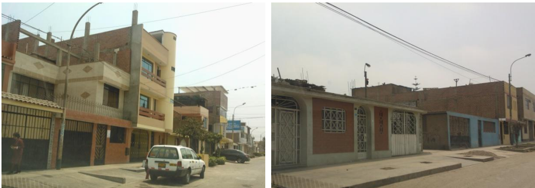
Figura 12. Viviendas típicas del Sector 01.
