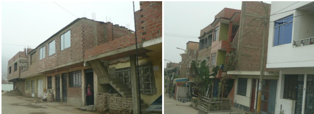
Figura 43. Viviendas típicas del Sector 13.
