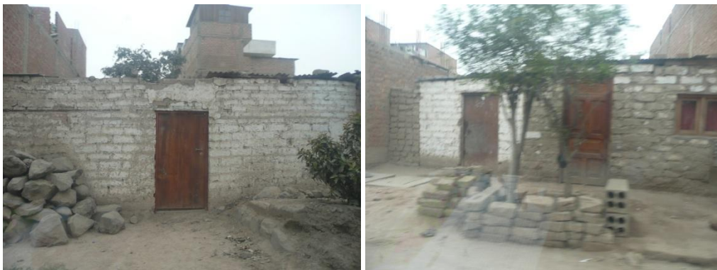
Figura 44. Viviendas de adobe.
