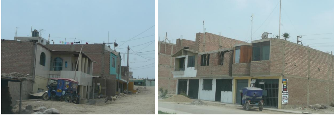
Figura 66. Viviendas típicas del Sector 27.
