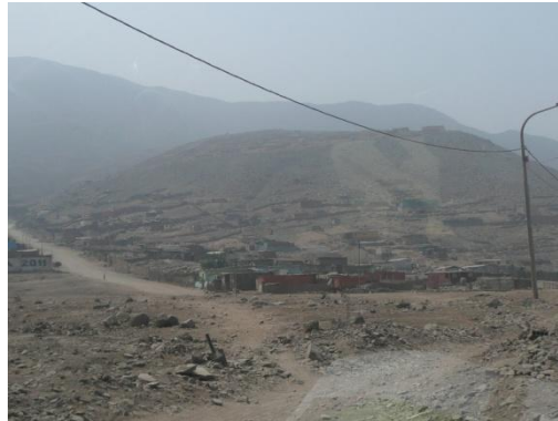
Figura 59. Viviendas en albañilería informal en laderas.
