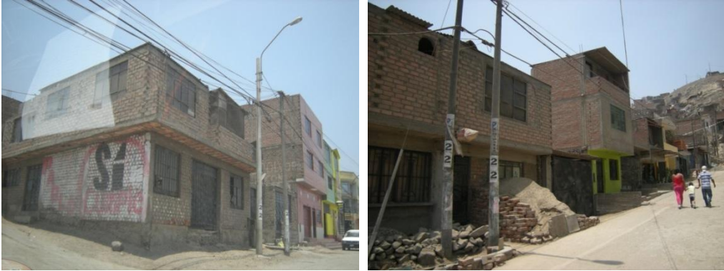
Figura 32. Edificaciones con cobertura ligera.
