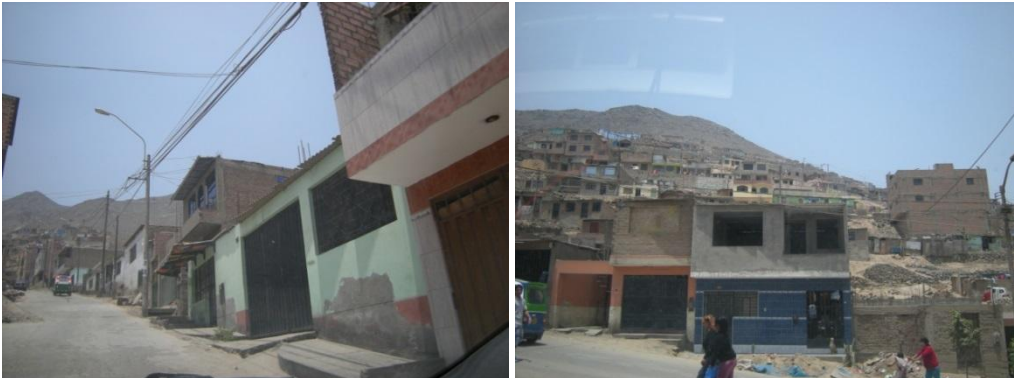
Figura 33. Viviendas en zonas de pendiente elevada.
