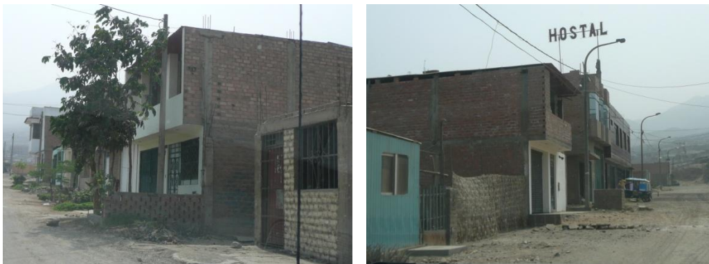
Figura 58. Viviendas típicas del Sector 21.
