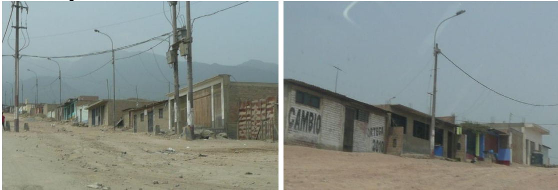
Figura 64. Viviendas típicas del Sector 25.
