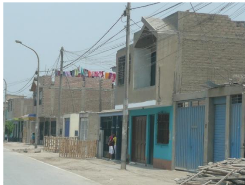
Figura 60. Viviendas típicas del Sector 22.
