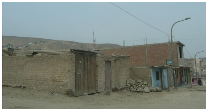
Figura 63. Viviendas de albañilería informal.
