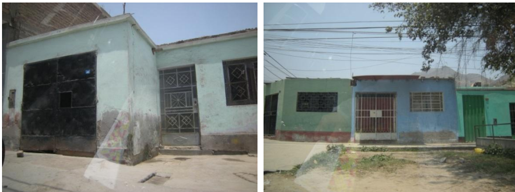
Figura 31. Edificaciones del sector 9, de albañilería.
