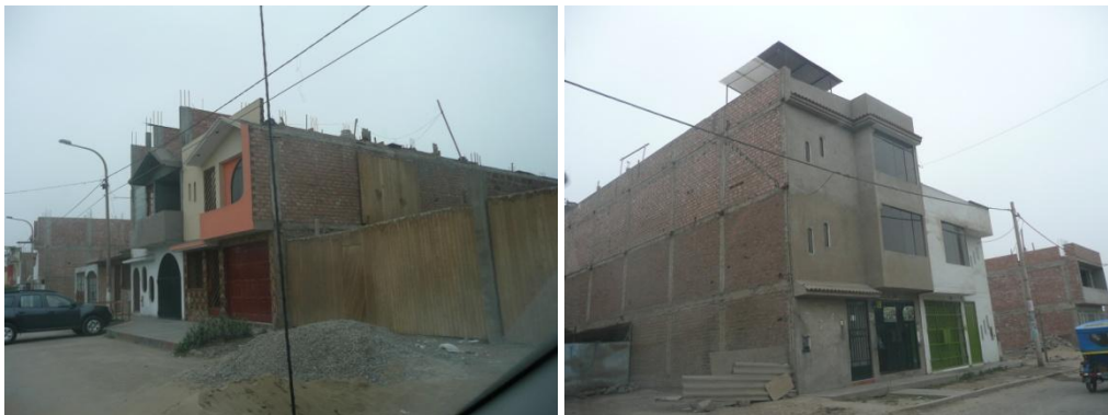
Figura 26. Viviendas típicas del Sector 07.
