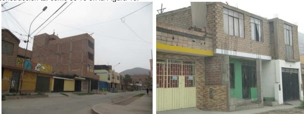
Figura 15. Viviendas sin tarrajeo del sector 2.
