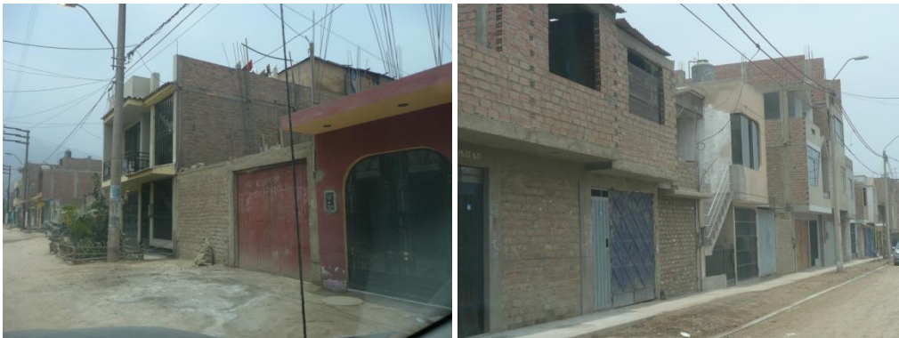
Figura 28. Viviendas típicas del Sector 08.
