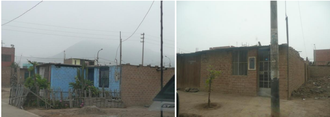
Figura 47. Viviendas informales de albañilería.
