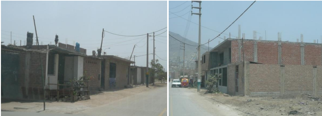
Figura 52. Viviendas típicas del Sector 18.
