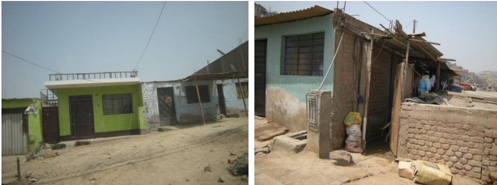
Figura 38. Edificaciones de un piso de techo aligerado y cobertura ligera.
