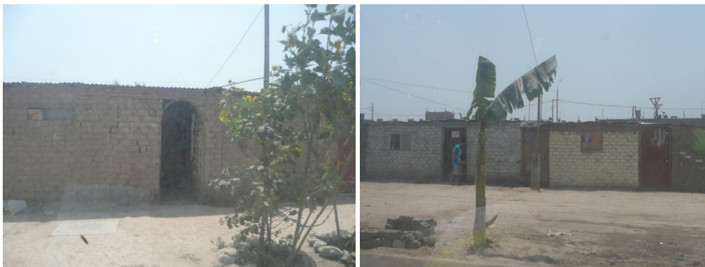
Figura 53. Viviendas de adobe y albañilería informal.
