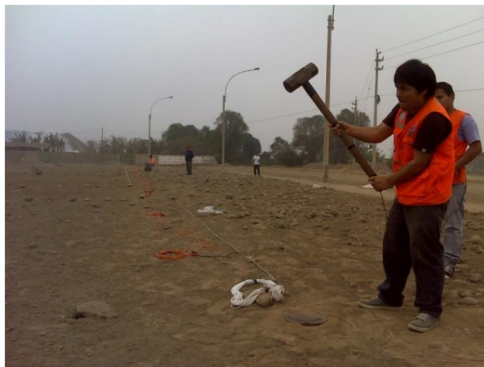
Figura 7.4. Golpe para generar ondas durante ensayo MASW y refracción sísmica.
