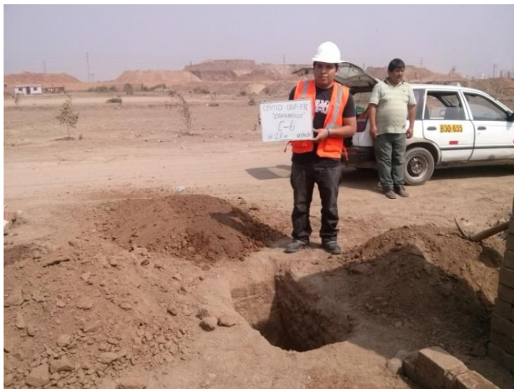
Figura 7.1. Excavación de calicatas en el distrito de Carabayllo
