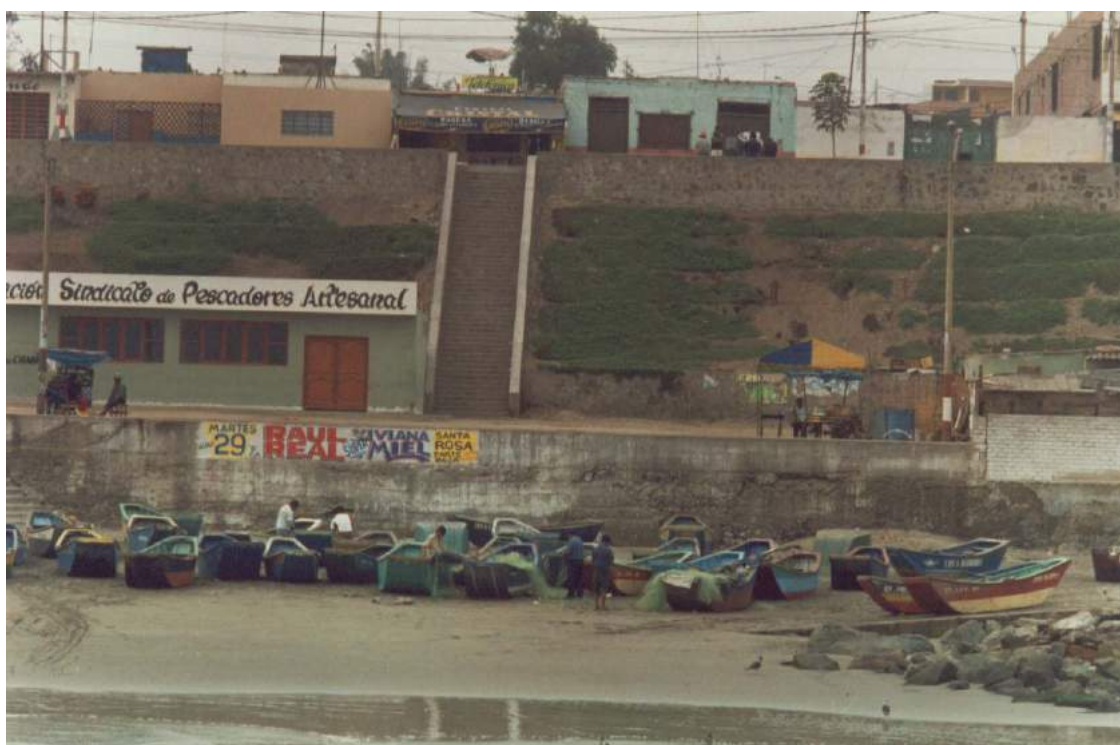
Foto 22: Talud estabilizado en el acantilado de la playa del Puerto Chancay.
