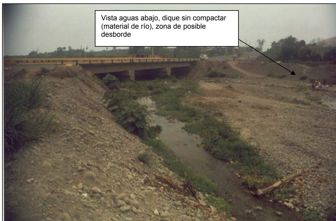
Foto 25: Lecho del río Chancay altura Puente Carretera Panamericana Norte.
