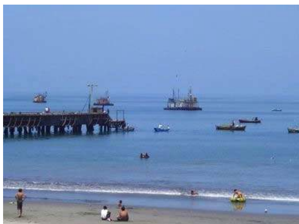
Foto 08: Muelle Puerto Chancay
