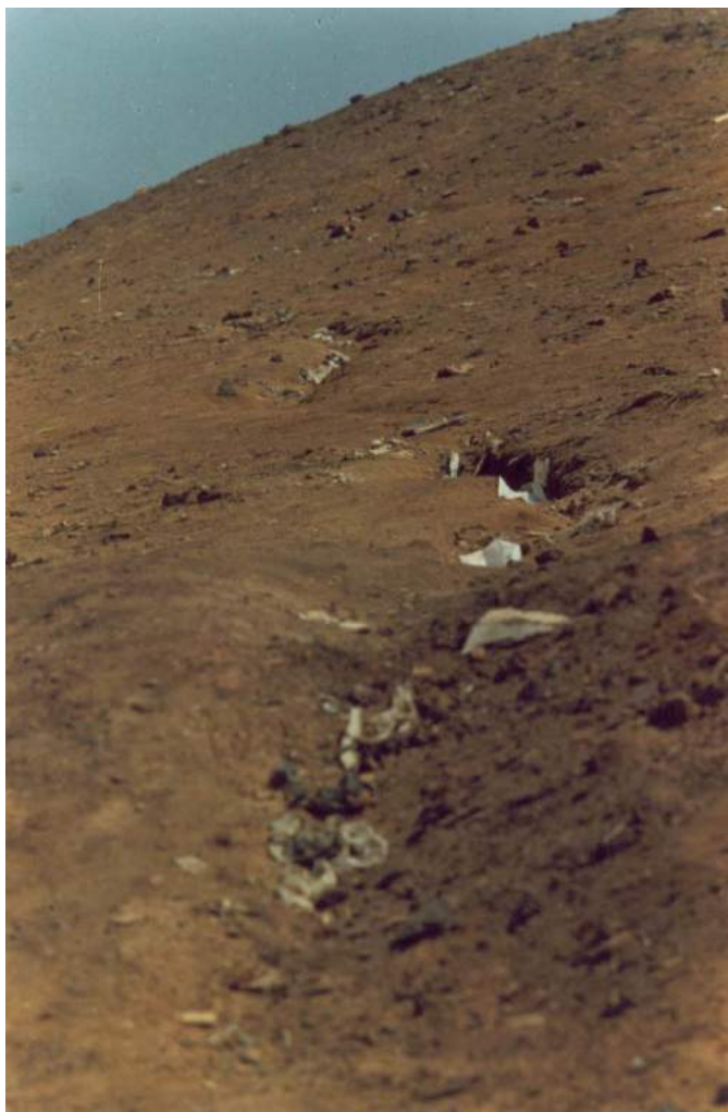
Foto 18: Traza de la falla en el cerro Vista Alegre, que podría ser la causante de la destrucción de las viviendas en el AA.HH. Atalaya.
