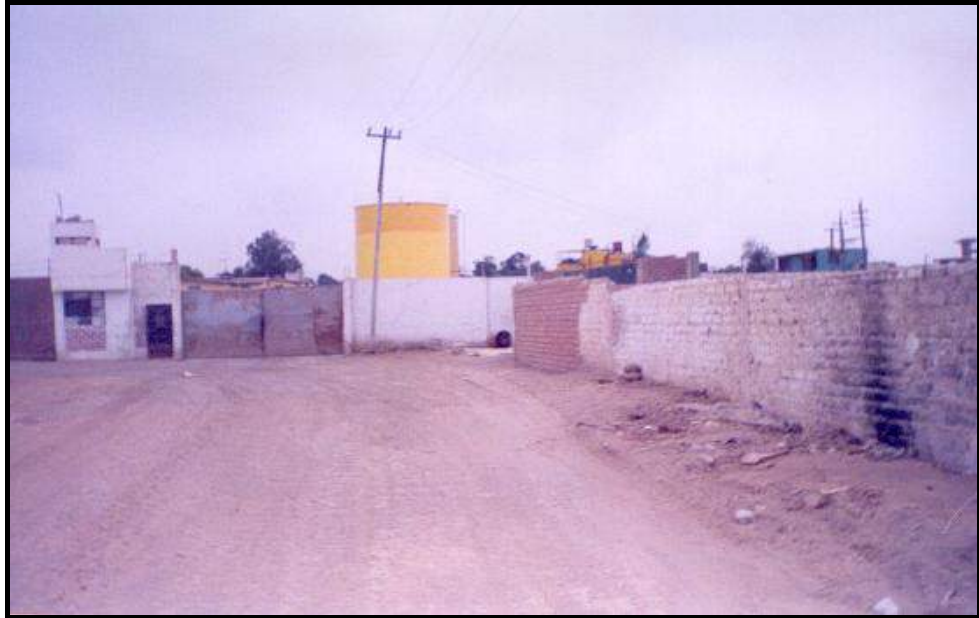
Foto 31: Frontis de planta de tratamiento de aceites comestibles de R y R. Oil Internacional donde se aprecia los tanques de almacenamiento de aceite.
