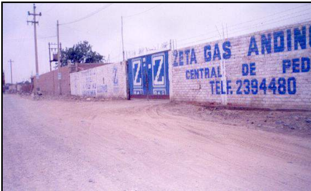
Foto 29: Depósito de Gas Licuado de Petróleo en el Distrito de Santa María
