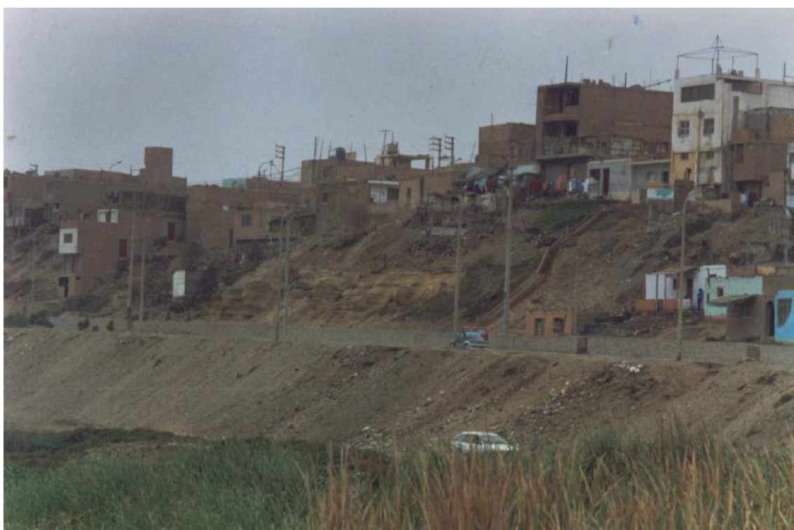
Foto 13: Taludes inestables en el acantilado de la playa que comprometen parcialmente la seguridad de las viviendas.
