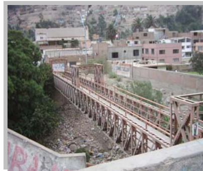
Puente peatonal sobre río Rímac
