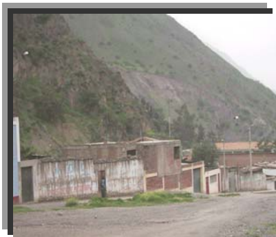
Corte de talud (Sector Cercado Alto)
