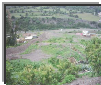
Cauce de Cárcava Mayor Huaripachi ocupado por viviendas
