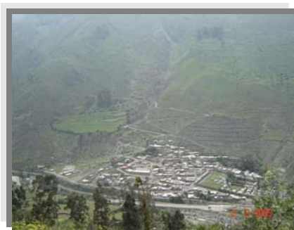
Quebrada Huaripachi (Cono Deyectivo)
