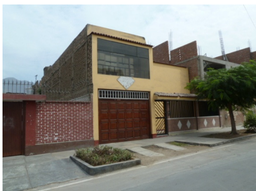
Figura 75. Lote de mampostería confinada con unidades de albañilería amarradas en soga y confinadas por medio de columnas y vigas.
