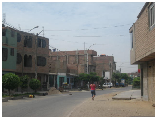
Figura 57. Viviendas de 3 niveles típicas del sector 18.
