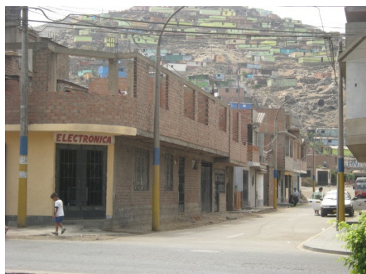
Figura 127. Viviendas en laderas del cerro en sector 41.
