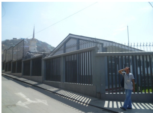
Figura 437. Vista de la "Iglesia de Jesucristo de los Santos de los últimos días".
