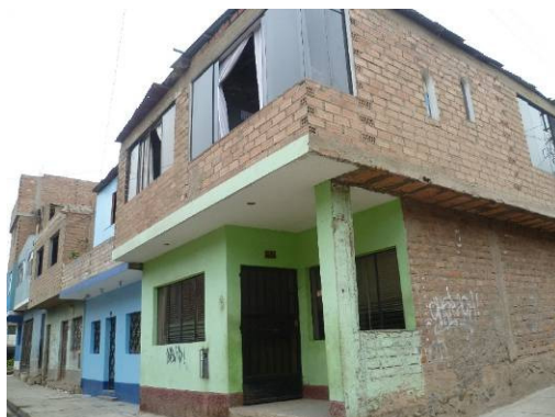
Figura 97. Vivienda típica con losa aligerada en buen estado de conservación
