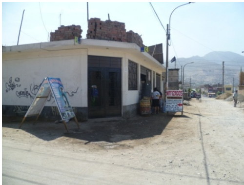
Figura 143. Vivienda de 1 nivel de albañilería confinada con techo aligerado y muros de ladrillo artesanal sólido con tarrajeo.
