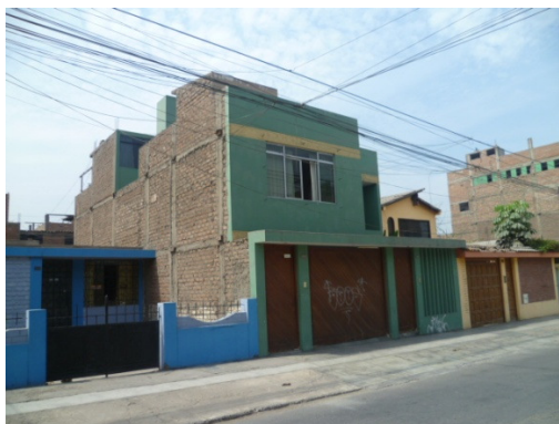
Figura 13. Lote de mampostería confinada con unidades de albañilería amarradas en soga y confinadas por medio de columnas y vigas.
