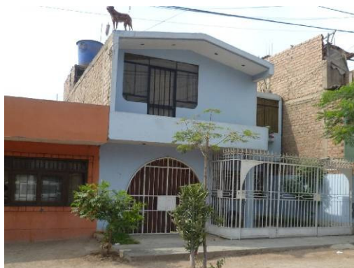
Figura 54. Vivienda típica con losa aligerada en buen estado de conservación
