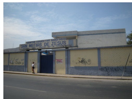
Figura 185. Vista del colegio “San Matías de Jesús”
