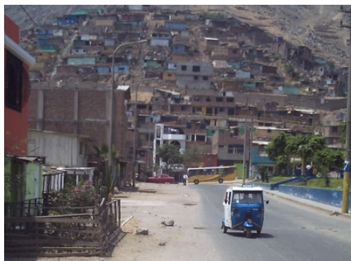
Figura 141. Vista de lotes ubicados en el cerro
