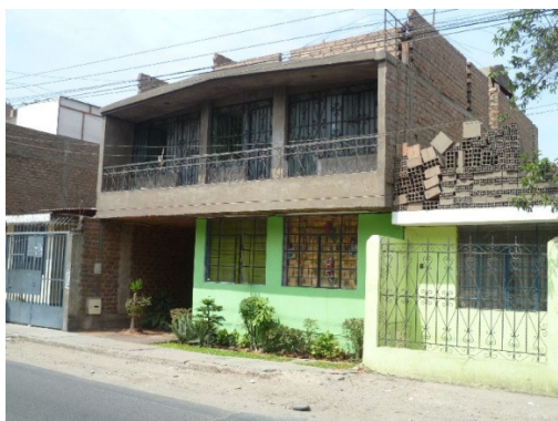
Figura 19. Vivienda de albañilería confinada de 2 niveles del sector 03.
