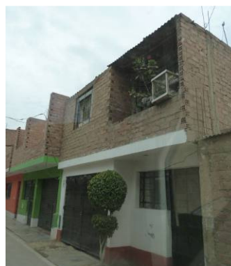
Figura 105. Vivienda típica con cobertura ligera en regular estado de conservación
