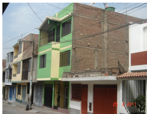
Figura 110. Vista de una vivienda de albañilería confinada de 3 niveles-sector 36.
