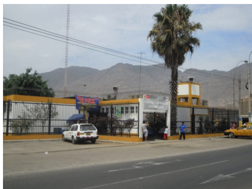
Figura 364. Vista del centro de salud "Ganimedes".
