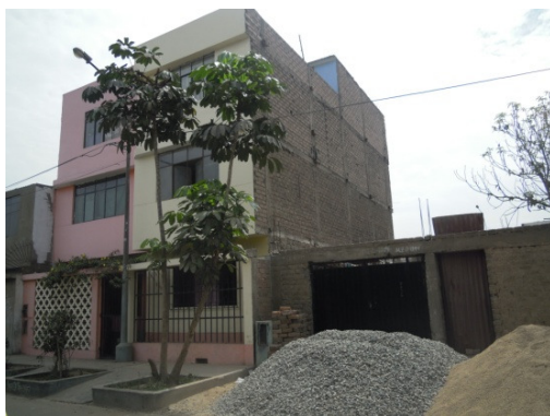
Figura 68. Vista de una vivienda de albañilería confinada-sector 23.
