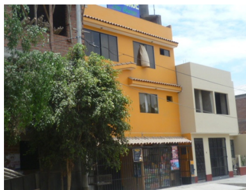
Figura 59. Vivienda de albañilería confinada de 2 y 3 niveles-sector 19.
