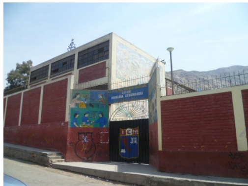
Figura 436. Vista de una edificación esencial, colegio “Independencia Americana”.
