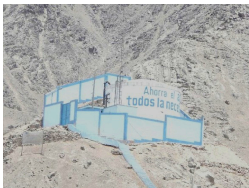
Figura 382. Tanque de agua apoyado.
