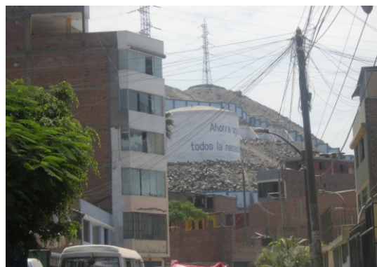
Figura 191. Vista de tanque de agua
