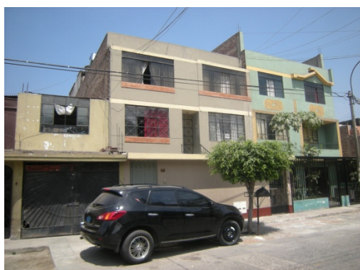
Figura 23. Vista de una vivienda de albañilería confinada
