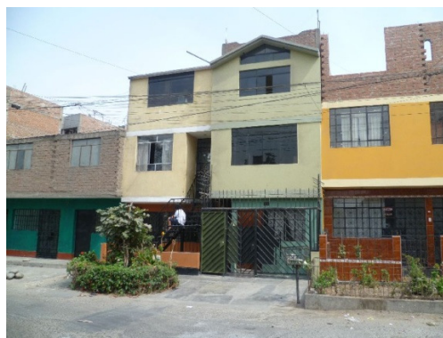
Figura 20. Vivienda de albañilería confinada de 3 niveles del sector 03.
