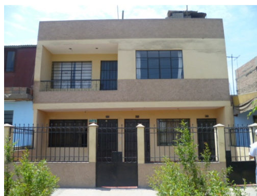
Figura 35. Vista de otra de las edificaciones representativas, en este caso se trata de una vivienda unifamiliar de dos niveles con techo aligerado y tarrajado
