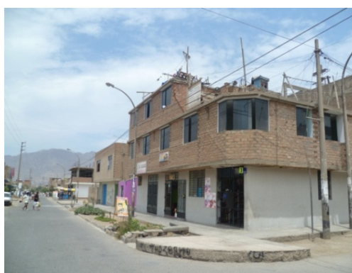
Figura 82. Vivienda informal de 2 niveles de mampostería confinada, con techo aligerado y muros de ladrillo pandereta.
