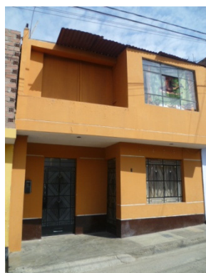
Figura 88. Vista de uno de los lotes representativos, en este caso es una vivienda unifamiliar de dos niveles con techo de calamina y tarrajado.
