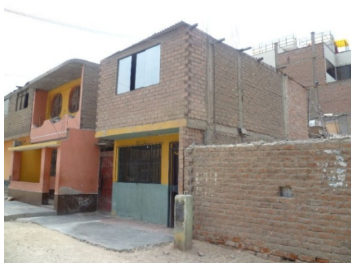
Figura 107. Vivienda de 2 niveles de albañilería confinada con techo de cobertura ligera y muros de ladrillo pandereta (volado) y sólido (resto de paredes).
