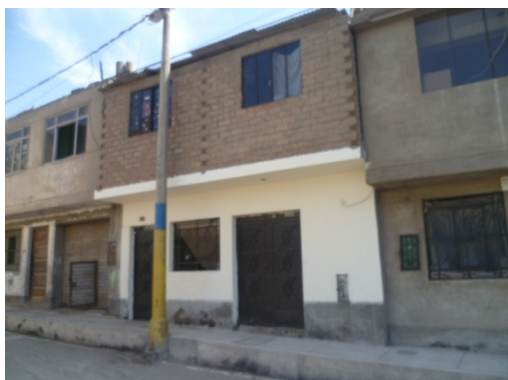
Figura 99. Vista de una edificación representativa que es una vivienda unifamiliar de dos niveles con un techo ligero.
