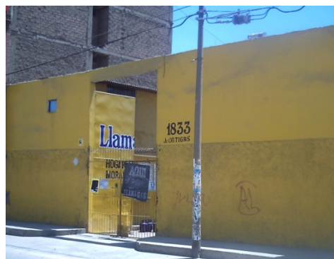
Figura 284. Deposito de material inflamable "Llamagas".
