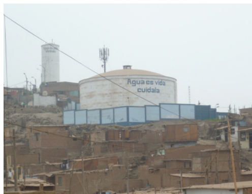
Figura 213. Reservorio de Agua de SEDAPAL
