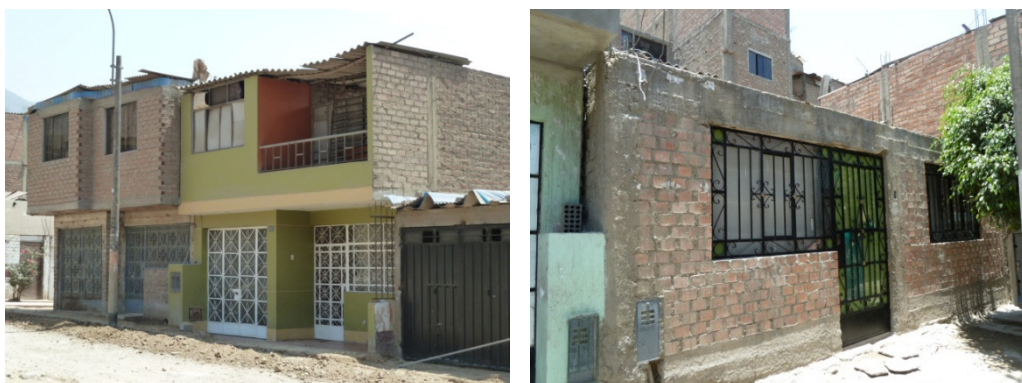
Figura 25. Vivienda de albañilería confinada de 1 y 2 niveles del sector 05
