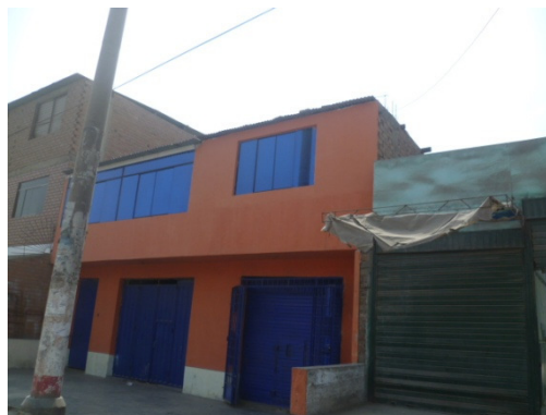
Figura 151. Viviendas sin diafragma rígido en el techo
