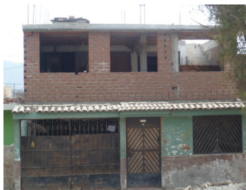
Figura 11. Viviendas construidas con ladrillo pandereta-sector 01.
