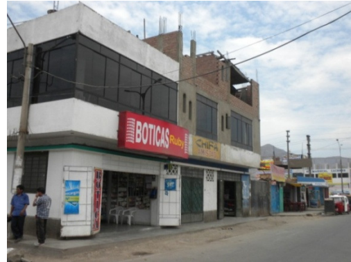
Figura 84. Construcción típica de vivienda y comercio-sector 28.
