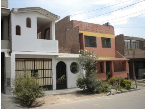
Figura 83. Vivienda de 2 niveles de mampostería confinada con diafragma rígido-sector 28.
