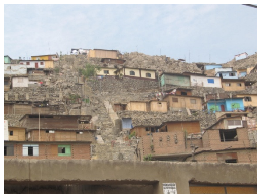
Figura 115. Informalidad en la construcción de viviendas y muros de contención en sector 38.
