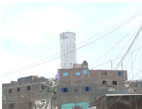
Figura 383. Tanque de agua elevado.
