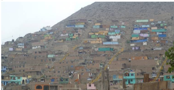
Figura 74. Construcciones informales de madera
