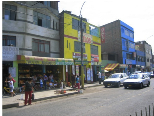
Figura 43. Viviendas Comercio construidas con ladrillos pandereta
