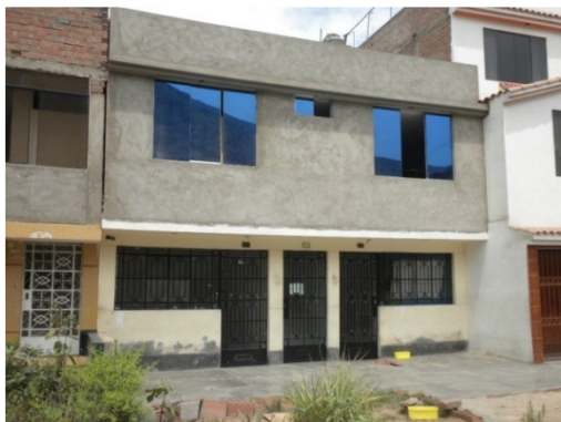
Figura 52. Vivienda de 2 niveles de mampostería confinada-sector16.
