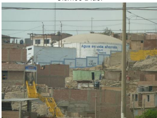
Figura 453. Reservorio de agua.
