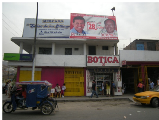
Figura 126. Construcción típica de vivienda y comercio-sector 41.
