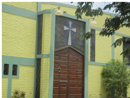
Figura 366. Vista de la iglesia "Cristo Vencedor".
