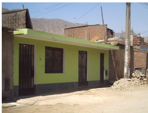
Figura 140. Vista de una vivienda de albañilería confinada con diafragma rígido de 1 nivel.
