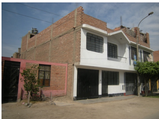
Figura 125. Vivienda de 2 niveles de mampostería confinada tarrajada con techo de cobertura rígida.
