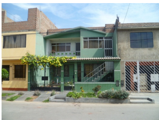
Figura 34. Vista de una de las edificaciones representativas que es una vivienda unifamiliar de dos niveles con losa aligerada
