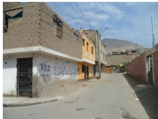
Figura 93. Vista de la pendiente suave del terreno, en general la zona se encuentra pavimentada.
