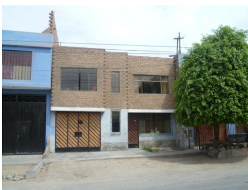
Figura 81. Vivienda de 2 niveles de albañilería confinada con techo aligerado y muros de ladrillo pandereta en todo el segundo nivel.
