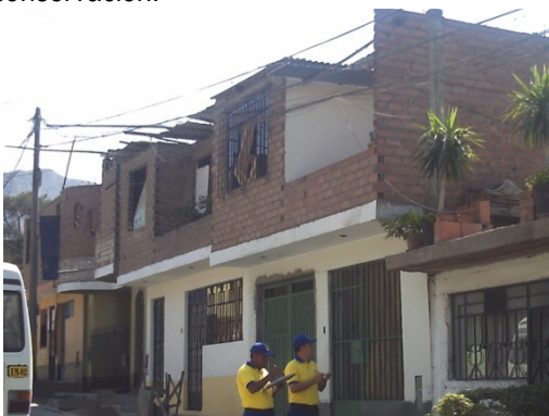
Figura 139. Vista de una vivienda de albañilería confinada con diafragma flexible de 2 niveles.
