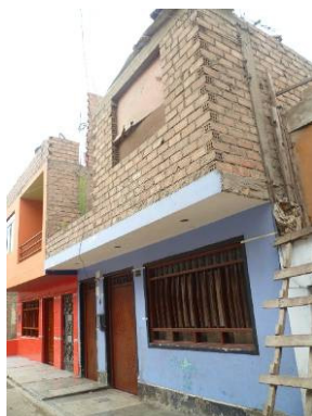
Figura 135. Vivienda típica con losa aligerada en buen estado de conservación
