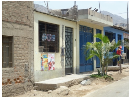
Figura 144. Vivienda informal de 1 nivel de mampostería confinada, con techo calamina y muros de ladrillo artesanal sólido.
