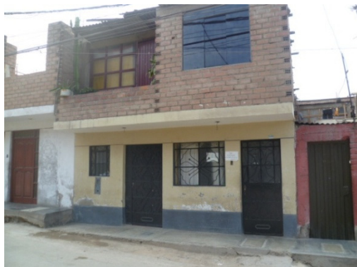
Figura 94. Viviendas típicas del sector 31, con cobertura ligera
