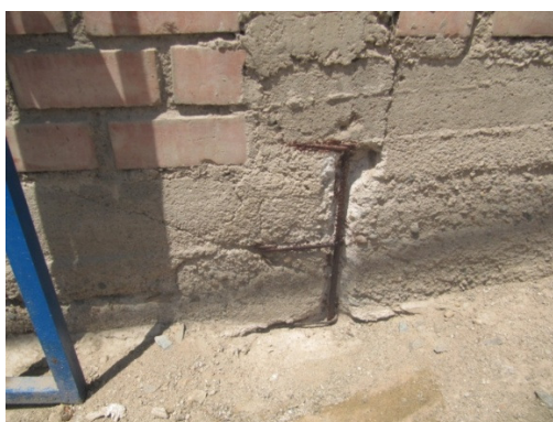
Figura 119. Acero expuesto
