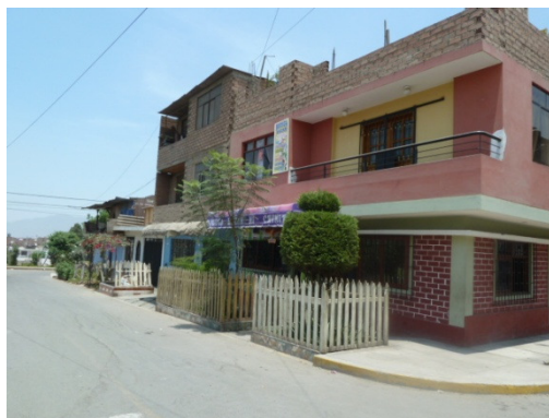
Figura 131. Vivienda de dos pisos con ladrillo “pandereta-sector 42.
