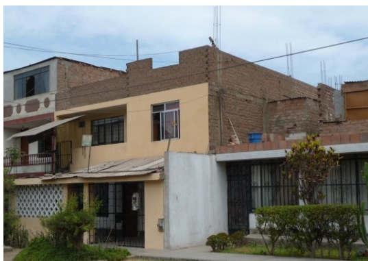
Figura 77. Vivienda hecha a base de ladrillos de arcilla sólidos fabricados de forma artesanal.
