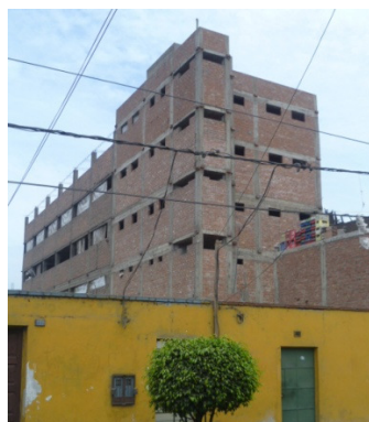
Figura 16. Muros de ladrillos tubulares en su sistema estructural a partir del segundo piso.
