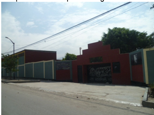
Figura 427. Vista de Colegio Estatal en el sector en estudio.
