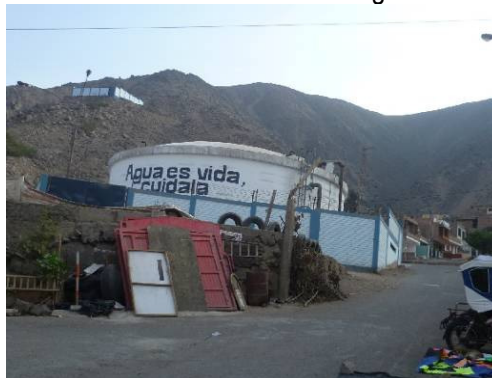
Figura 271. Reservorio de agua.
