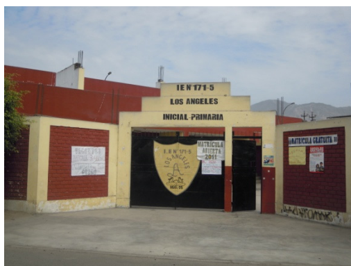
Figura 357. Vista de la I.E. “Los Ángeles”.
