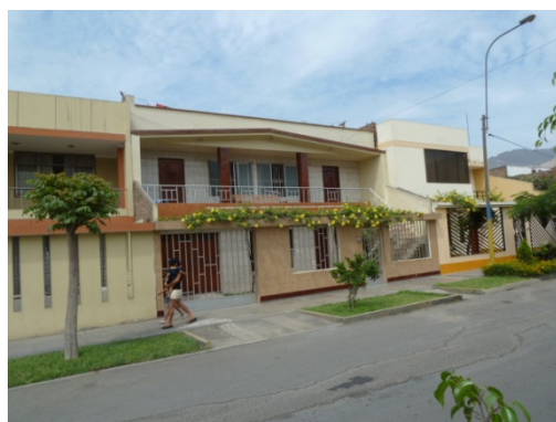
Figura 76. Lote representativo del Sector 26 en buen estado de conservación.
