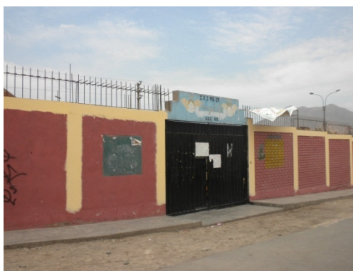
Figura 465. Vista del colegio I.E.I. 115-29 "Los Angelitos".
