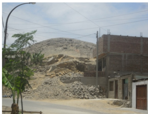
Figura 69. Vista de una vivienda adyacente al cerro.
