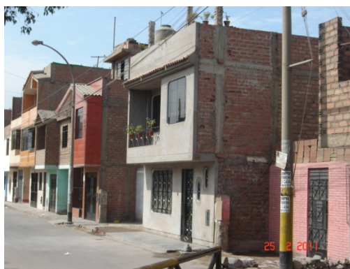
Figura 109. Vista de una vivienda de albañilería confinada de 2 niveles-sector 36.
