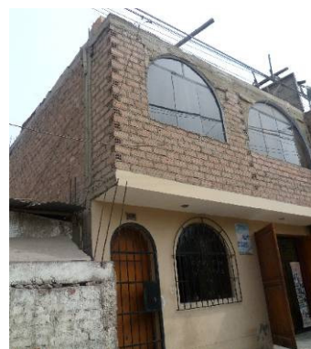
Figura 73. Vivienda de mampostería confinada
