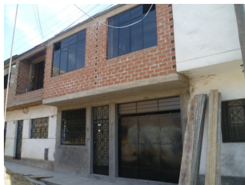
Figura 100. Vista de otra edificación representativa, una vivienda unifamiliar de dos niveles con una cobertura ligera como techo.
