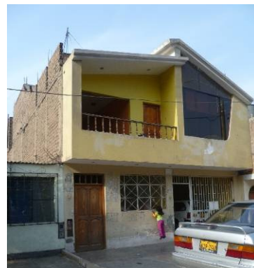
Figura 45. Vivienda mampostería confinada
