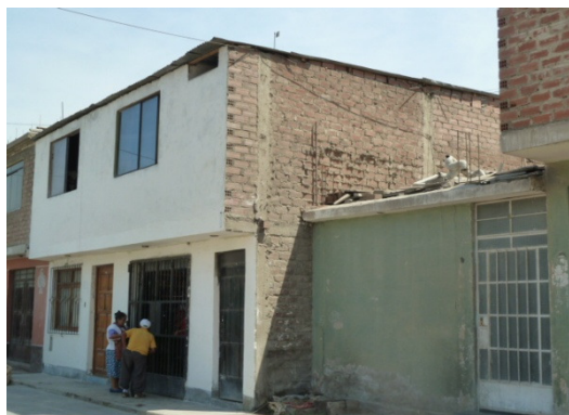
Figura 130. Vivienda Típica del Sector 42.
