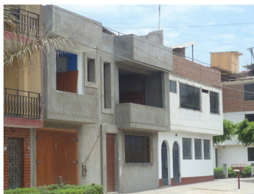
Figura 59. Vivienda de albañilería confinada de 2 y 3 niveles-sector 19.
