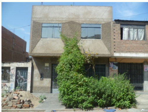
Figura 137. Vivienda de 2 pisos de mampostería confinada, con muros tarrajeados.
