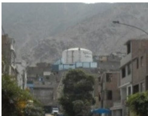
Figura 297. Reservorio de agua potable.
