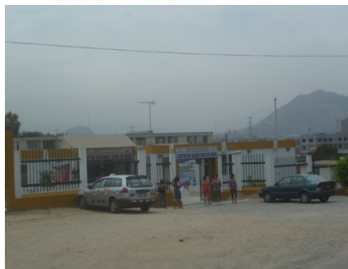
Figura 161. Centro de Salud Caja de Agua - MINSA
