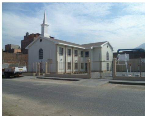
Figura 221. Vista de "Iglesia de Jesucristo de los Santos de los Últimos Días"
