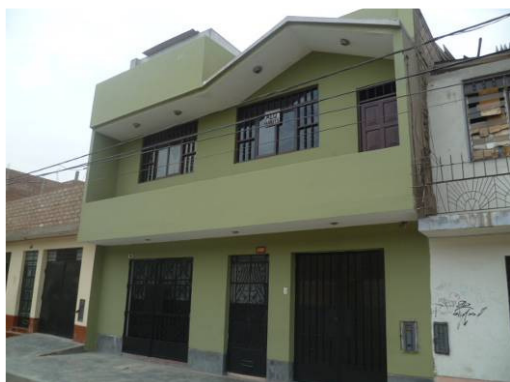
Figura 104. Vivienda típica con losa aligerada en buen estado de conservación
