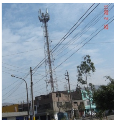
Figura 471. Vista de una antena de telecomunicación auto-soportada
