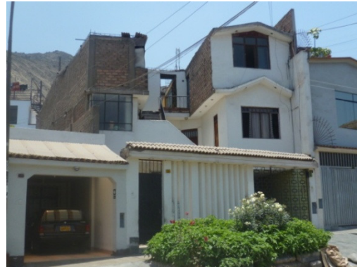
Figura 31. Vivienda de 3 pisos de mampostería confinada con techo de diafragma rígido, que ha sido construida de manera informal.
