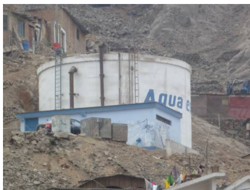
Figura 393. Reservorio de agua.
