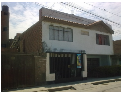
Figura 47. Edificaciones Típicas del Sector 14
