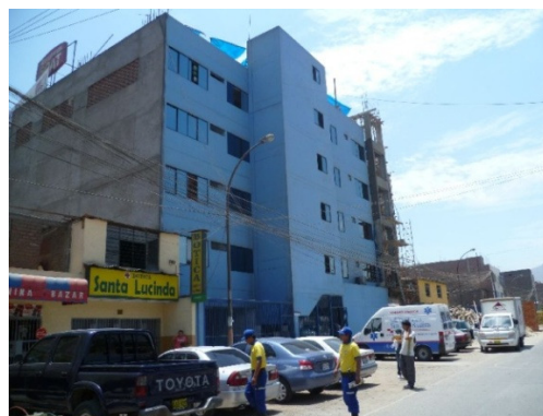
Figura 286. Hospital San Juan Bautista.
