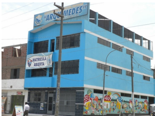
Figura 468. Vista del Colegio "Arquímedes".
