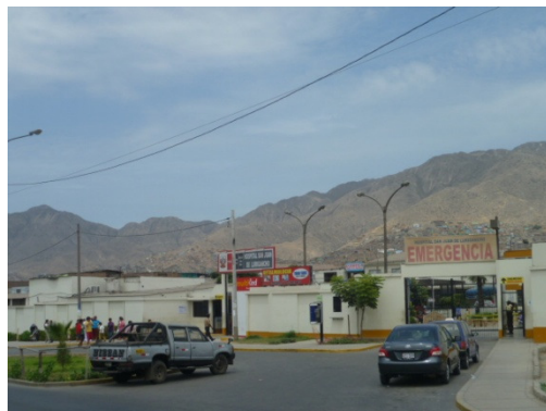
Figura 428. Vista de edificación esencial, Hospital “San Juan de Lurigancho”.
