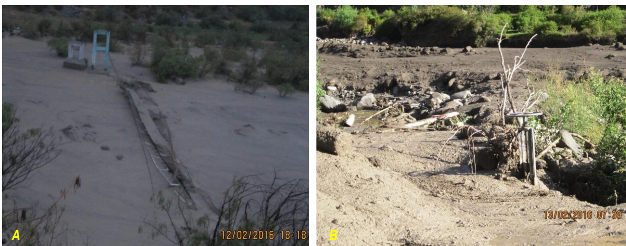
Figura 11. A: Destrucción del puente peatonal “Ánima” , en el sector Huarina, originado por el lahar emplazado el día 12 de febrero en el río Para; B: Destrucción de canales de agua en el sector Huatagua, causado por el mismo lahar.
