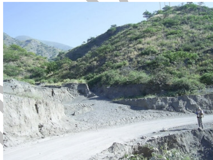
Quebradas por donde discurren huaycos y flujos de lodo de manera excepcional, afectan por tramos a la carretera Chilite-San Pablo.
