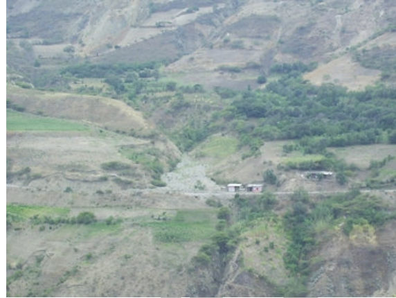
Quebrada por donde discurren huaycos de manera ocasional a periódica, afectan tramo de carretera, puede afectar vivienda asentada en la margen izquierda, Choropampa, Magdalena.
