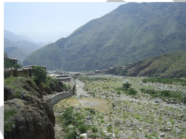
Vista aguas debajo del río Huertas, al fondo poblado de Chilete, se puede apreciar la gran cantidad de material en el cauce, se pueden producir huaycos de manera excepcional.
