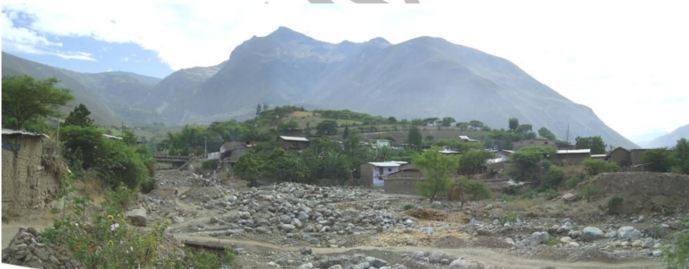
Vista aguas arriba de la quebrada Chilango-Magdalena, viviendas ubicadas muy cerca del cauce principal.
