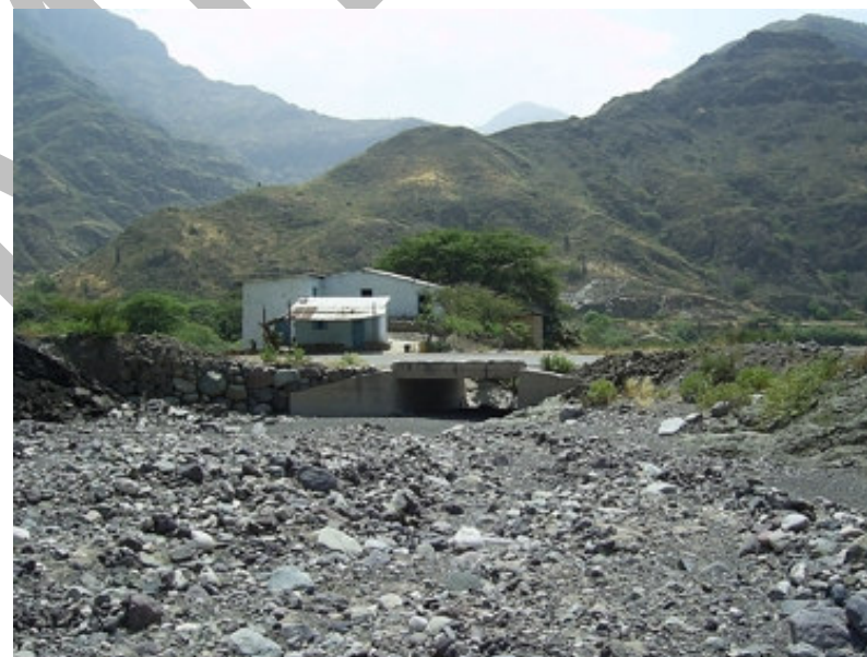
Vista de la quebrada Nazario, aguas abajos, se puede apreciar el material suelto en el cauce, Yonan, Cajamarca.
