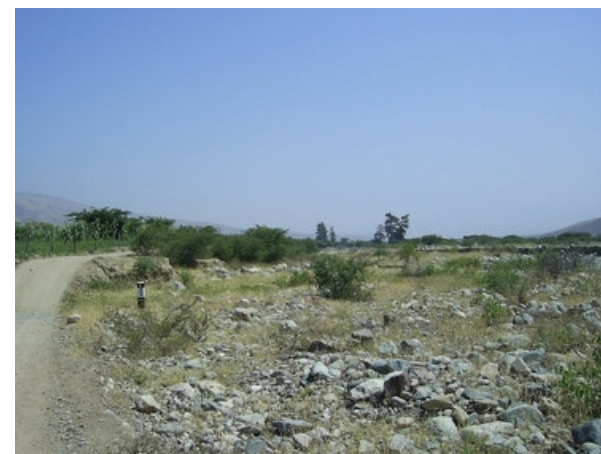
Sector el Mango afectado por erosión fluvial de manera excepcional, en la margen derecha del río San José, San Gregorio.
