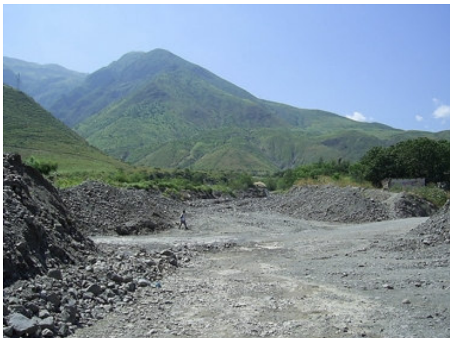
Vista de la quebrada Maramal, por donde discurren huaycos de manera ocasional a periódica, se ha colocado badén, sector Zapotal, San Bernardino, Cajamarca.
