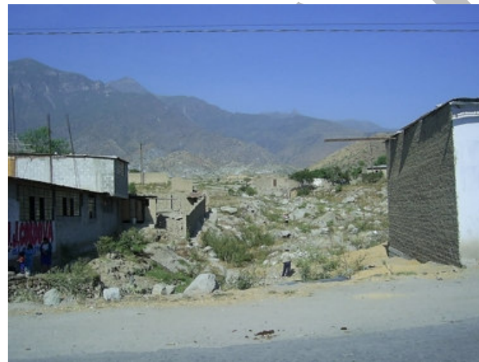
Quebrada Salitral, discurren huaycos de manera excepcional, viviendas se encuentran cerca del cauce, Tantarica, Cajamarca.
